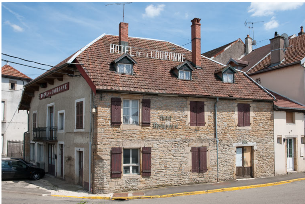
Façade antérieure et latérale droite.
