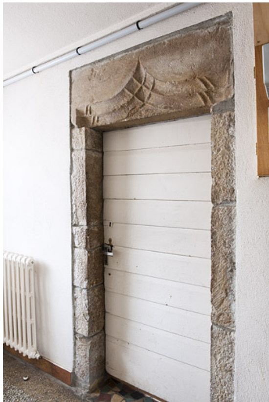
Intérieur : baie conduisant à l'ancienne grange.
