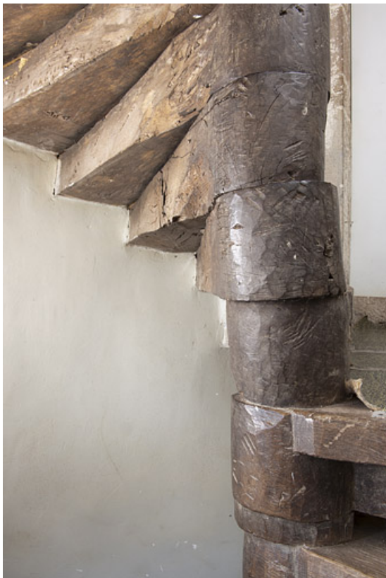
Intérieur : détail de l'escalier en vis menant à l'étage.
