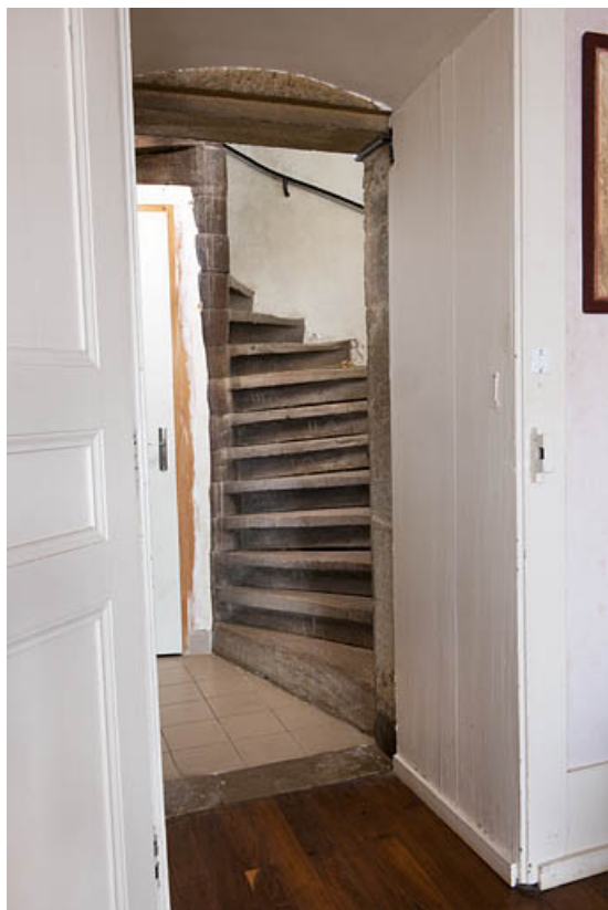
Intérieur : départ de l'escalier menant au 1er étage. 25, Rougemont, 2 quartier de la Citadelle
