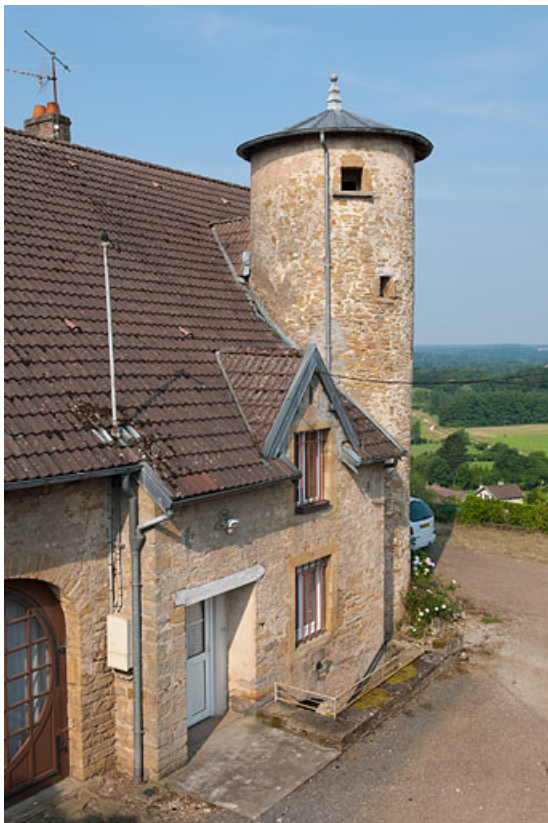
Vue de la tour hors oeuvre de la façade antérieure.
