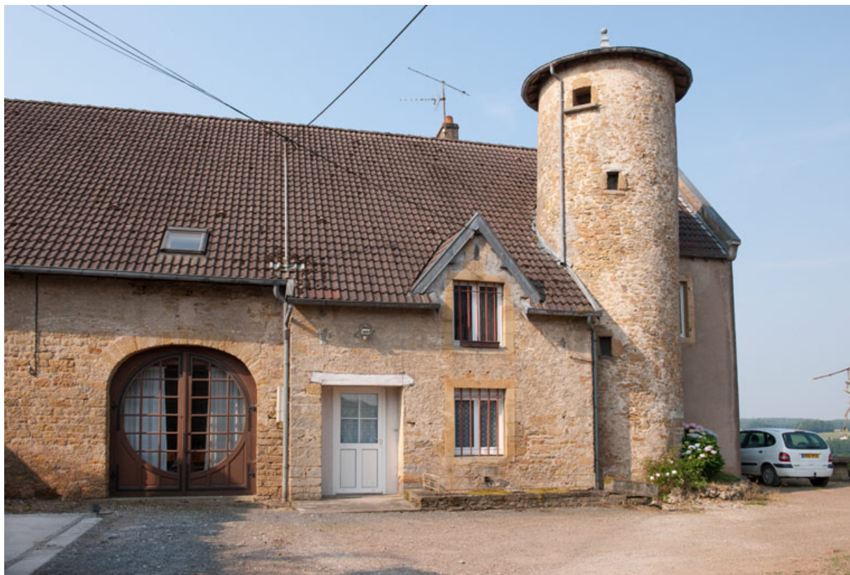
Façade antérieure vue de trois quart gauche.
