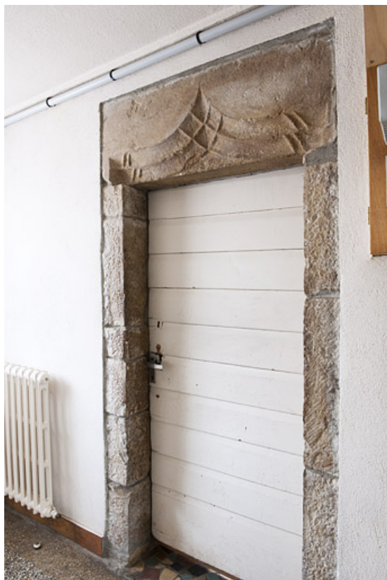
Intérieur : baie conduisant à l'ancienne grange.
