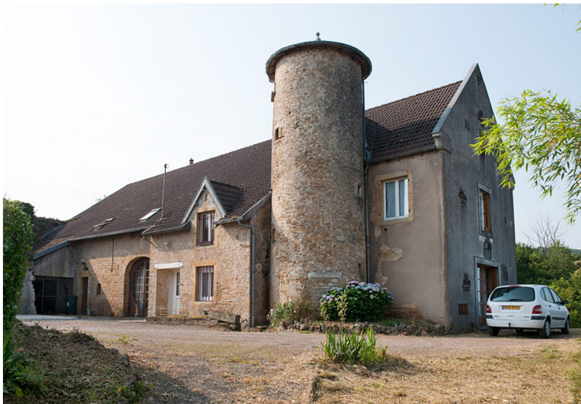
Façade antérieure, vue de trois quart droit.
