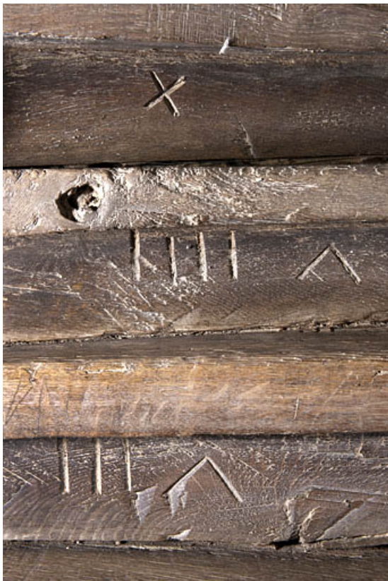
Intérieur : escalier en charpente meant à l'étage, détail des marches numérotées. 25, Rougemont, 2 quartier de la Citadelle
