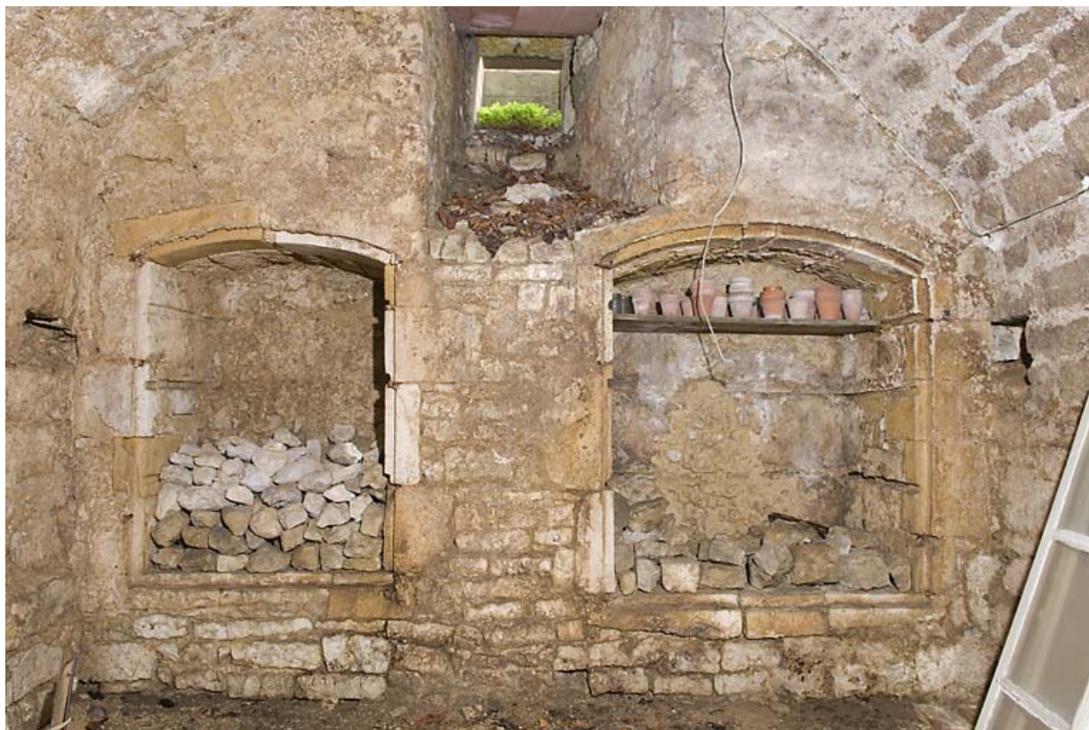
Deuxième cave voûtée : placards muraux. 25, Jougne
