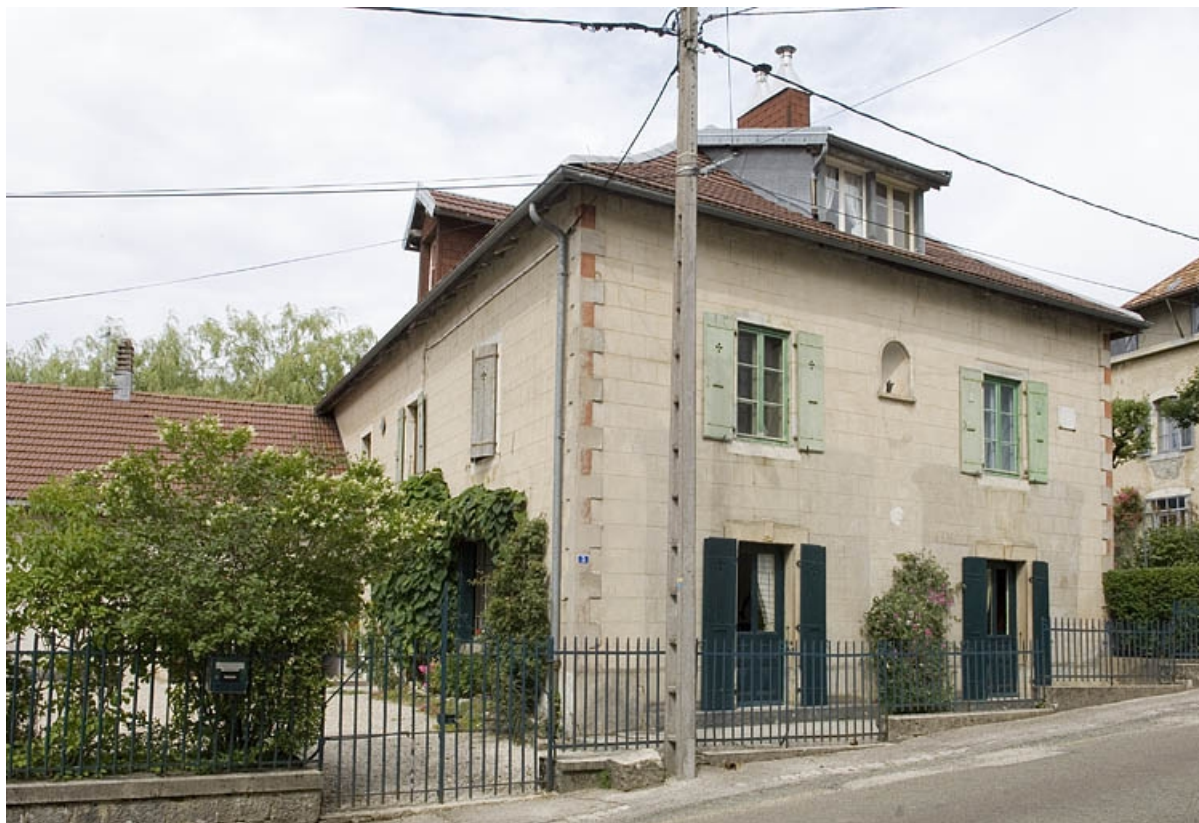
Façade antérieure et façade latérale gauche. 25, Jougne
