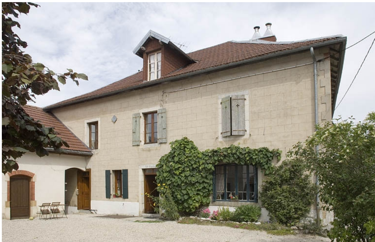
Élévation côté cour.
