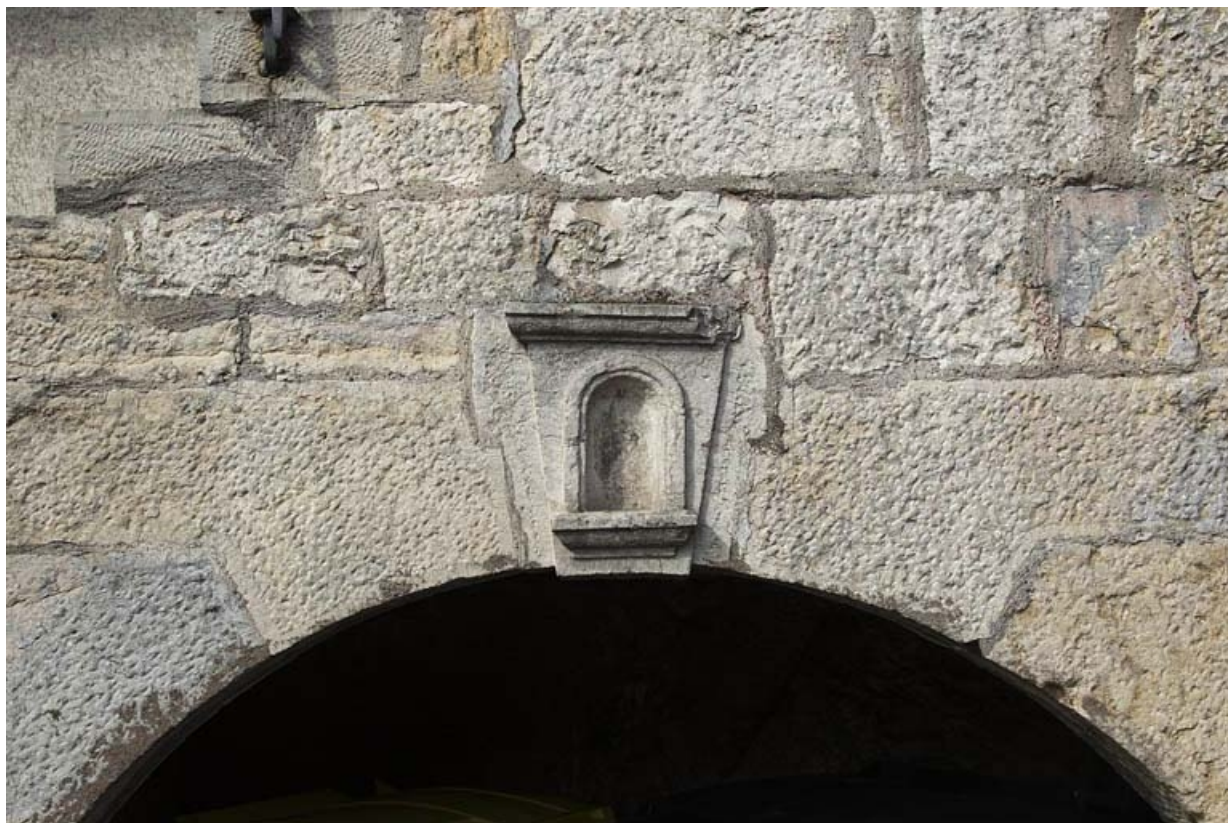
Détail d'une niche : 72 rue du Faubourg Rivotte.
