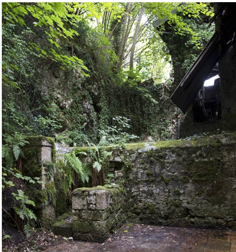
Vestiges des anciennes glacières de la ville (?) : 72 rue du Faubourg Rivotte.
