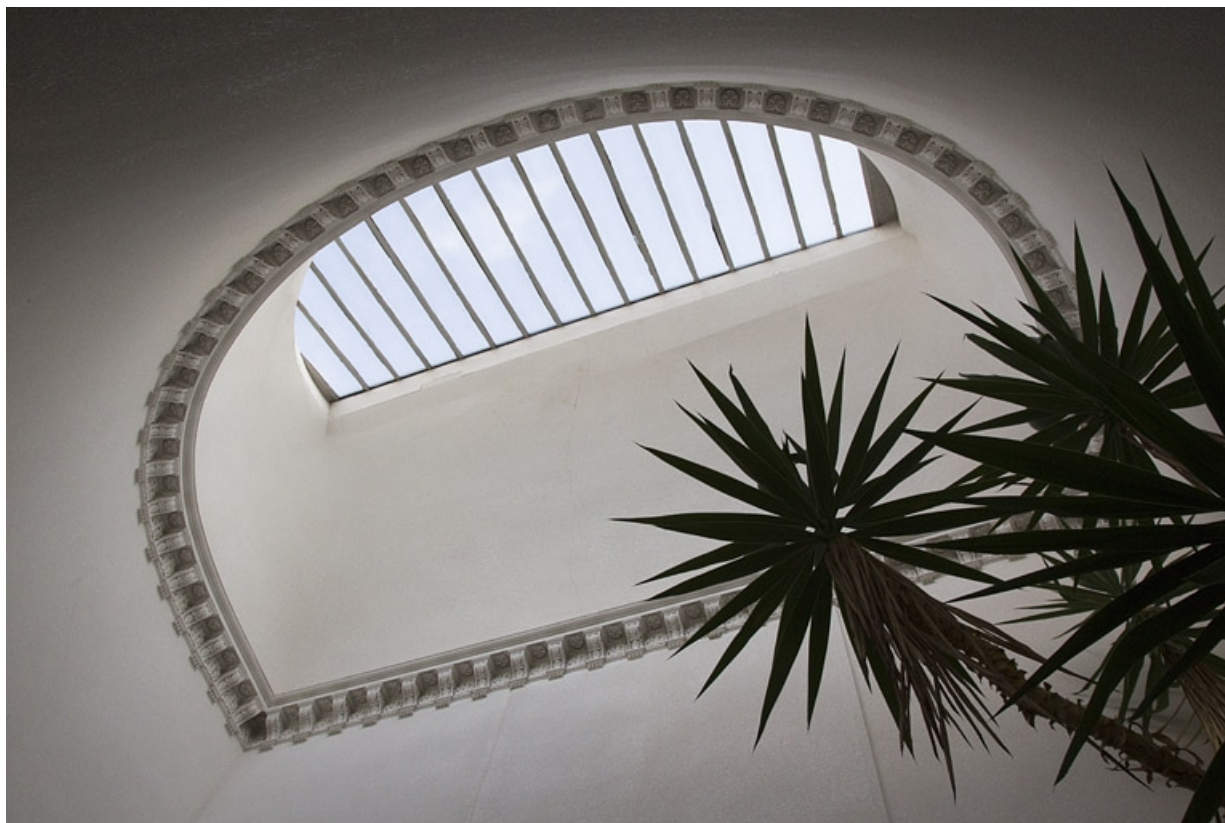
Intérieur : vue d'ensemble du plafond et de la verrière de la cage d'escalier.
