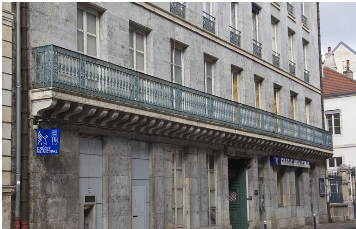
Façade antérieure, premier étage : vue d'ensemble du balcon filant.
