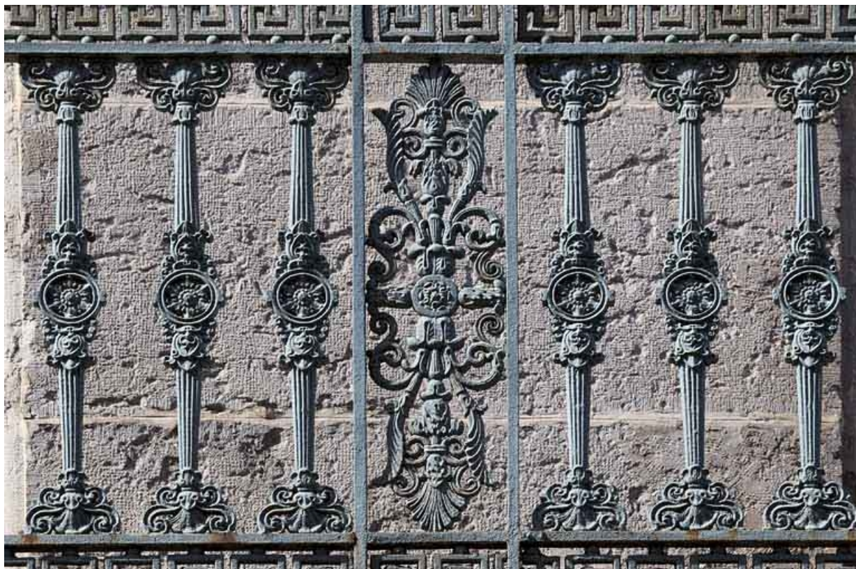
Façade antérieure, balcon filant : détail d'un décor du garde-corps en fonte.
