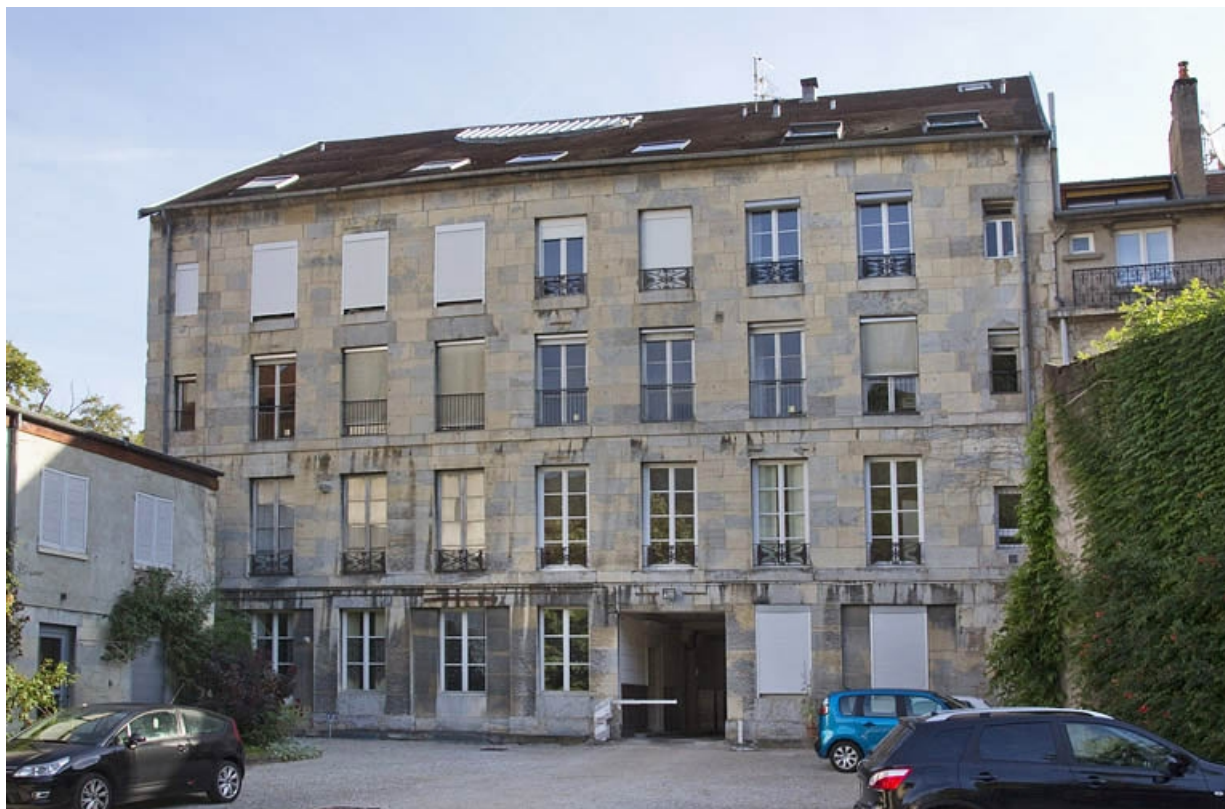
Vue d'ensemble de la façade postérieure depuis la cour.
