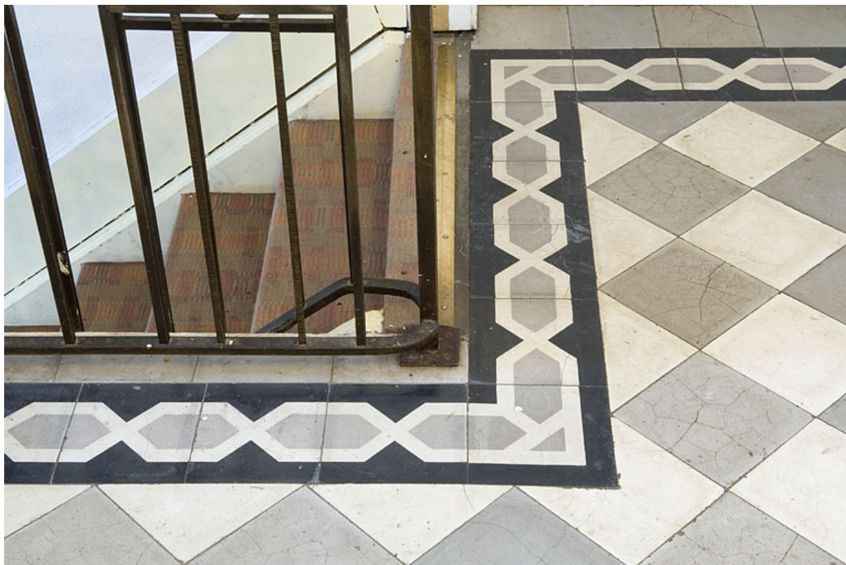
Intérieur : détail du pavement du premier étage de l'aile en retour (1933). 25, Jougne, 32 rue du Faubourg
