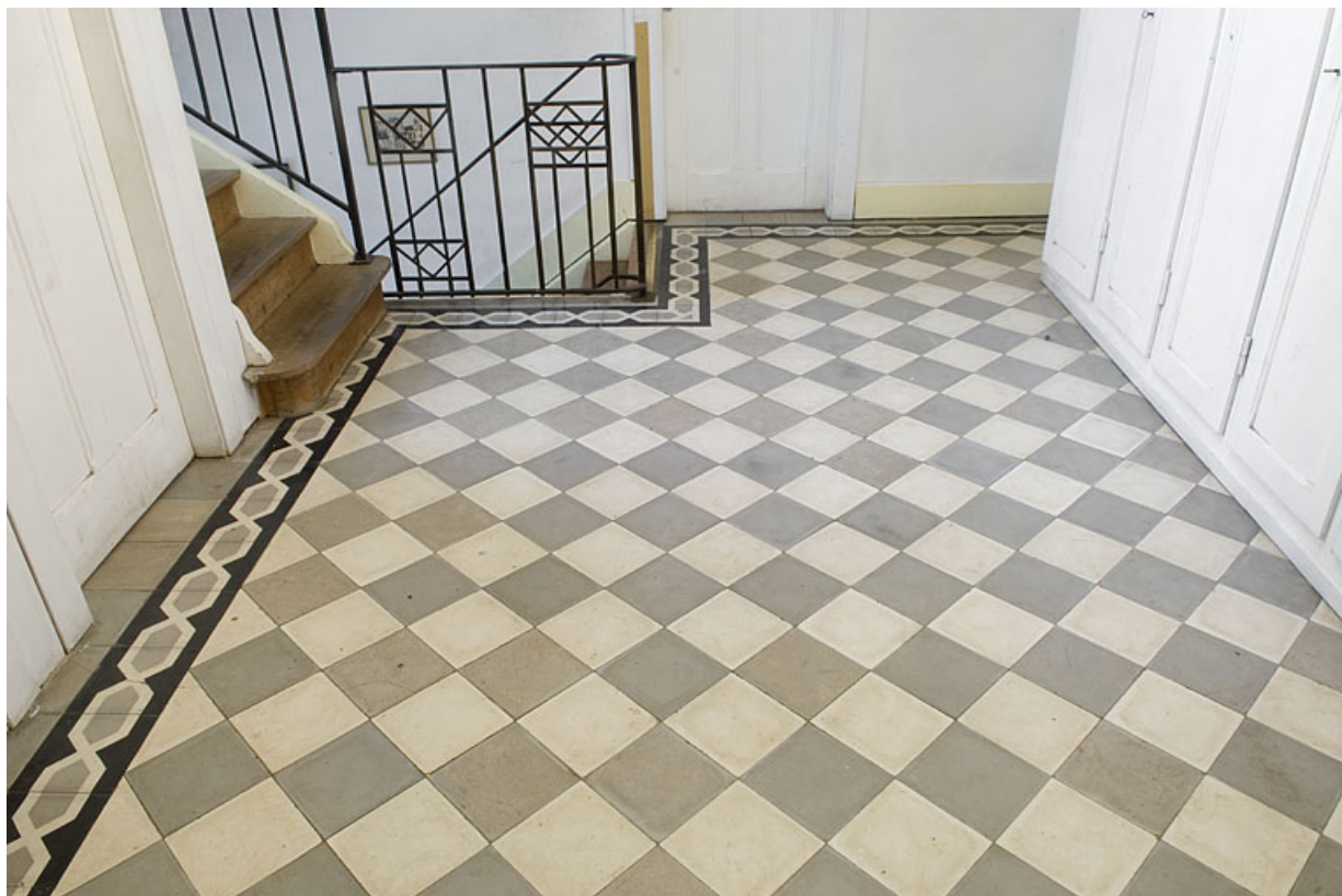
Intérieur : pavement du premier étage de l'aile en retour (1933). 25, Jougne, 32 rue du Faubourg
