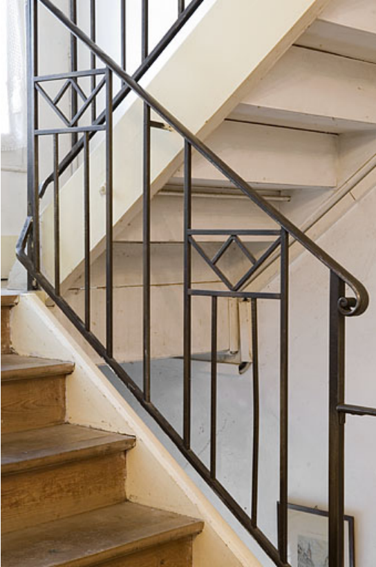
Intérieur : détail de la rampe d'appui de l'escalier menant aux étages de l'aile en retour (1933). 25, Jougne, 32 rue du Faubourg
