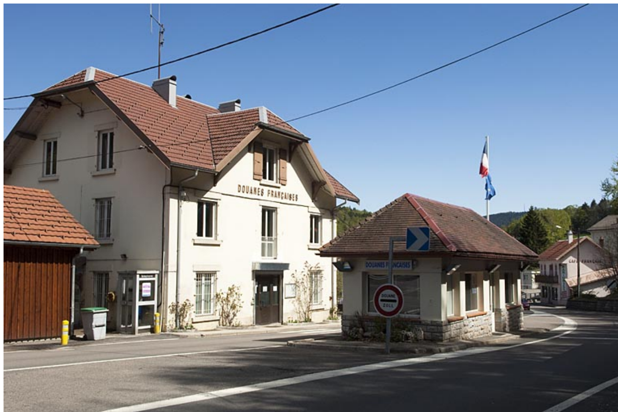
Vue du bureau des douanes et du poste de surveillance.
