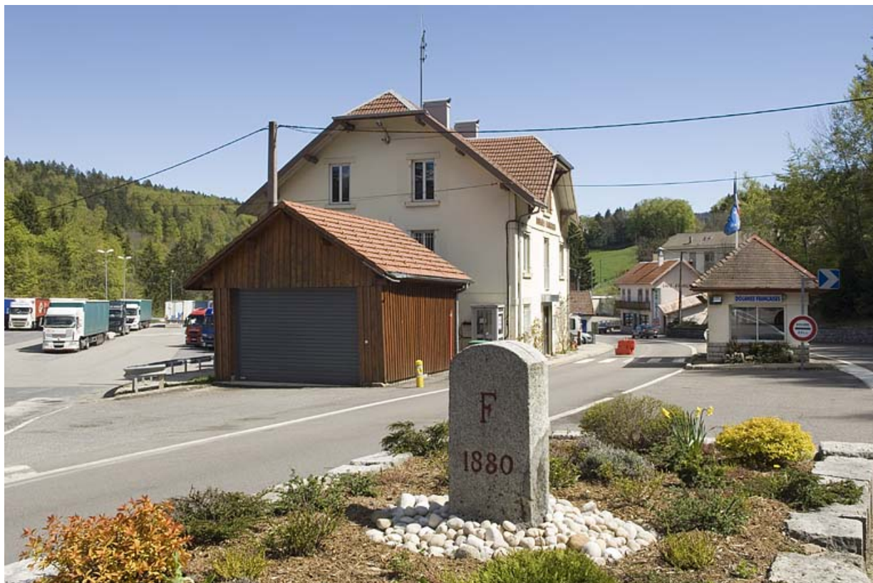
Vue d'ensemble des bâtiments de la douane.
