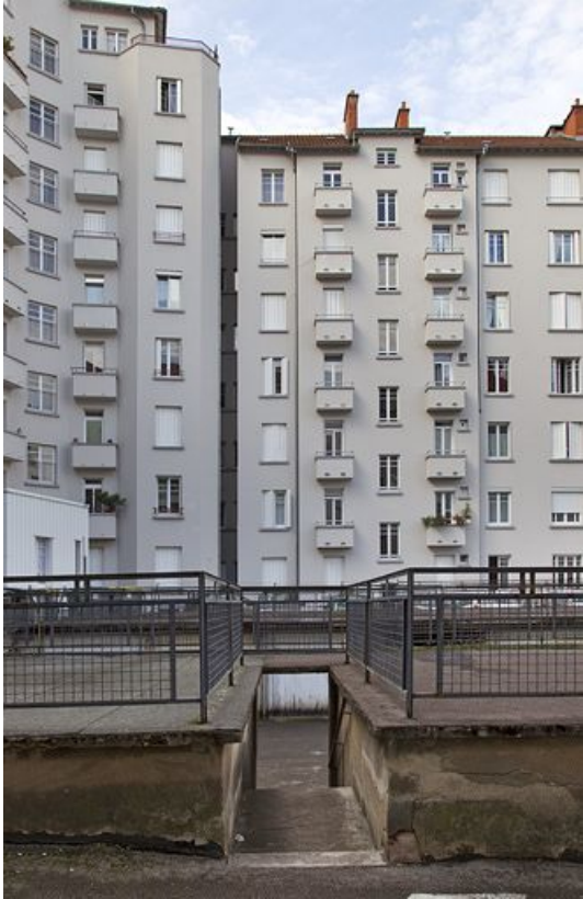
Cour des garages, vue latérale rapprochée.
