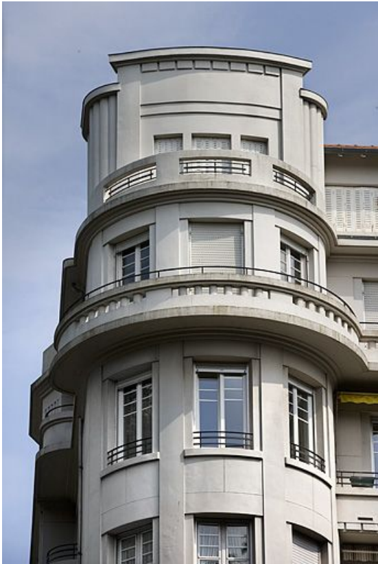
Détail de l'avant-corps arrondi, côté hôtel Mercure. 25, Besançon avenue Edouard Droz, lieudit : îlot Casino
