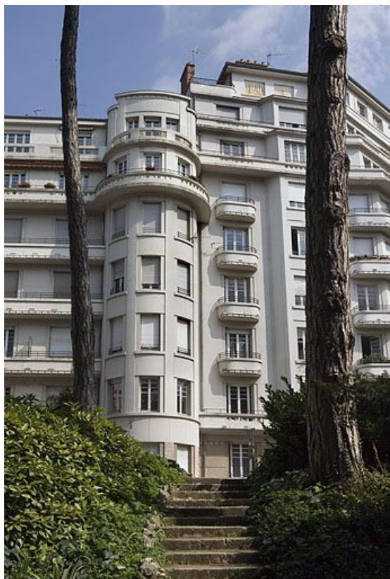
Façades depuis la promenade Micaud : vue partielle. 25, Besançon avenue Edouard Droz, lieudit : îlot Casino
