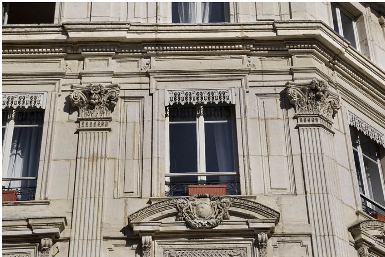
Façade antérieure, décor : détail de deux pilastres cannelés à chapiteaux corinthiens.
