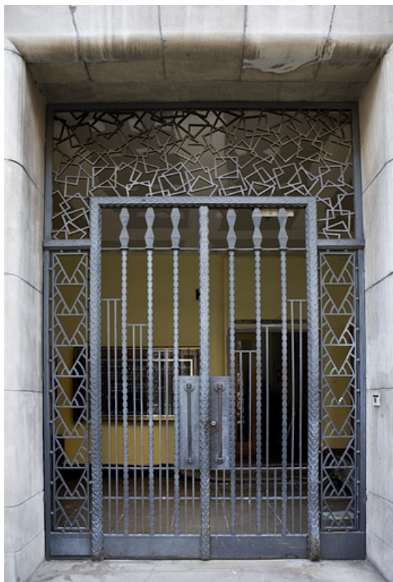
Portail d'entrée : détail de la grille.
