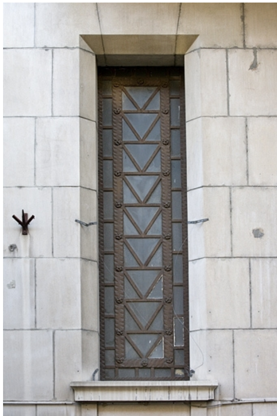
Détail d'une fenêtre à gauche du portail d'entrée.
