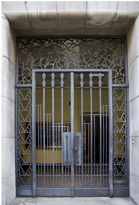
Portail d'entrée : détail de la grille.
