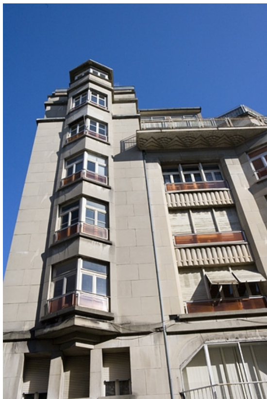
Façade antérieure : détail de la partie gauche.
