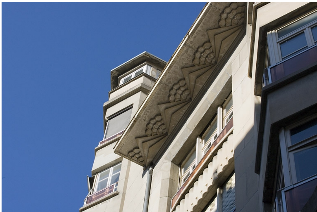
Balcon, partie gauche : détail du décor de la dalle.
