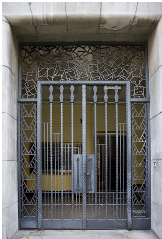
Portail d'entrée : détail de la grille.
