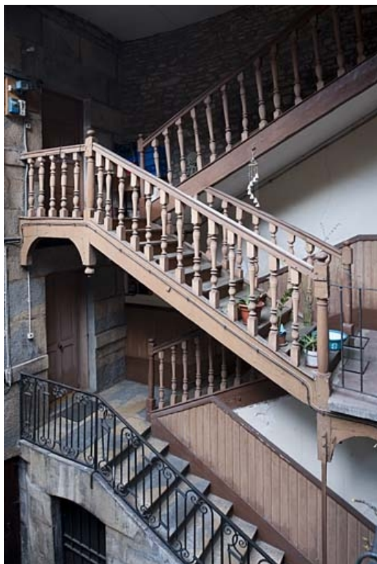
Détail de l'escalier à cage ouverte de trois quarts droit.
