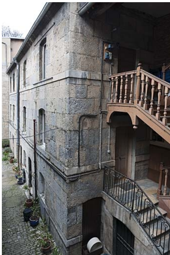
Vue d'ensemble de l'escalier à cage ouverte et du premier logis secondaire de trois quarts droit.
