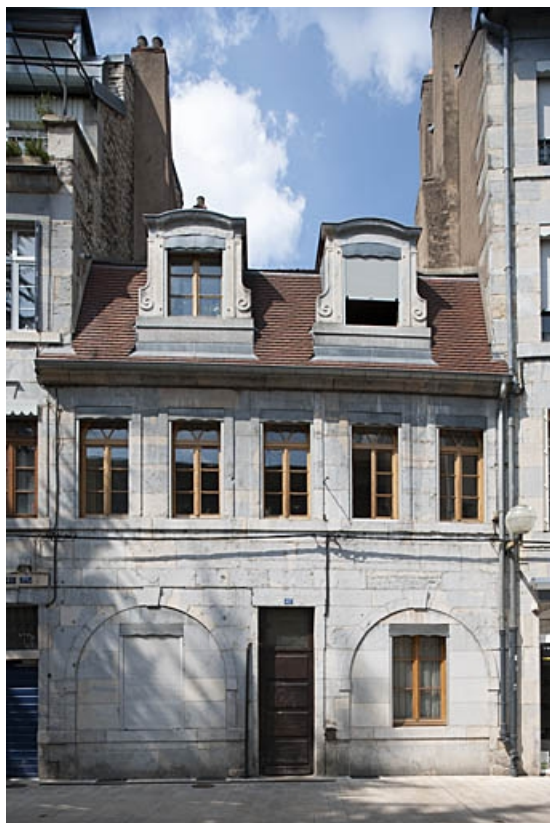
Façade antérieure : vue d'ensemble de face.
