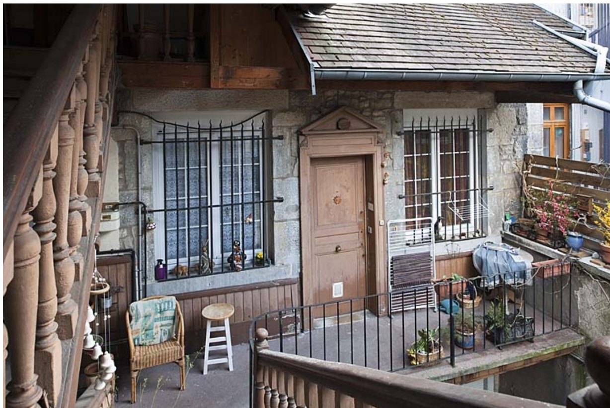
Façade postérieure du logis principal : détail du premier étage depuis l'escalier à cage ouverte. 25, Besançon, 47 rue Bersot, lieudit : îlot Lorraine
