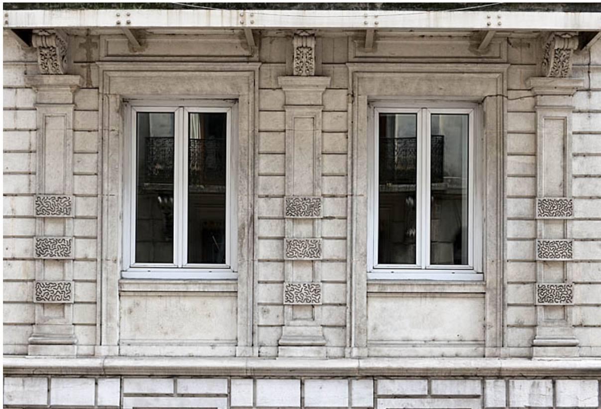
Façade antérieure : détail de deux fenêtres du rez-de-chaussée.
