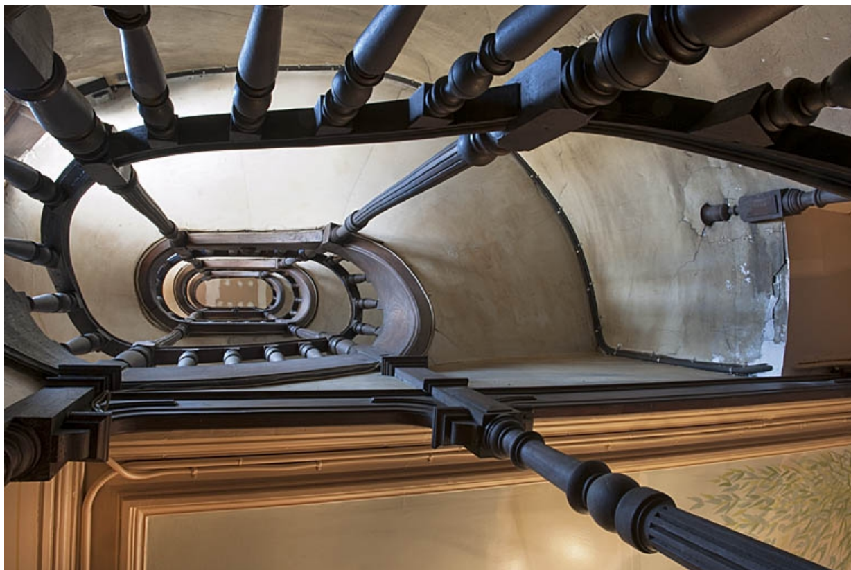
Détail de l'escalier en contre-plongée depuis le rez-de-chaussée.
