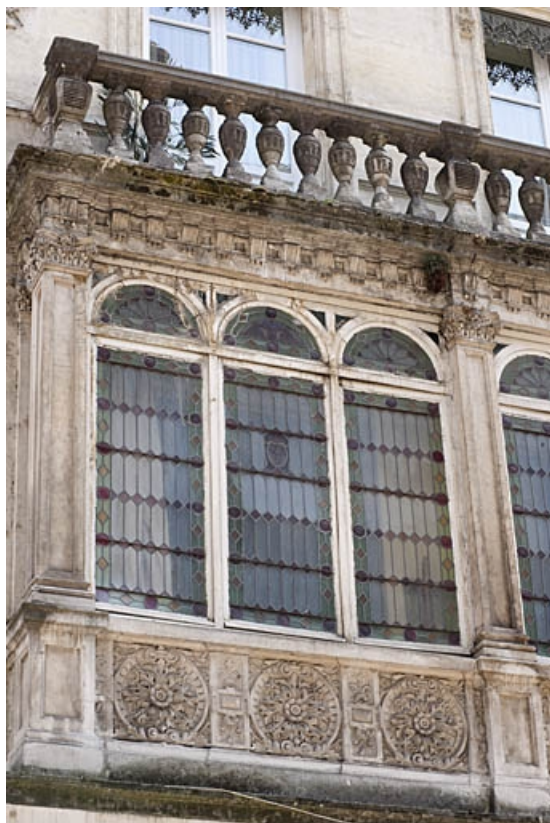
Façade antérieure : détail de la partie gauche du bow-window.
