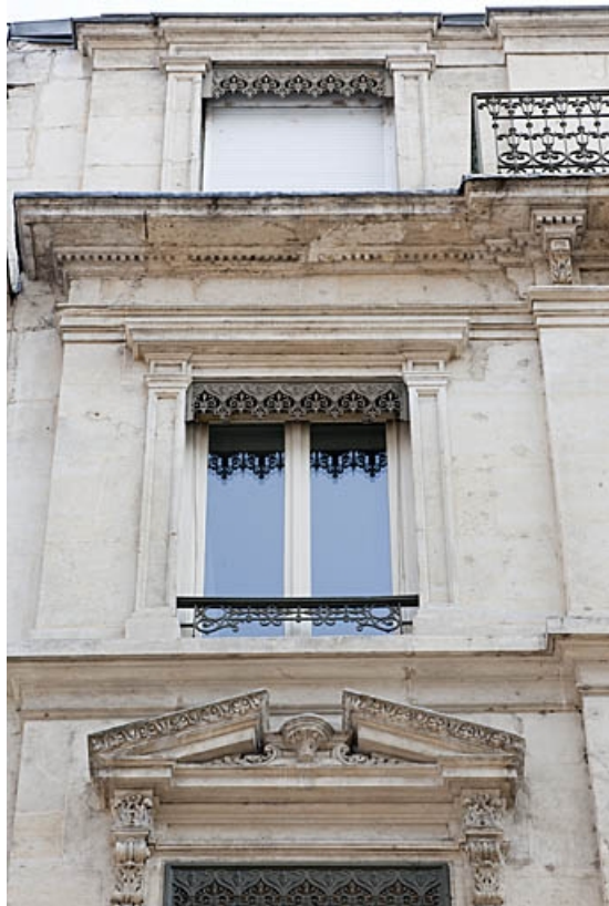
Façade antérieure : détail d'une fenêtre du troisième étage.
