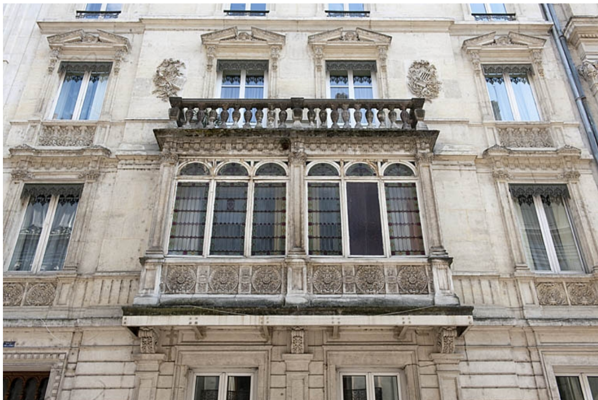
Façade antérieure : détail du bow-window de face.
