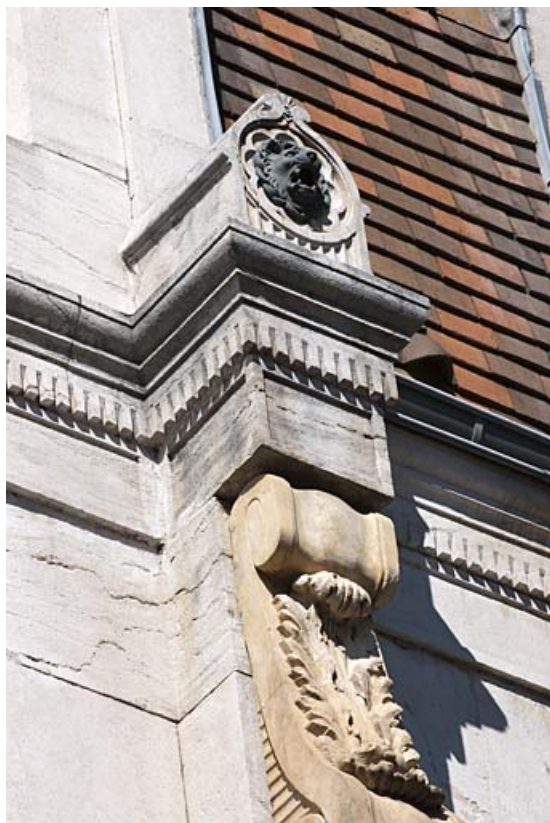
Façade sur rue : détail de la tête de lion à gauche de la baie centrale du comble. 25, Besançon, 11 rue Gustave Courbet, lieudit : îlot Courbet
