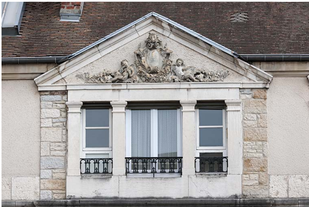
Façade postérieure : détail de la baie en triplet surmontée d'un fronton triangulaire.
