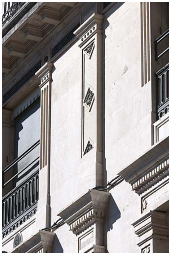
Façade sur rue : détail du décor d'un montant de fenêtre et d'un pilastre du deuxième étage.
