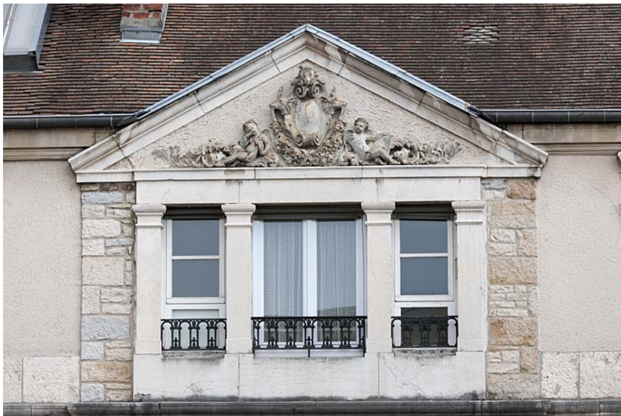
Façade postérieure : détail de la baie en triplet surmontée d'un fronton triangulaire.
