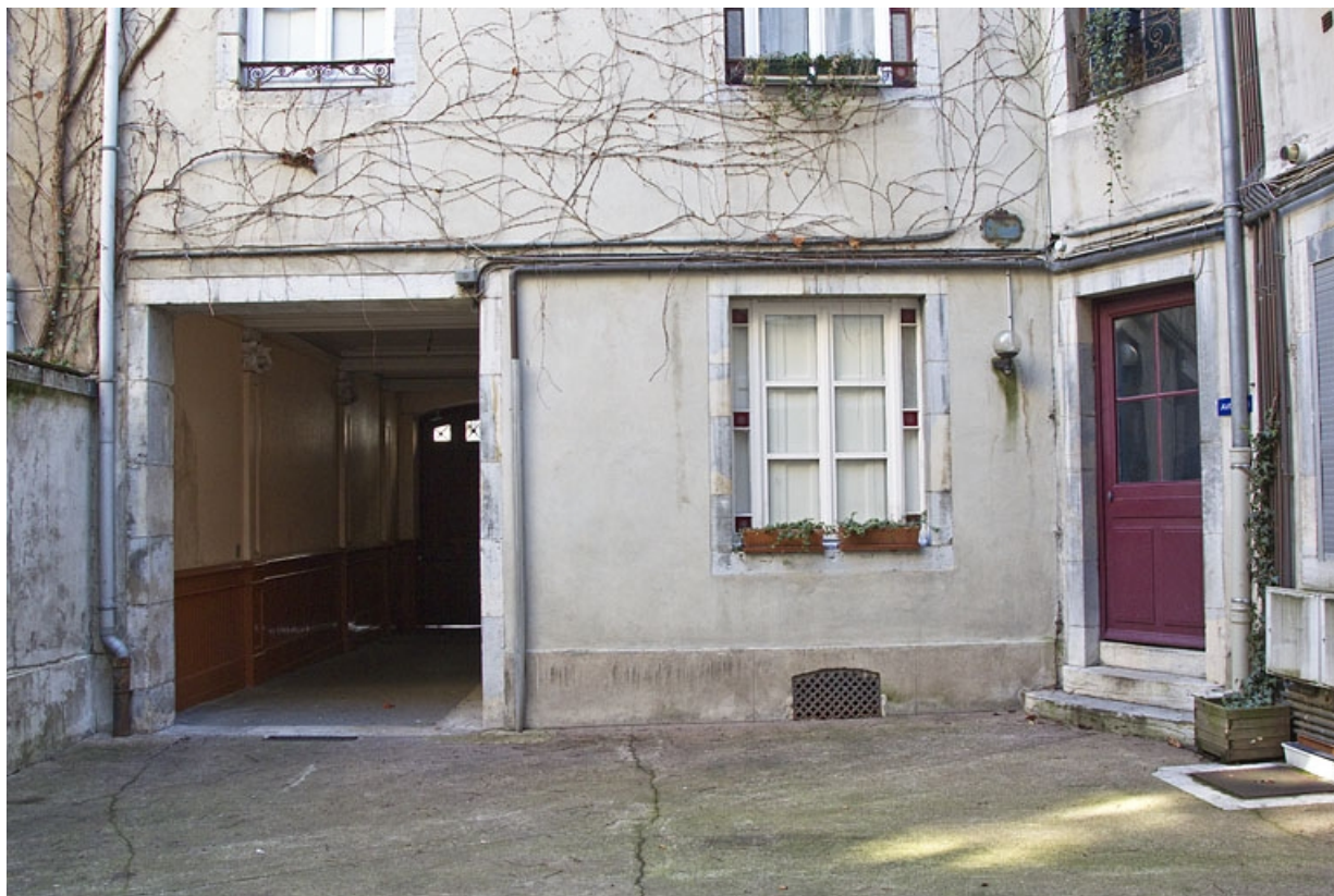
Façades sur cour : détail du passage cocher et de l'entrée du premier escalier.
