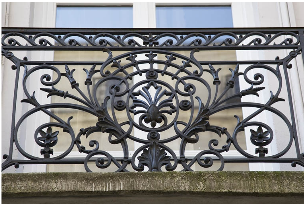
Façade antérieure : détail d'un garde-corps du balcon du premier étage : vue rapprochée.
