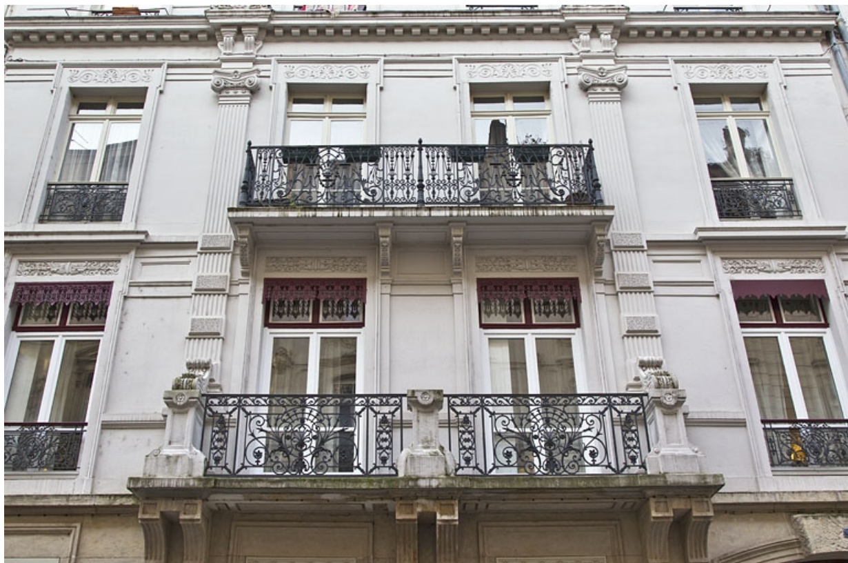
Façade antérieure : vue des balcons des premier et deuxième étages.
