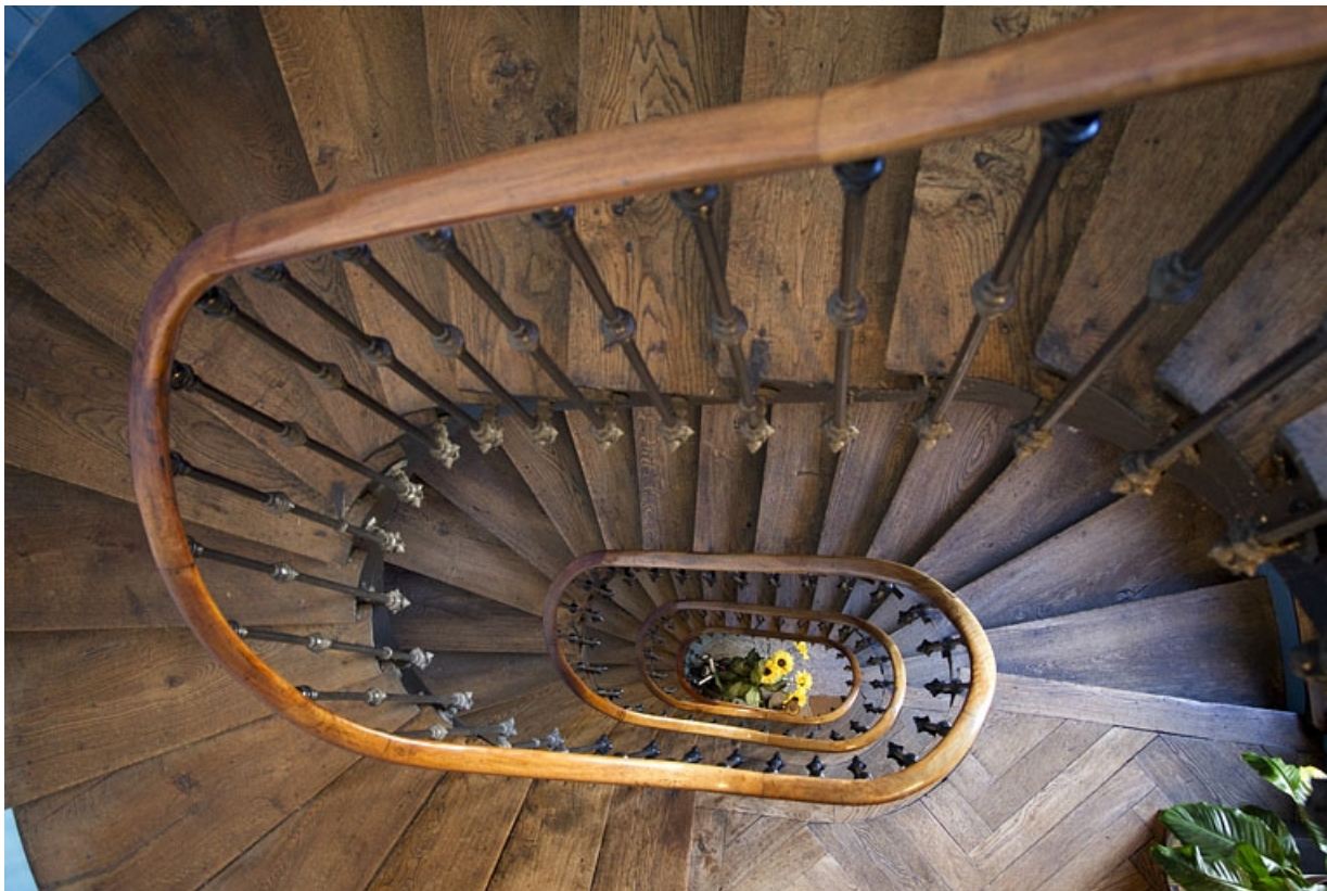
Intérieur : vue d'ensemble de l'escalier principal depuis le haut.
