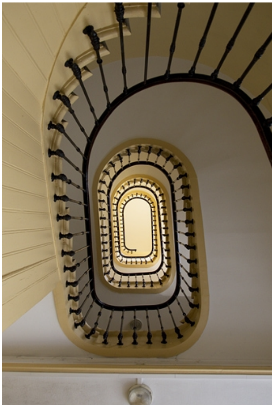
Vue d'ensemble du premier escalier depuis le bas.
