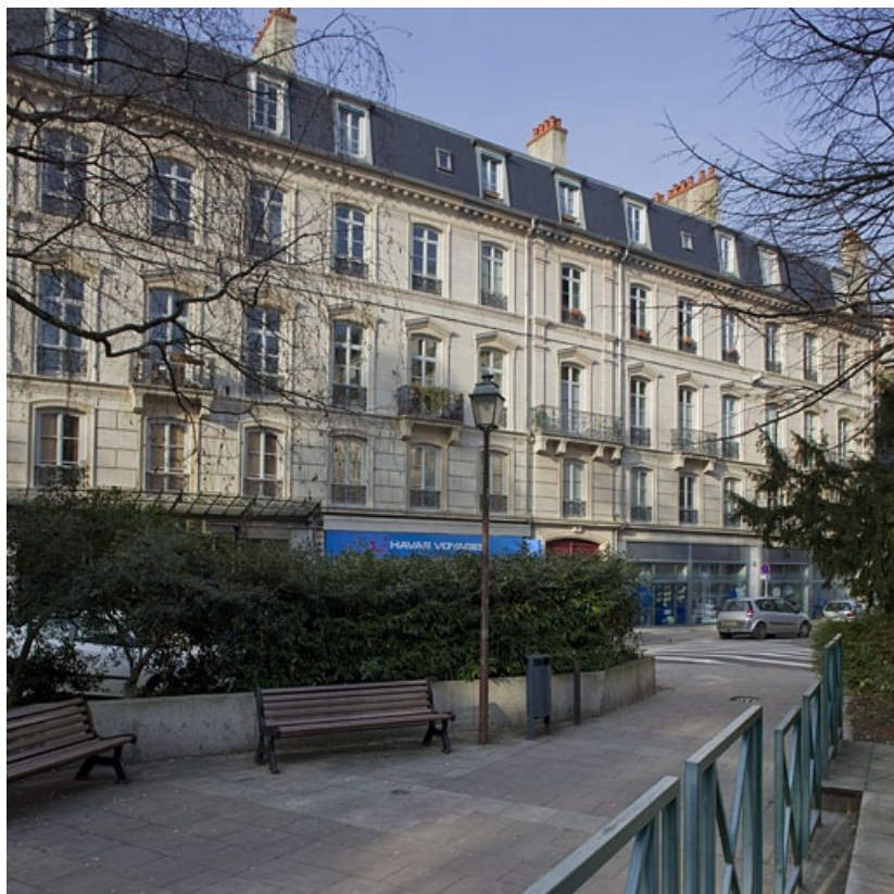
Vue d'ensemble dans l'alignement de la rue, depuis le square Saint-Amour. 25, Besançon, 26 rue de la République, lieudit : îlot Saint-Amour
