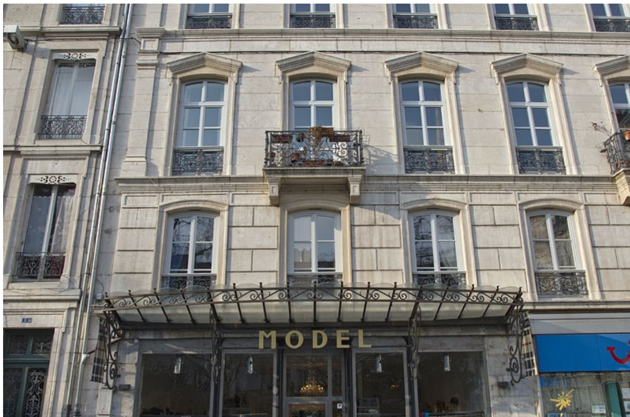
Façade antérieure, rue Léonel de Moustier : détail de la partie gauche jusqu'au deuxième étage, de face. 25, Besançon, 26 rue de la République, lieudit : îlot Saint-Amour
