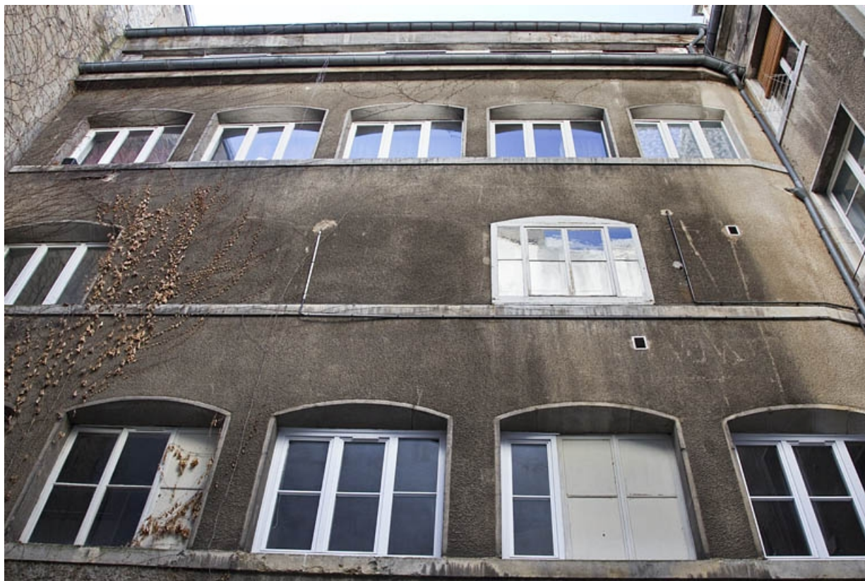
Vue de l'atelier d'horlogerie à droite de la cour, de face. 25, Besançon
