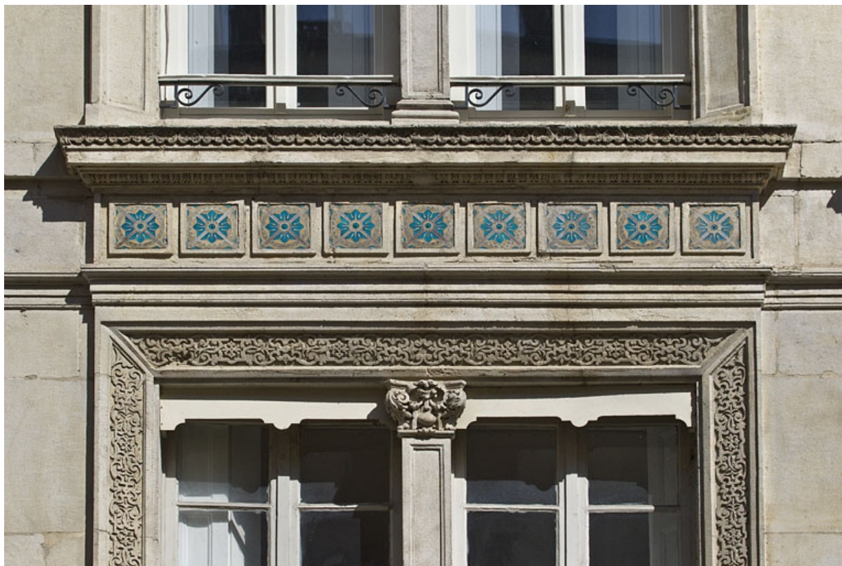
Façade antérieure : détail du décor en céramique au-dessus des fenêtres du premier étage.
