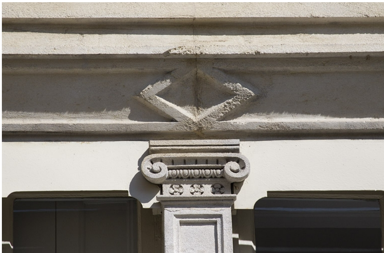
Façade antérieure, fenêtre du deuxième étage : détail d'un chapiteau ionique couronnant le meneau.
