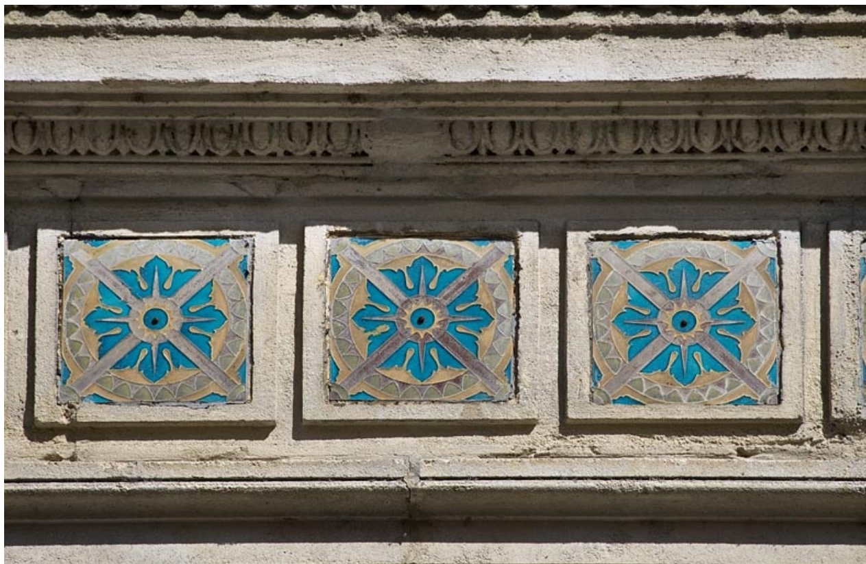
Façade antérieure : détail du décor en céramique au-dessus des fenêtres du premier étage, vue rapprochée. 25, Besançon, 14 rue Proudhon, lieudit : îlot Saint-Amour
