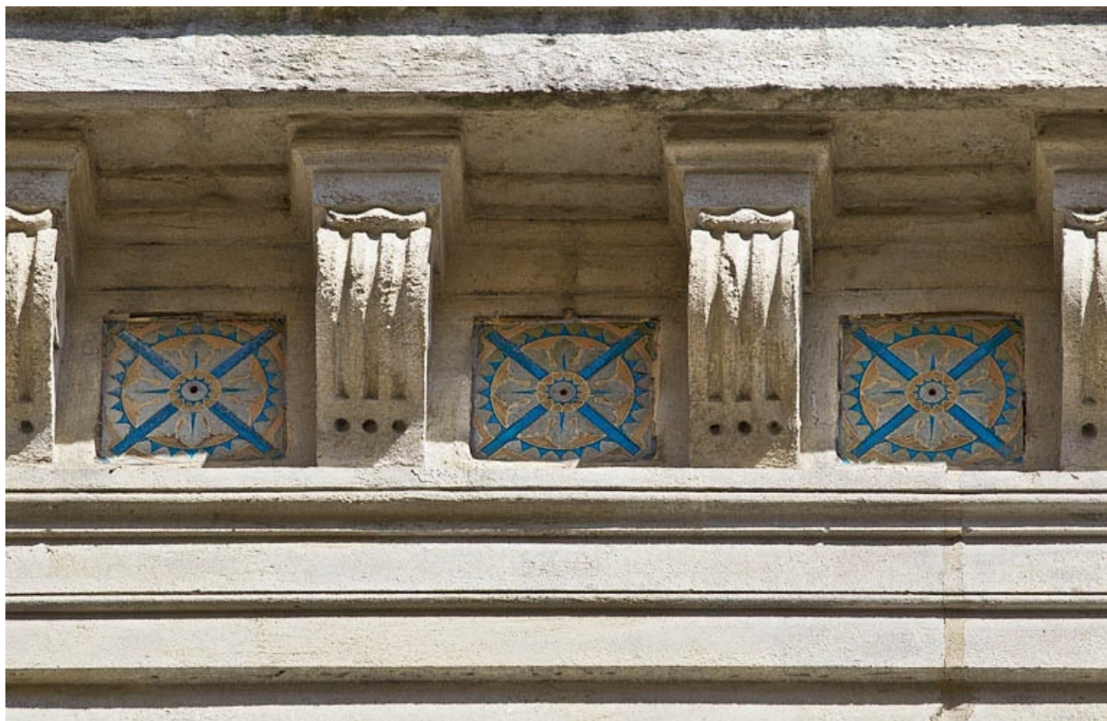
Façade antérieure : détail du décor en céramique de la corniche.
