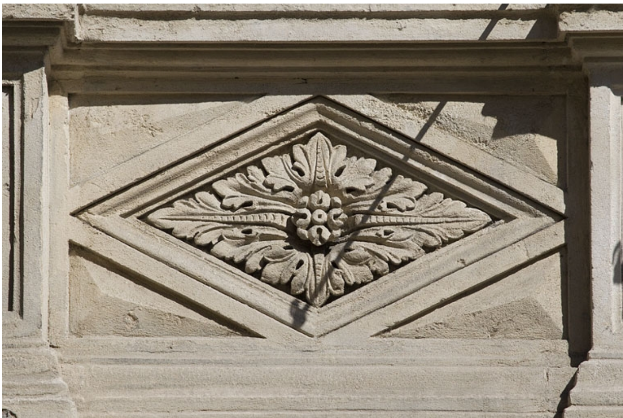
Façade antérieure, fenêtres du premier étage : détail d'un motif en losange sous une fenêtre. 25, Besançon, 14 rue Proudhon, lieudit : îlot Saint-Amour
