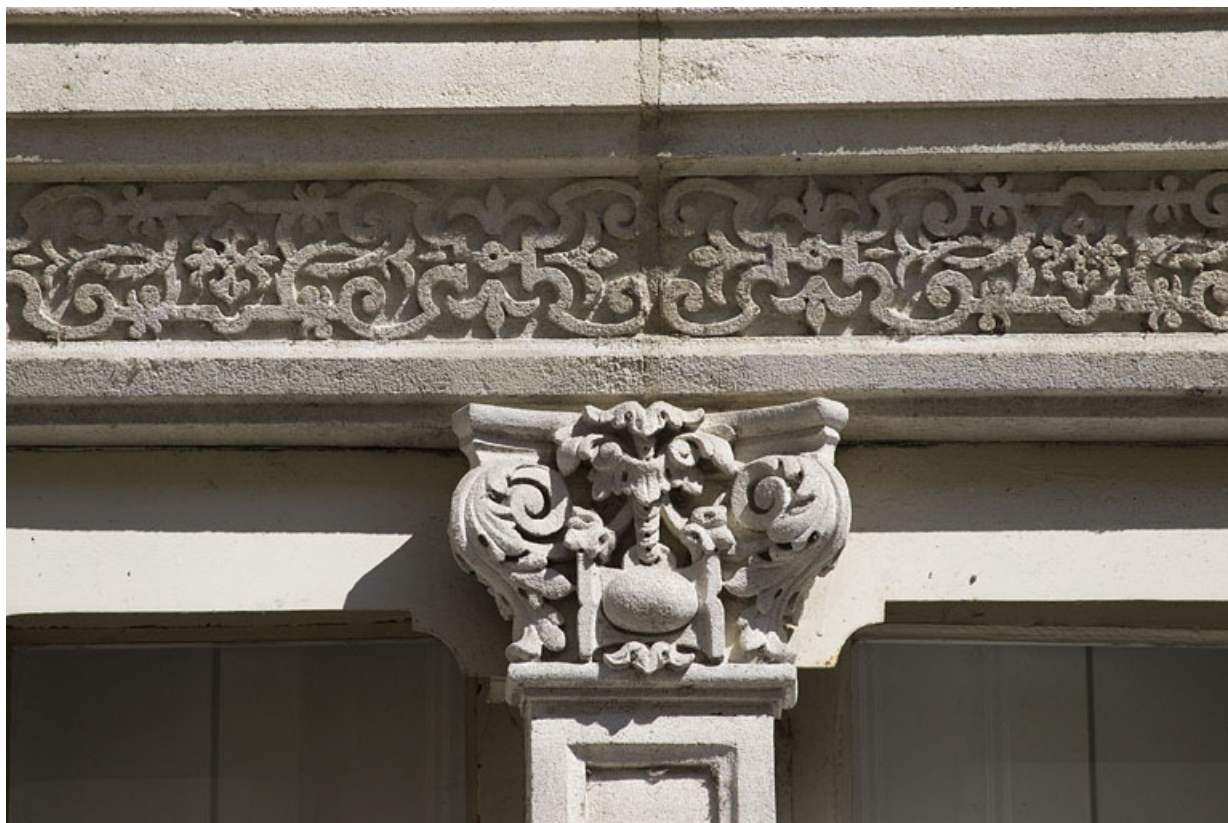
Façade antérieure, fenêtre du premier étage : détail d'un chapiteau composé couronnant le meneau.
