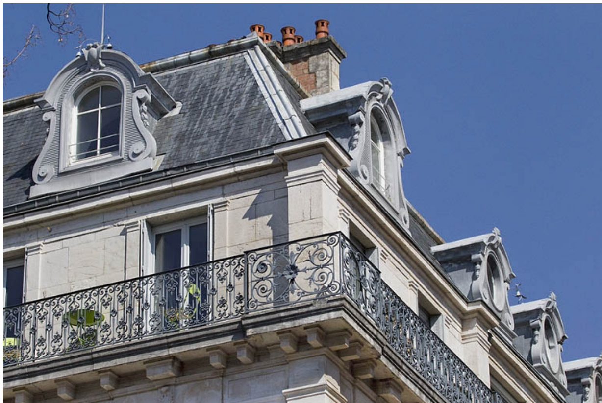
Détail de la toiture et du garde-corps de l'étage de surélévation, à l'angle droit de l'édifice.
