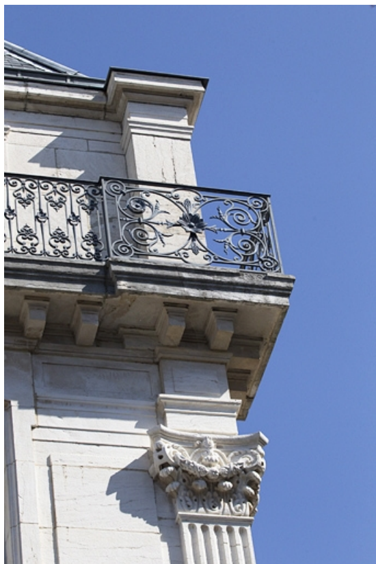
Façade antérieure, angle droit : détail d'un chapiteau corinthien et du garde-corps de l'étage de surélévation. 25, Besançon, 7 square Saint-Amour, lieudit : îlot Saint-Amour
