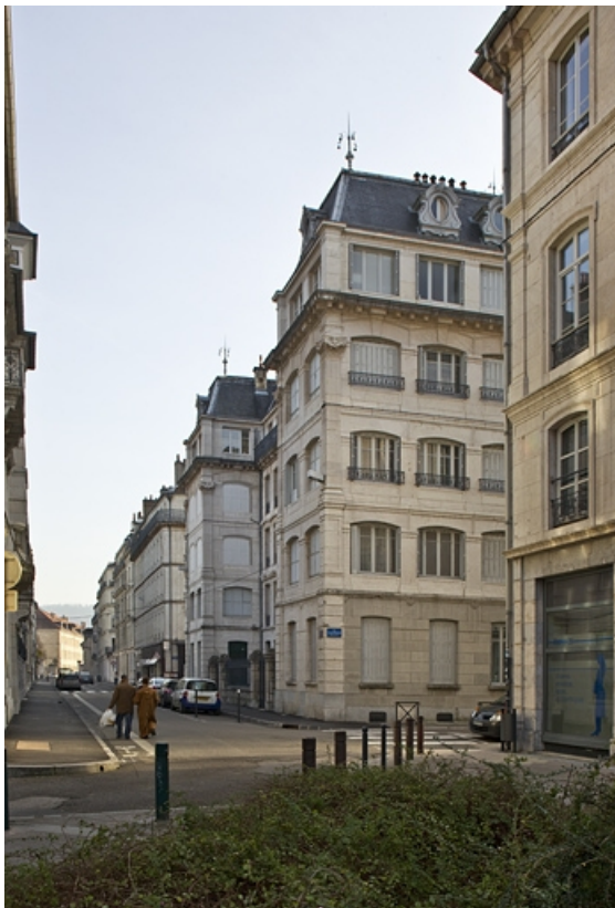
Façade postérieure, vue éloignée : de trois quarts droit.
