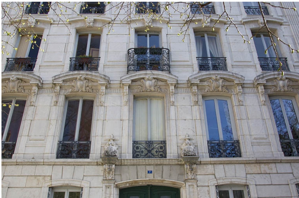
Vue de la façade antérieure à partir du premier étage.
