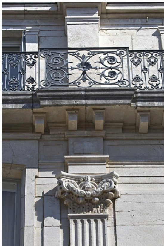
Façade antérieure : détail d'un chapiteau corinthien et du garde-corps de l'étage de surélévation. 25, Besançon, 7 square Saint-Amour, lieudit : îlot Saint-Amour
