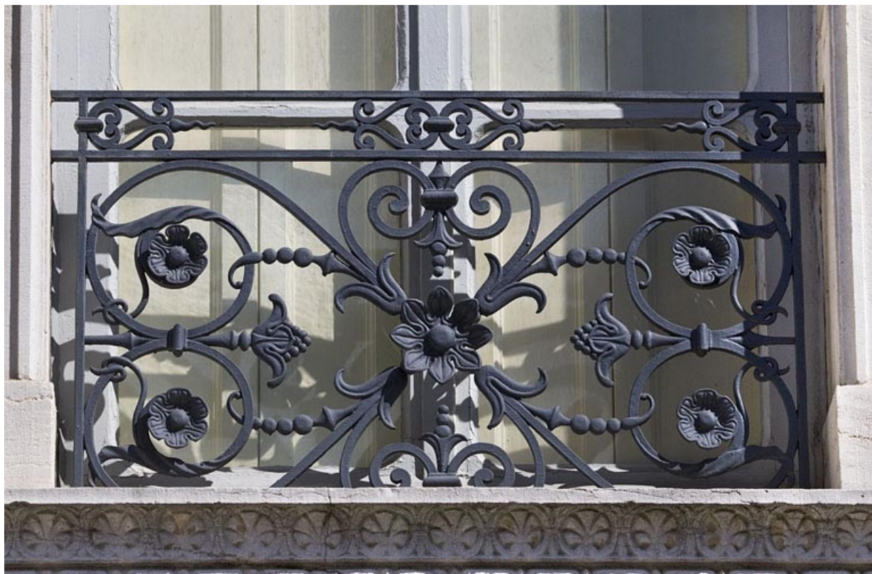
Façade antérieure : détail d'un garde-corps en ferronnerie d'une fenêtre.
