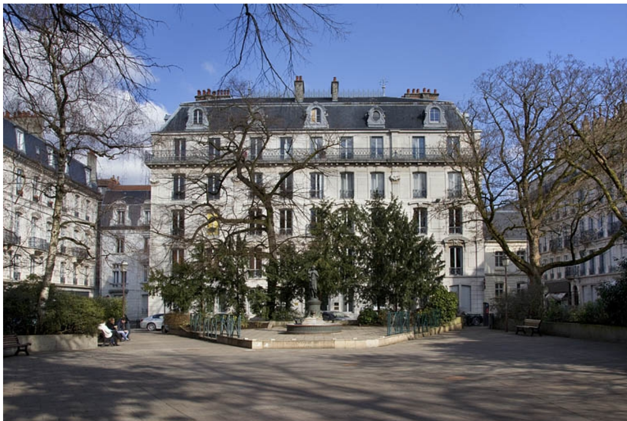
Façade antérieure, depuis le square saint-Amour : de face. 25, Besançon
