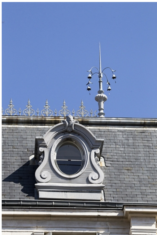
Toiture : détail d'une lucarne et du décor du faite du toit.
