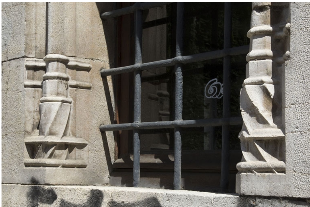
Façade antérieure, fenêtre au-dessus de l'entrée de cave : détail des bases prismatiques.
