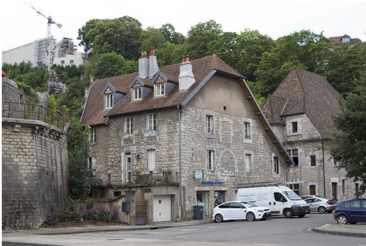
Bâtiment des remises et écuries : vue d'ensemble, de trois quarts gauche.
