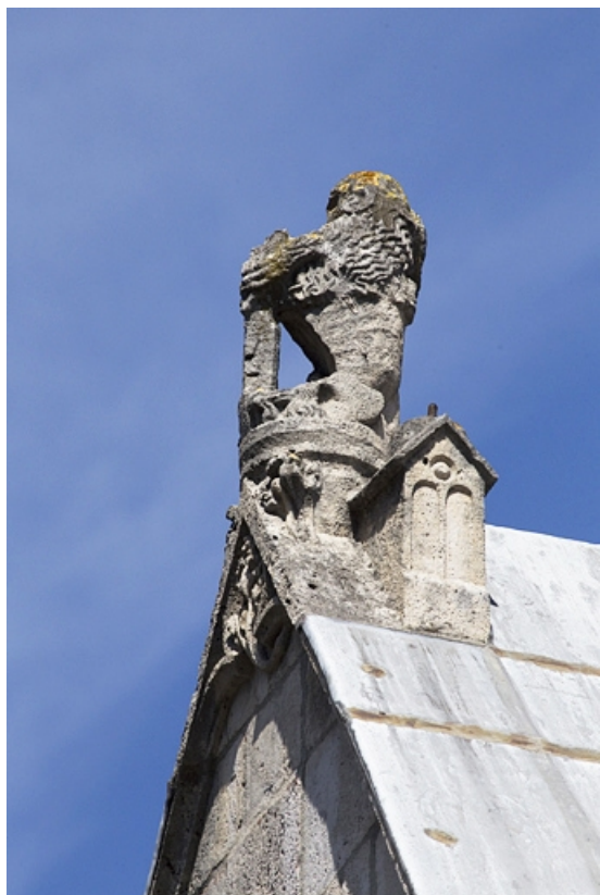
Façade antérieure, lucarne : détail de la sculpture ornant le pignon, de profil. 25, Besançon, 19 rue Rivotte, lieudit : îlot Porte Rivotte
