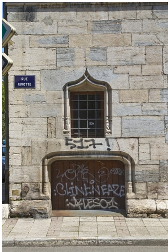
Façade antérieure, vue de l'entrée de cave.
