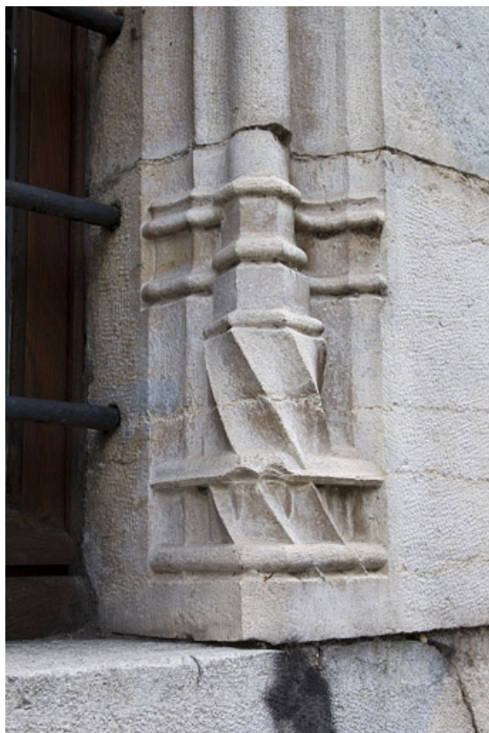
Façade antérieure, fenêtre au-dessus de l'entrée de cave : détail de la base prismatique droite. 25, Besançon, 19 rue Rivotte, lieudit : îlot Porte Rivotte
