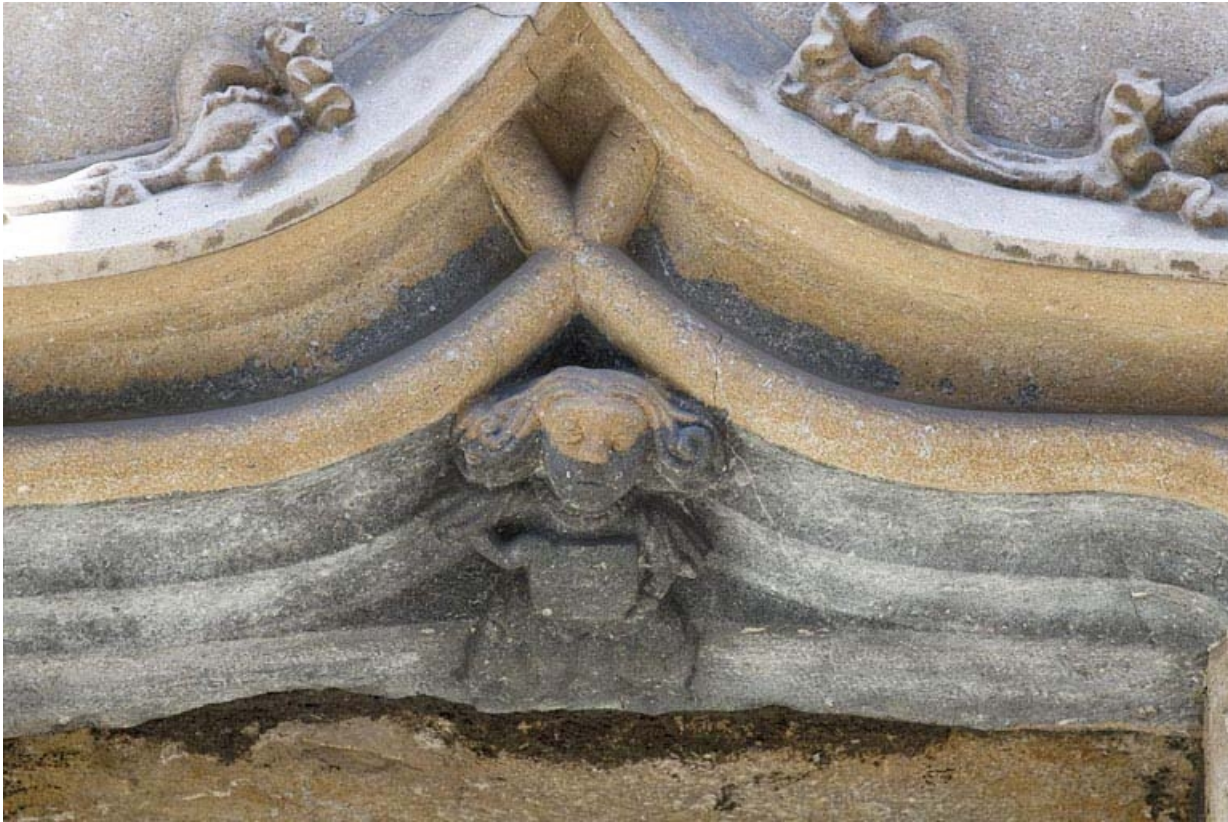
Façade antérieure, premier étage : détail de l'accolade de la baie centrale.
