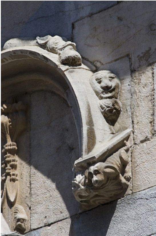
Façade antérieure, premier étage, baie centrale : détail de la partie droite de l'archivolte. 25, Besançon, 19 rue Rivotte, lieudit : îlot Porte Rivotte
