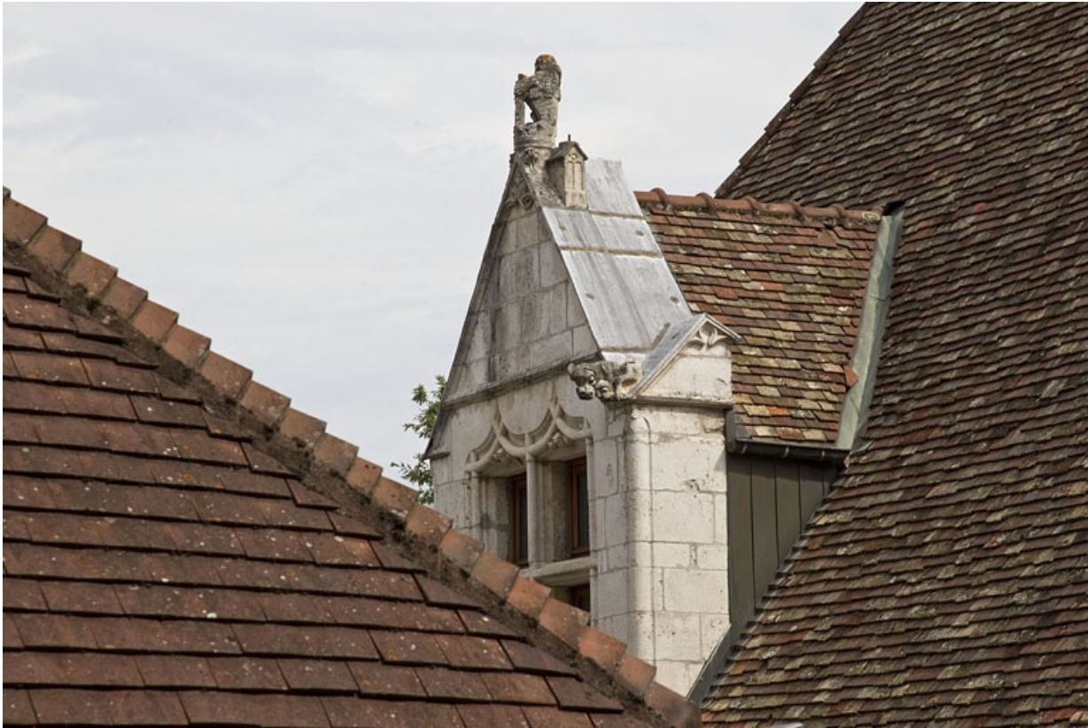
Façade antérieure : détail de la lucarne, de trois quarts droit.
