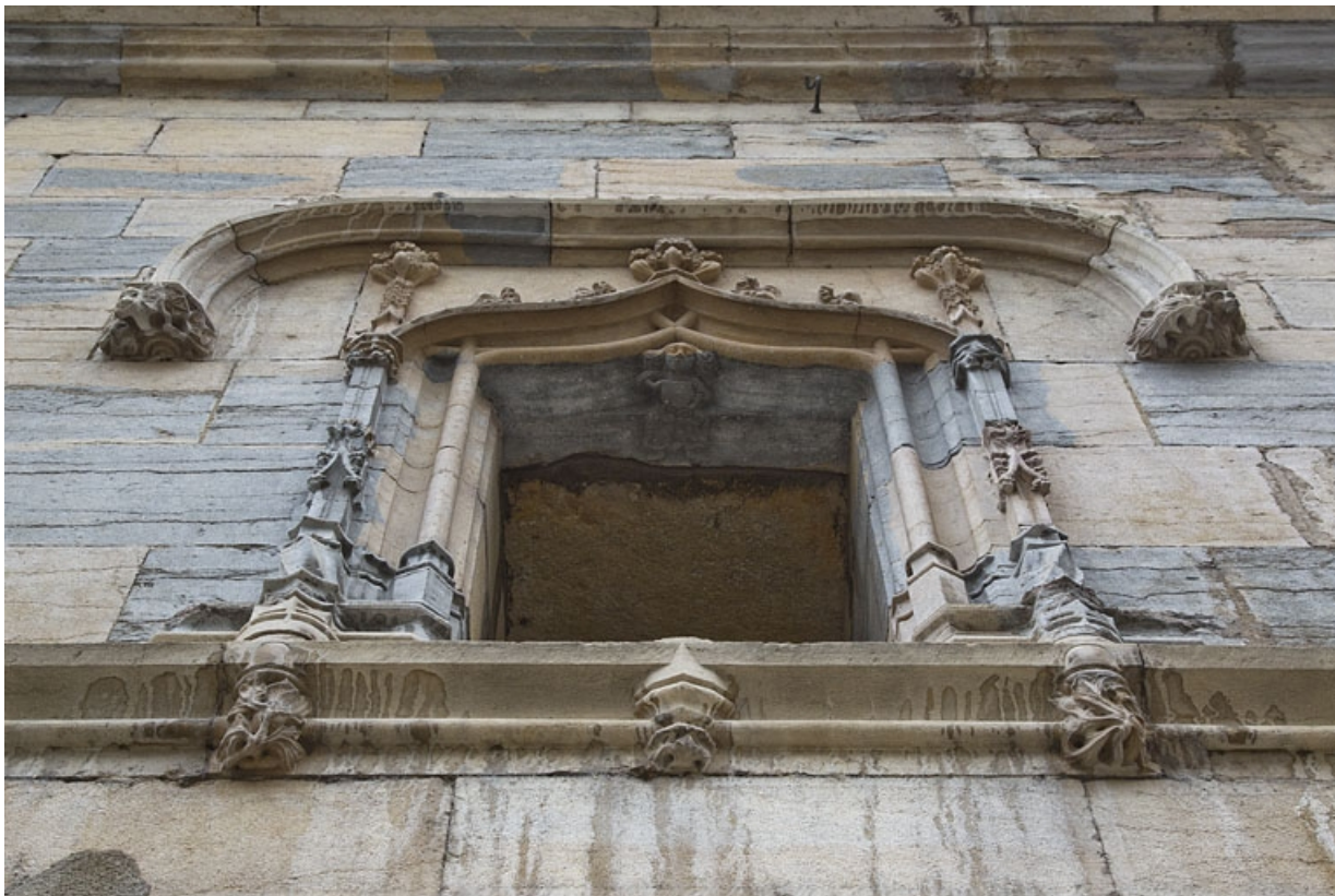
Façade antérieure, premier étage : détail de la fenêtre centrale, en contre-plongée.
