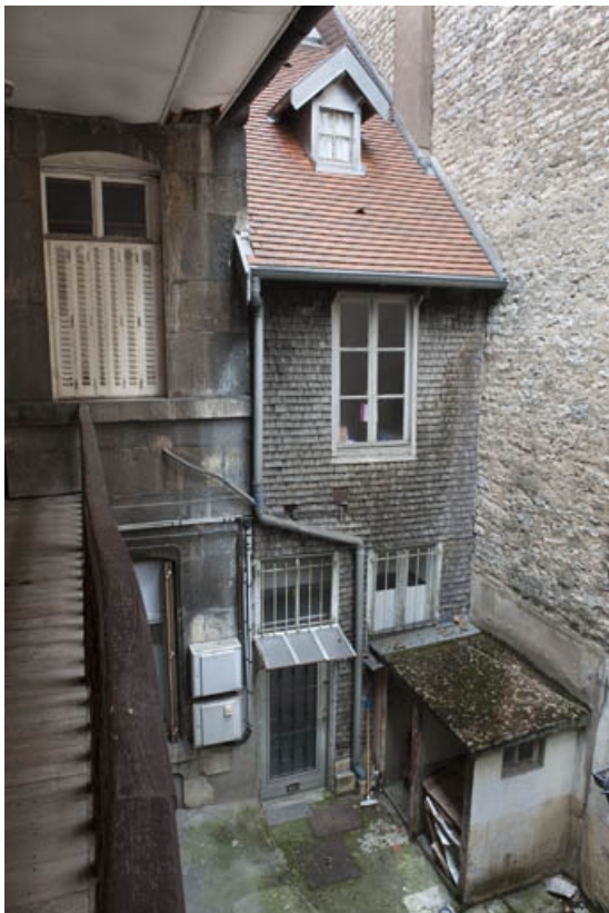
Façade sur cour du logis principal depuis l'escalier, avec la façade de la maison voisine couverte en tavillons. 25, Besançon, 16 rue Courbet, lieudit : îlot Carmélites
