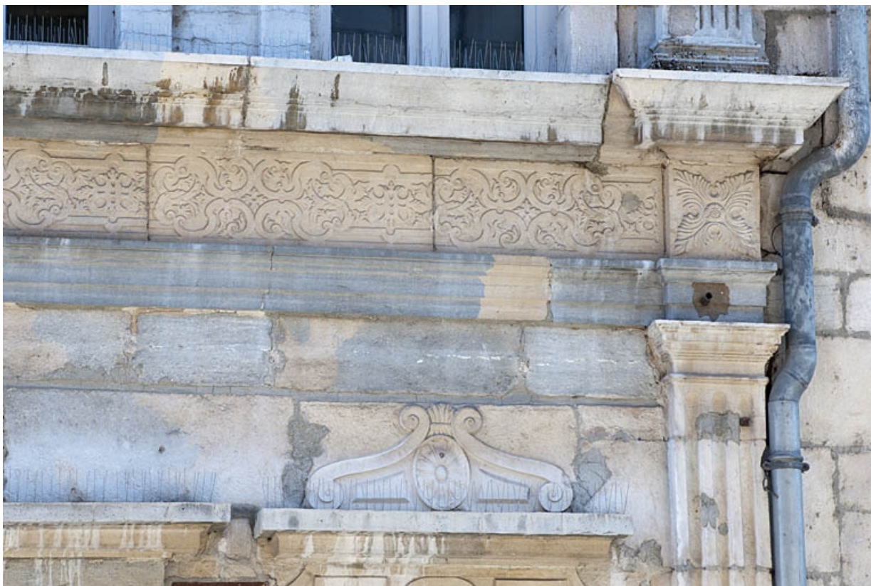
Façade sur rue : détail de la frise entre le rez-de-chaussée et le premier étage.
