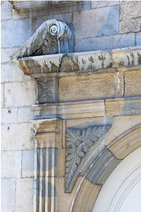
Façade sur rue : détail de l'angle supérieur gauche de l'entrée cochère. 25, Besançon, 3bis, 5 rue des Granges, lieudit : îlot Carmélites
