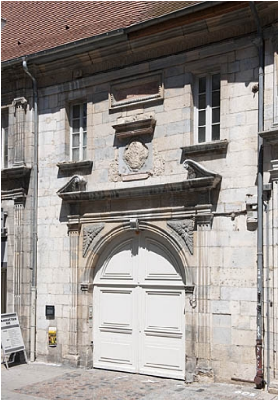
Façade sur rue : vue d'ensemble de la partie centrale.
