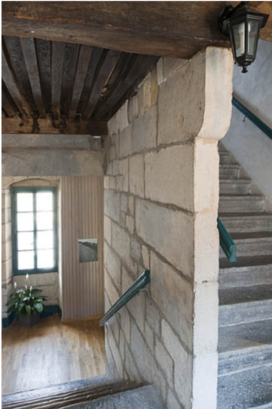
Intérieur : escalier principal en pierre, dernière volée.
