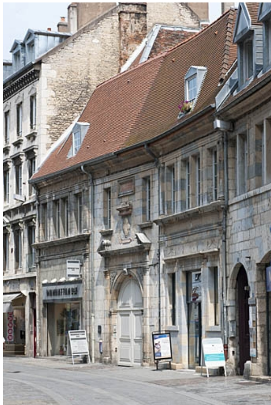
Façade sur rue : vue d'ensemble de trois quarts droit.
