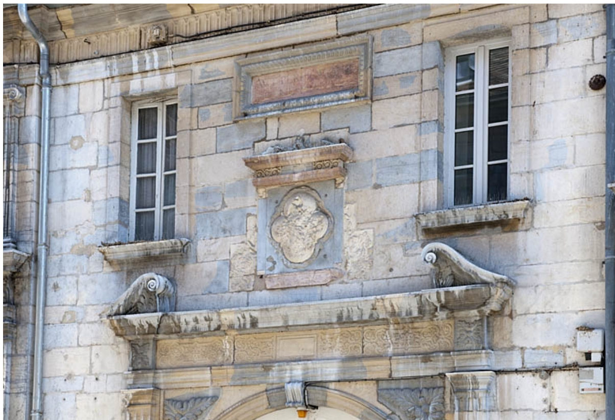
Façade sur rue : détail du décor au-dessus de la porte cochère.
