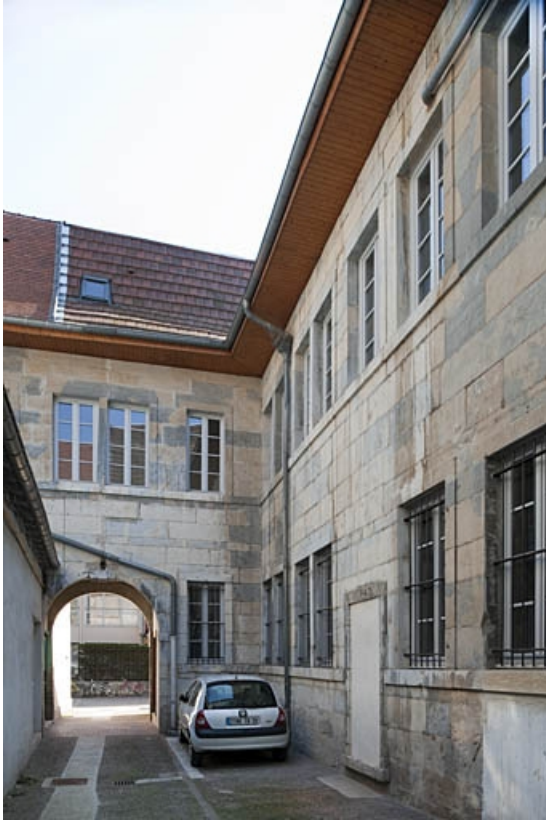
Vue du passage cocher depuis le fond de la cour.
