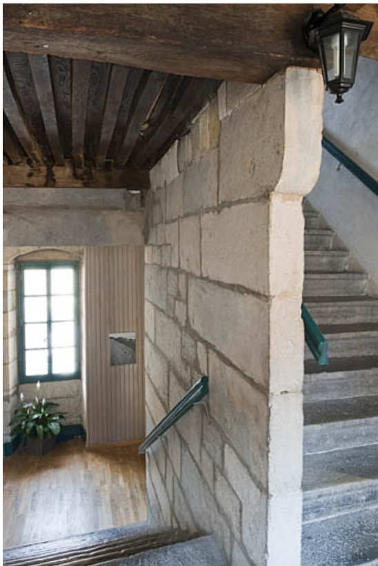
Intérieur : escalier principal en pierre, dernière volée.
