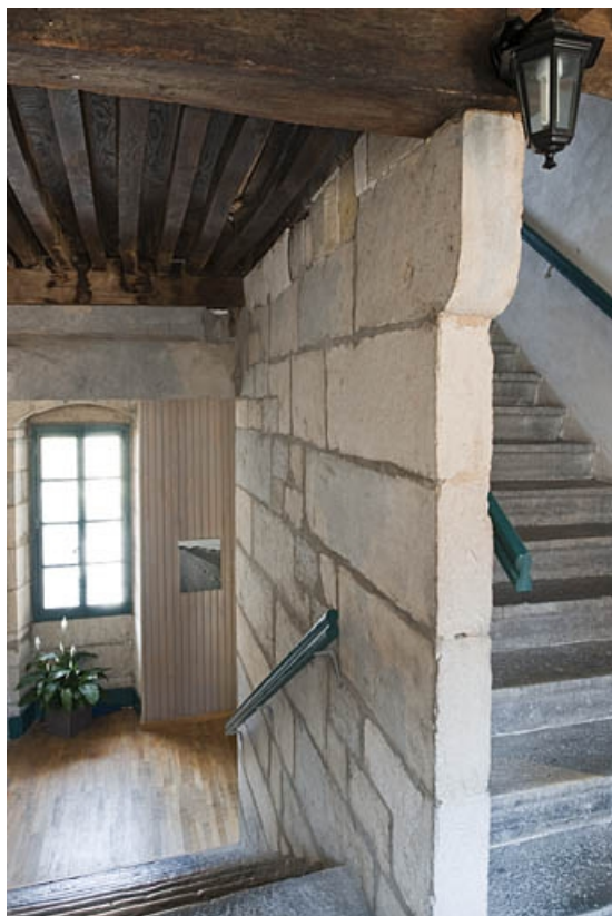
Intérieur : escalier principal en pierre, dernière volée.
