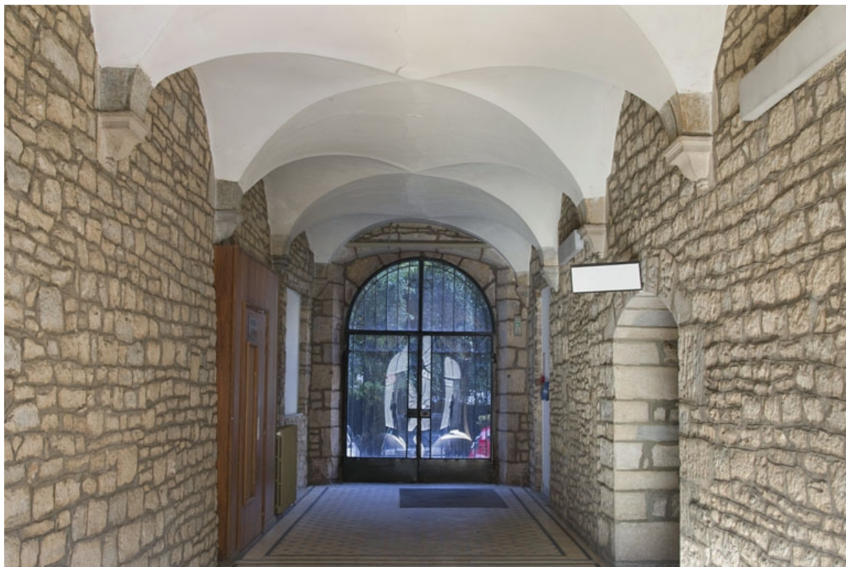
Intérieur : vue d'ensemble du couloir depuis l'entrée.
