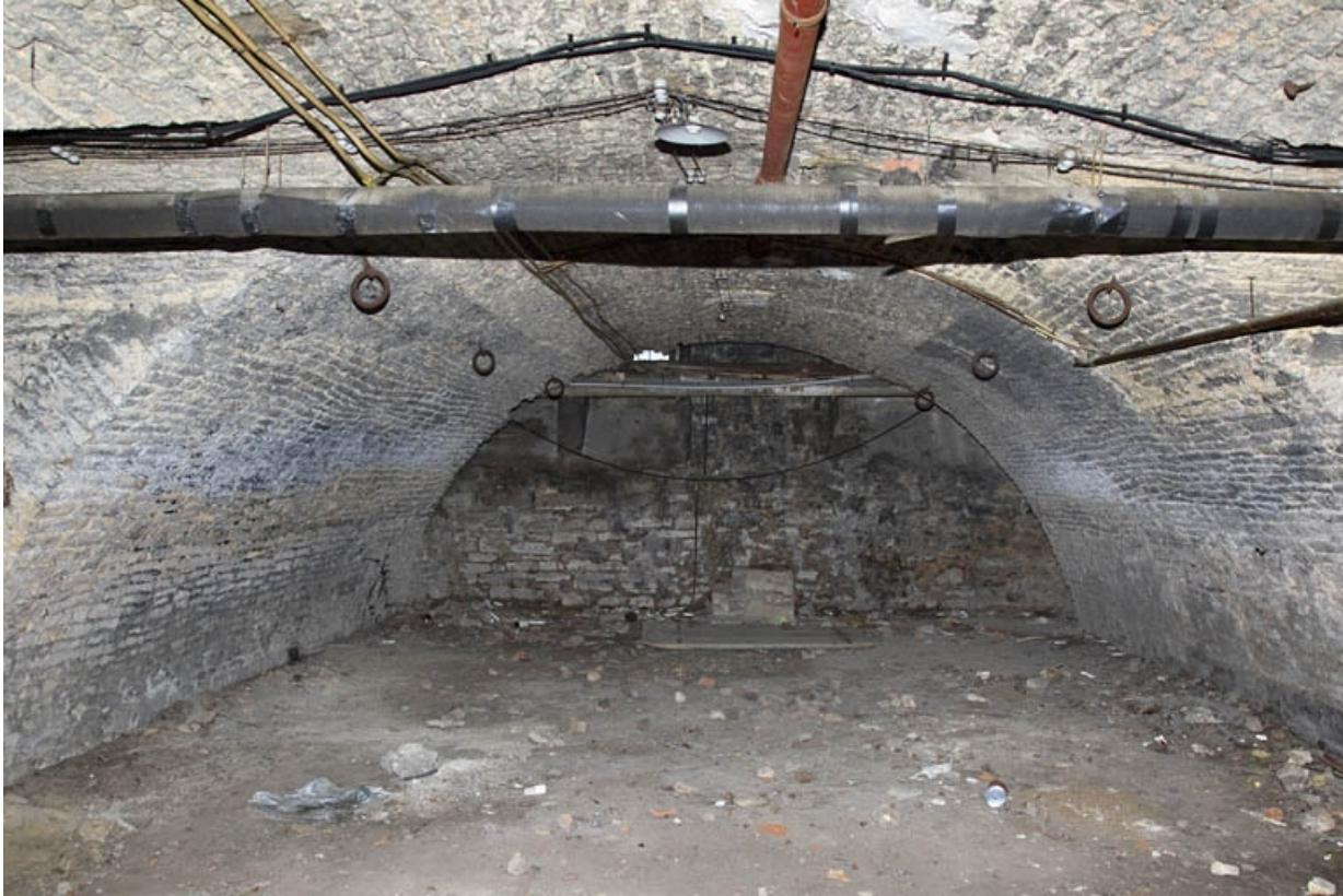
Sous-sol : détail d'une cave voûtée en berceau.
