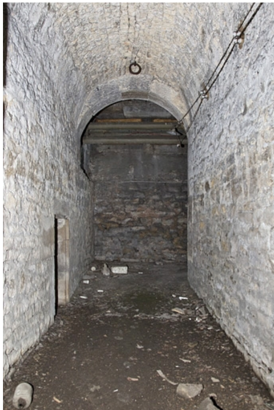
Sous-sol : détail d'un couloir voûté en berceau.
