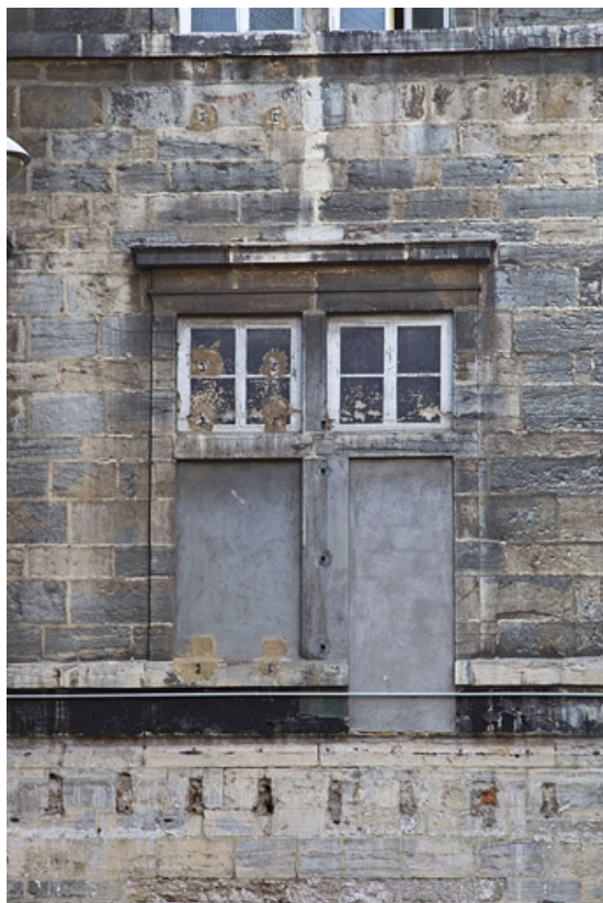
Façade postérieure, tour droite : détail d'une fenêtre du premier étage.
