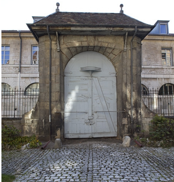
Vue du portail d'entrée depuis la cour, de face.
