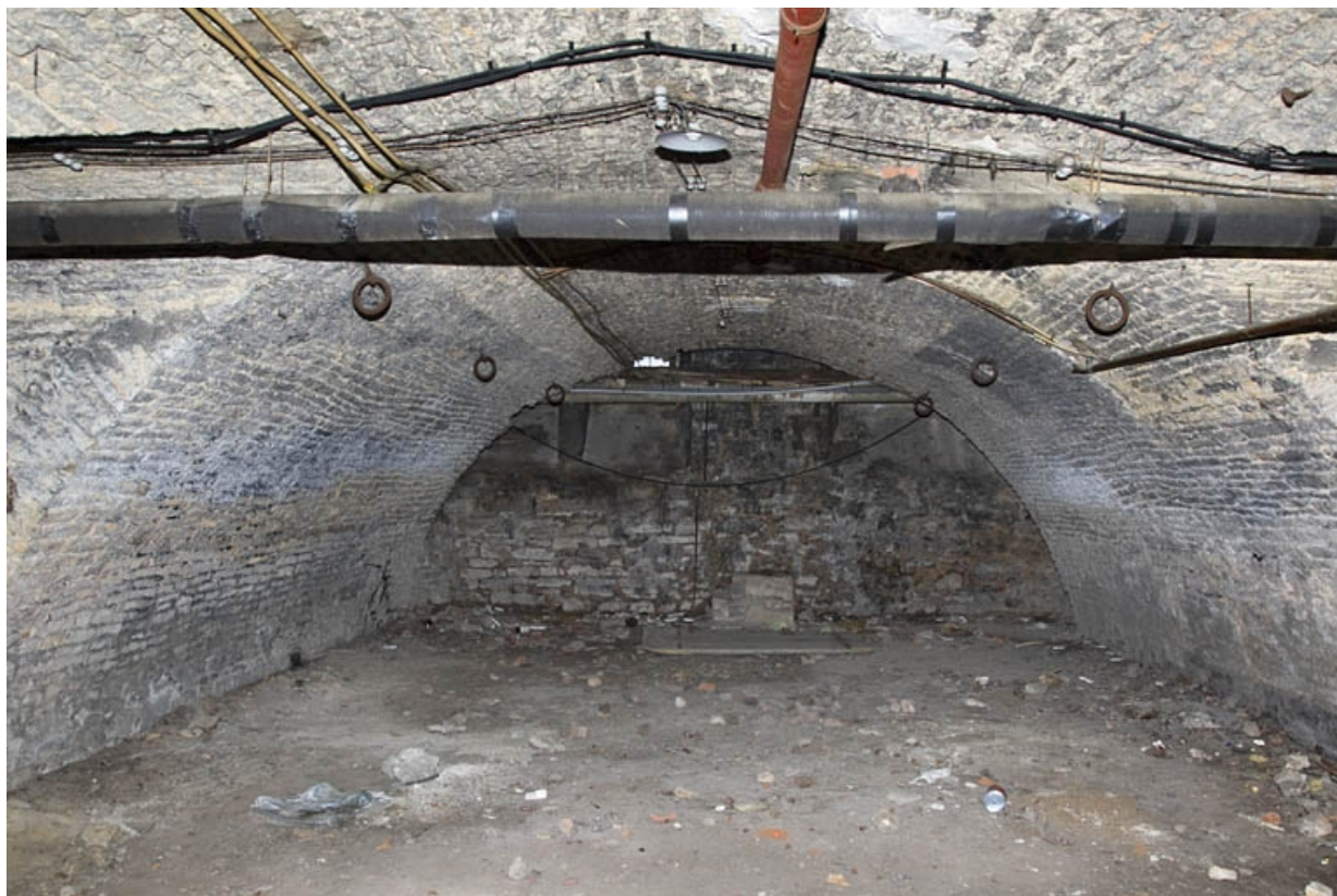
Sous-sol : détail d'une cave voûtée en berceau.
