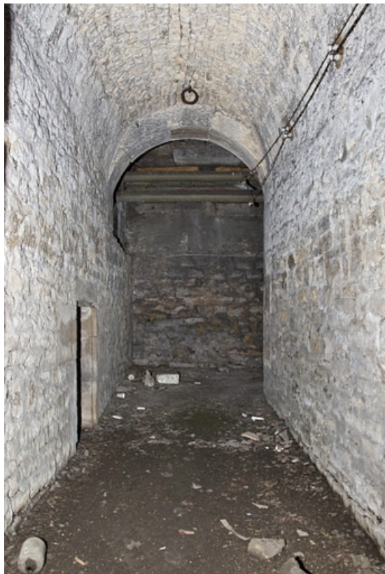
Sous-sol : détail d'un couloir voûté en berceau.
