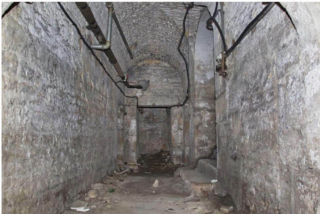
Sous-sol : détail d'un passage donnant sur un escalier de cave.
