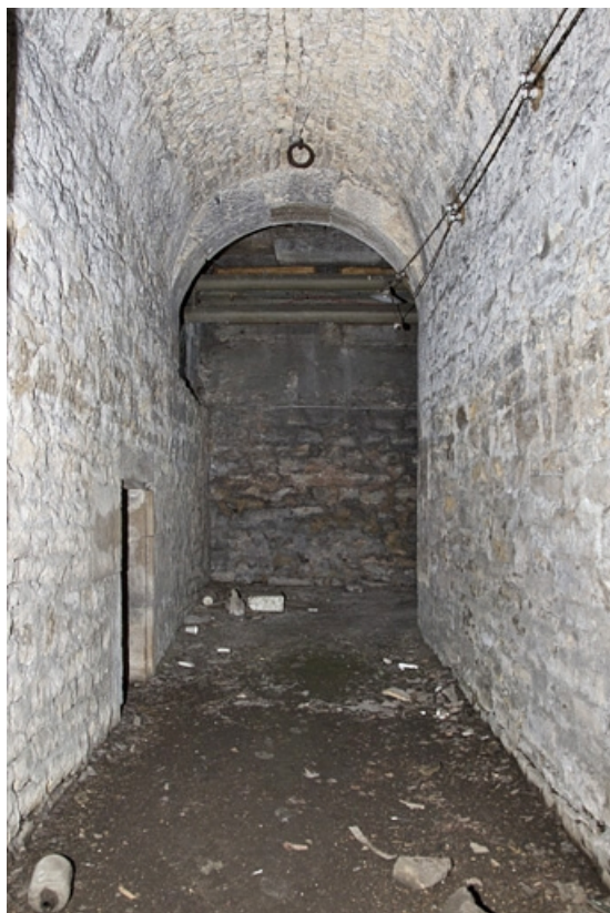
Sous-sol : détail d'un couloir voûté en berceau.
