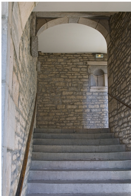
Intérieur : détail de la première volée de l'escalier.
