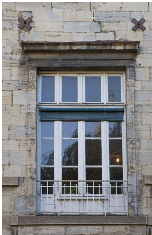
Façade postérieure : détail d'une fenêtre du premier étage.
