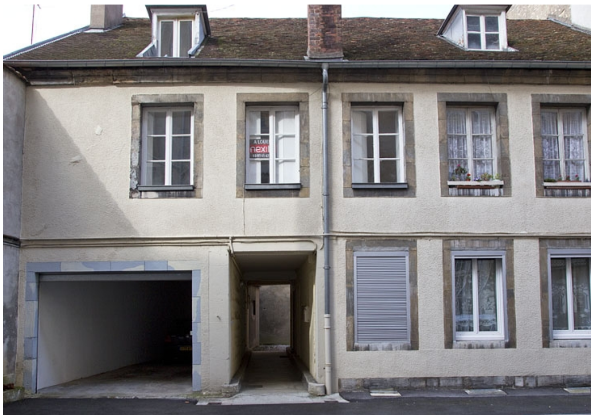
Logis secondaire, façade antérieure, de face. 25, Besançon, 7 rue Morand, lieudit : îlot Morand
