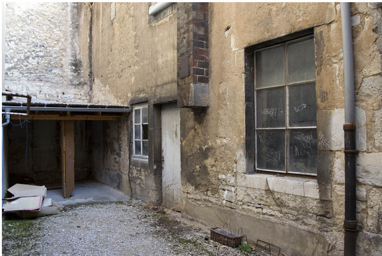
Logis secondaire, détail de la façade postérieure, de trois quarts droit.
