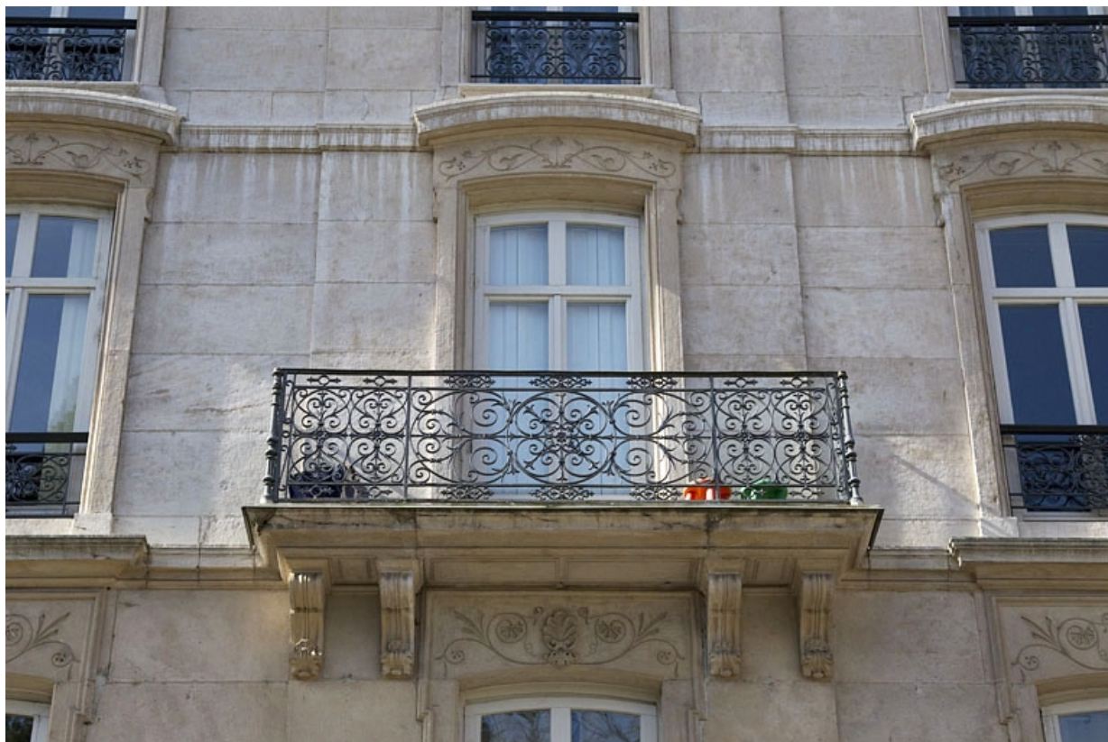
Logis principal, façade antérieure : détail d'un balcon du deuxième étage.
