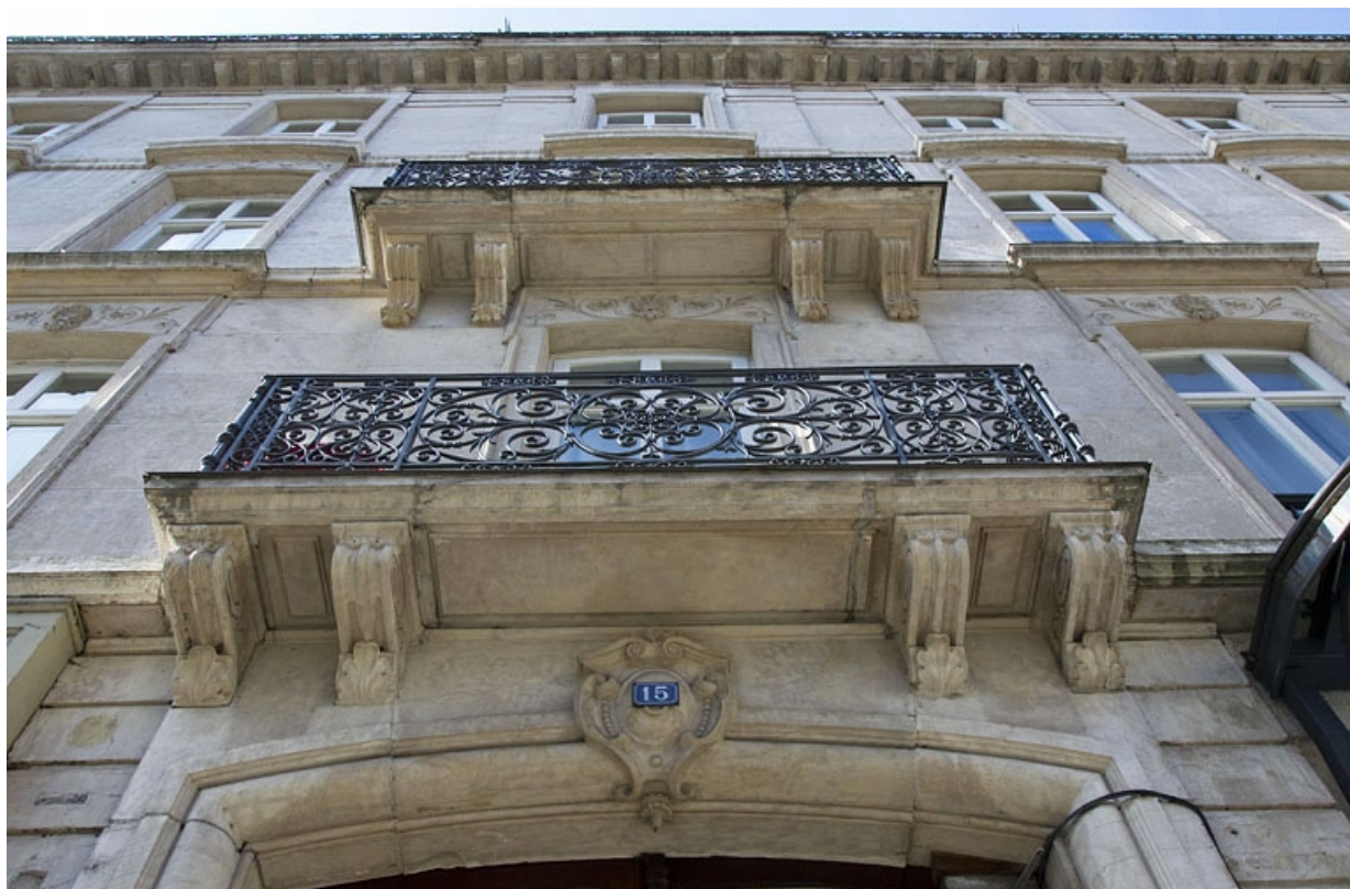
Logis principal, façade antérieure côté rue Proudhon : détail de la partie médiane en contre-plongée. 25, Besançon, 15 rue Proudhon, lieudit : îlot Morand
