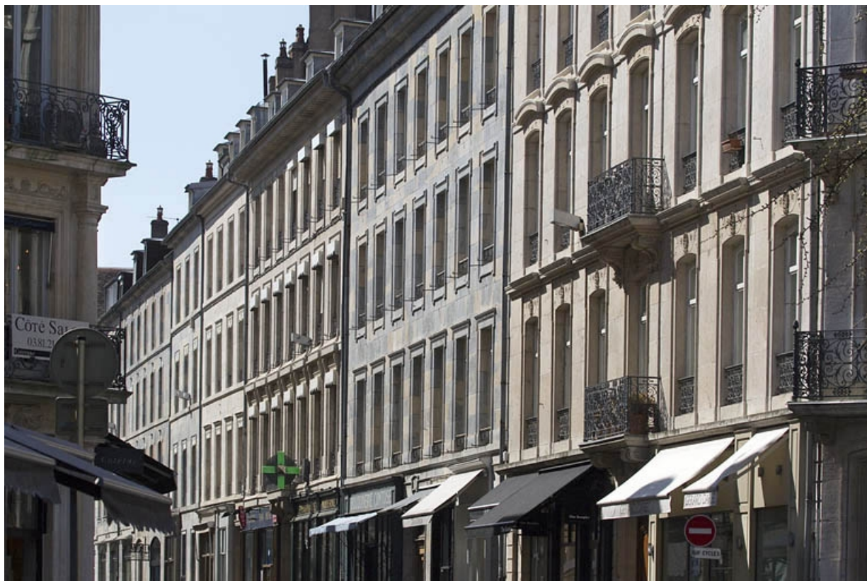
Vue d'ensemble dans l'alignement de la rue Morand, depuis la rue Proudhon. 25, Besançon, 15 rue Proudhon, lieudit : îlot Morand
