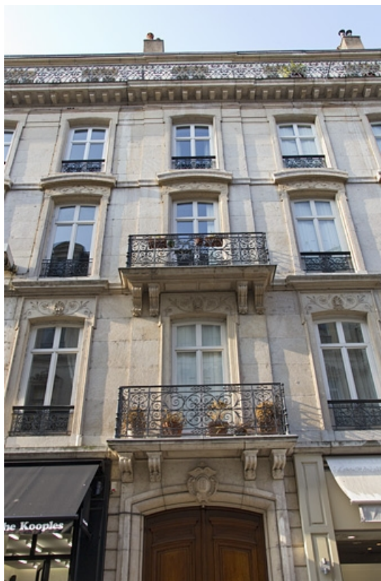
Logis principal, façade antérieure : détail des balcons des premier et deuxième étages côté rue Morand, de face. 25, Besançon, 15 rue Proudhon, lieudit : îlot Morand
