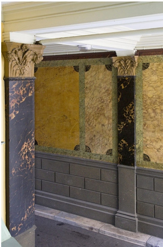
Logis principal, passage cocher côté rue Proudhon : détail du décor en faux marbre, vue rapprochée. 25, Besançon, 15 rue Proudhon, lieudit : îlot Morand
