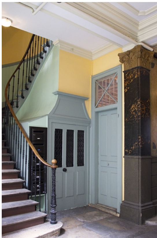
Logis principal, détail du départ de l'escalier à droite du passage cocher côté rue Proudhon. 25, Besançon, 15 rue Proudhon, lieudit : îlot Morand
