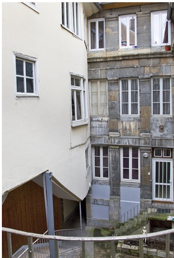
Logis secondaire, deuxième cour, détail de l'escalier à cage ouverte : de trois quarts gauche. 25, Besançon, 49 rue des Granges, lieudit : îlot Morand
