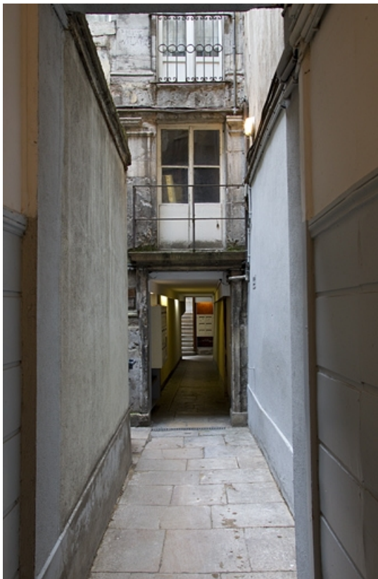
Logis secondaire : vue du couloir en enfilade depuis le couloir du logis principal.
