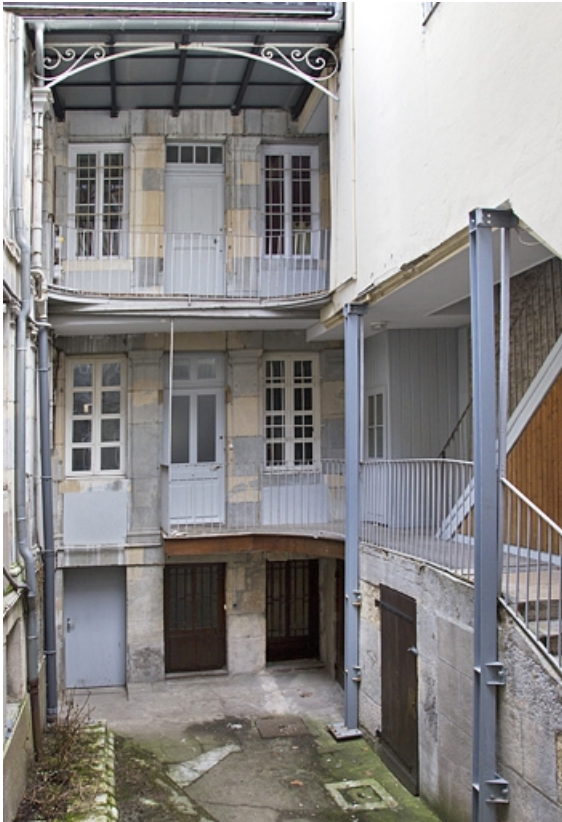
Logis secondaire, deuxième cour, vue d'ensemble de la façade en fond de cour. 25, Besançon, 49 rue des Granges, lieu-dit : îlot Morand
