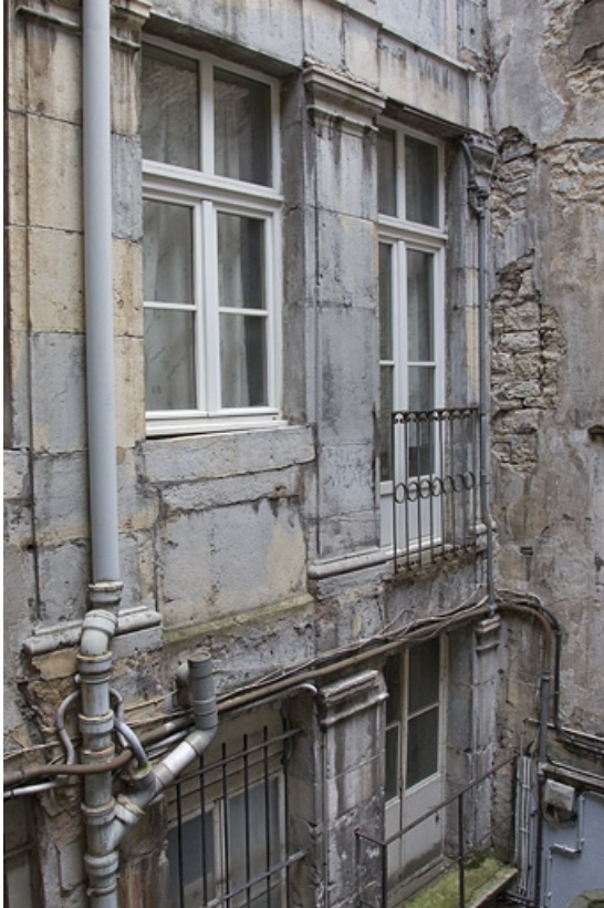
Logis secondaire : détail d'une partie de la façade à partir du premier étage sur la première cour. 25, Besançon, 49 rue des Granges, lieudit : îlot Morand
