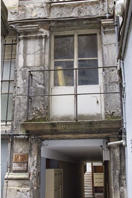
Logis secondaire : détail de la porte-fenêtre du premier étage au-dessus du couloir sur la première cour. 25, Besançon, 49 rue des Granges, lieudit : îlot Morand
