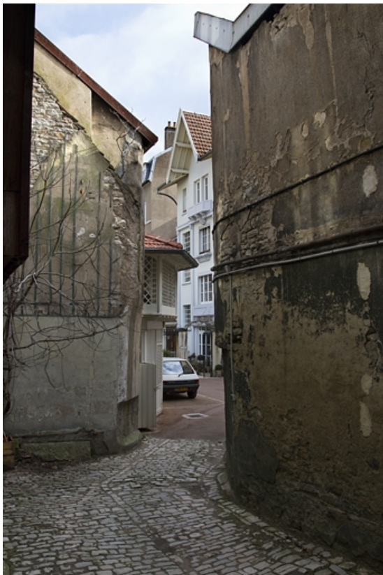
Vue d'ensemble du passage entre la deuxième et la troisième cour.
