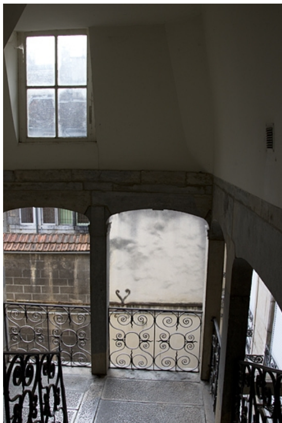
Logis principal : détail des garde-corps en ferronnerie de l'escalier à cage ouverte depuis l'intérieur. 25, Besançon, 35 rue des Granges, lieu-dit : îlot Morand
