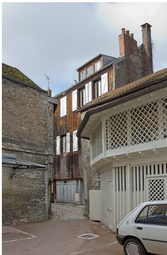
Vue d'ensemble du logis secondaire en aile dans la deuxième cour, depuis la troisième cour. 25, Besançon, 35 rue des Granges, lieudit : îlot Morand
