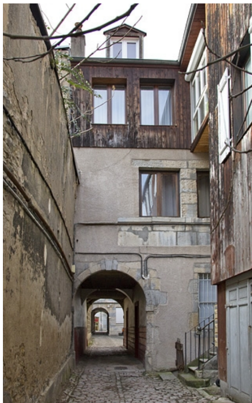
Vue d'ensemble de la façade postérieure du premier logis secondaire donnant sur la deuxième cour. 25, Besançon, 35 rue des Granges, lieudit : îlot Morand
