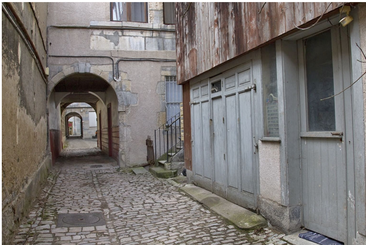
Vue d'ensemble des passages cochers en enfilade depuis la deuxième cour. 25, Besançon, 35 rue des Granges, lieudit : îlot Morand
