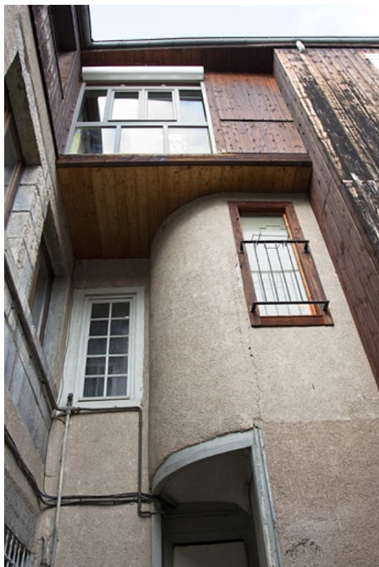
Vue d'ensemble de l'escalier distribuant les logis secondaires des première et deuxième cours.
