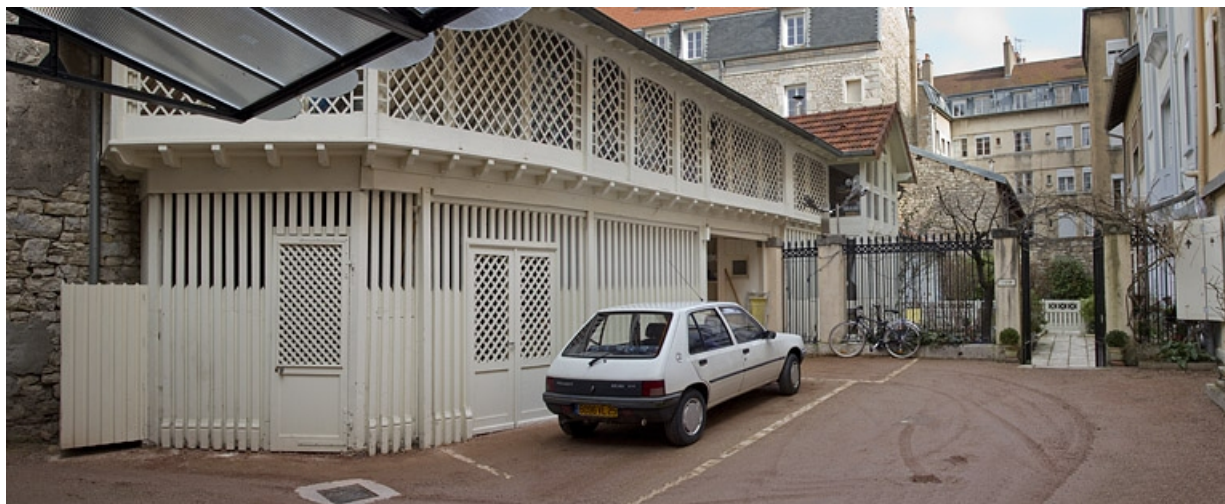
Vue d'ensemble du bûcher dans la troisième cour, de trois quarts gauche.
