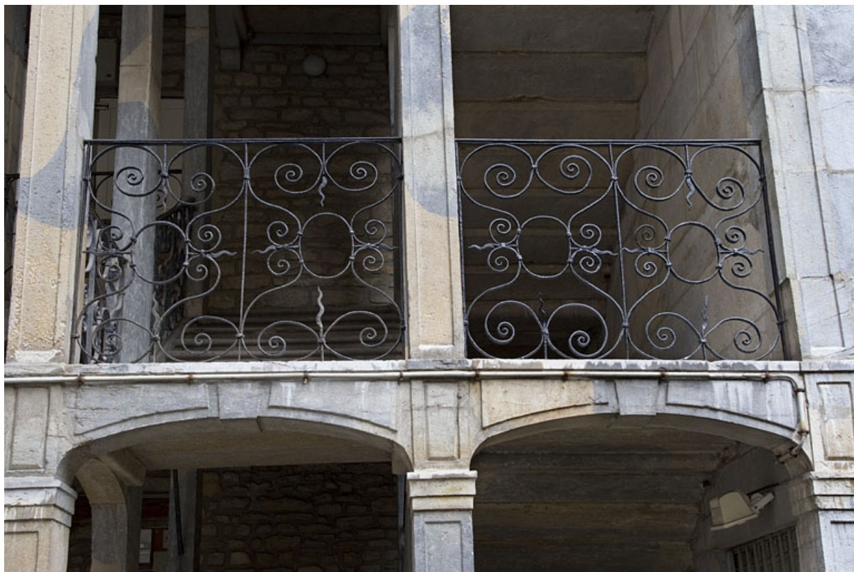
Logis principal : détail des garde-corps en ferronnerie de l'escalier à cage ouverte depuis l'extérieur.
