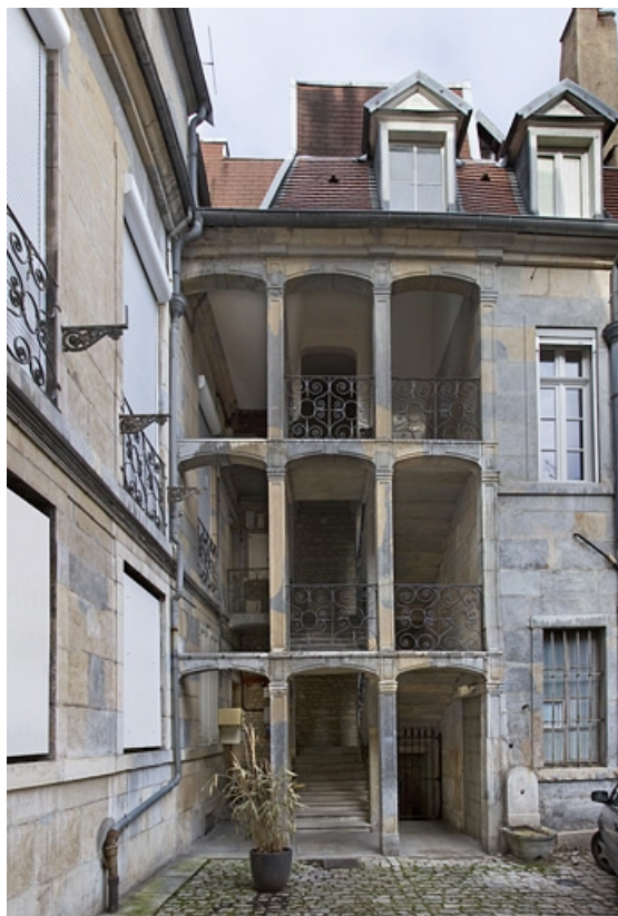
Vue d'ensemble de l'escalier à cage ouverte du logis principal, de face.
