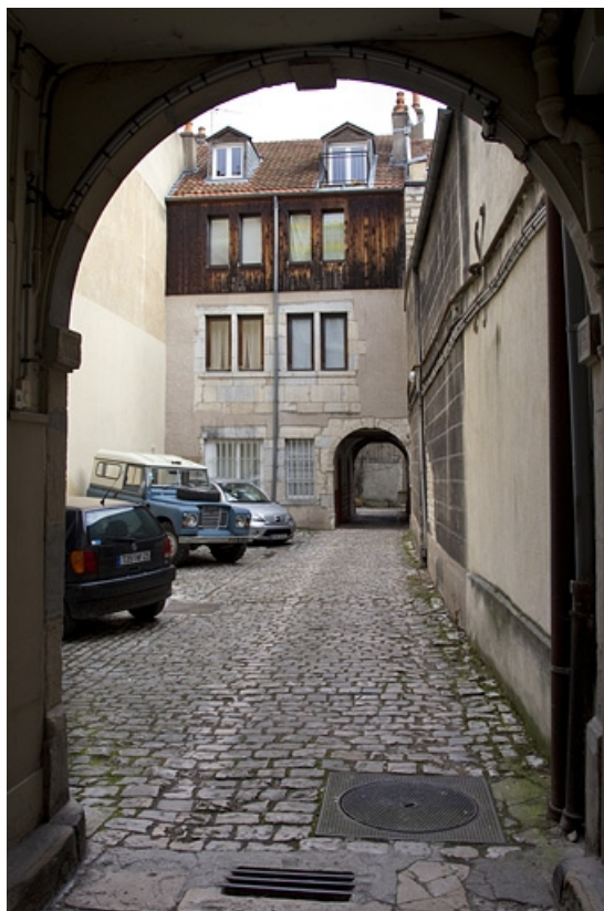
Vue d'ensemble du premier logis secondaire au fond de la première cour.
