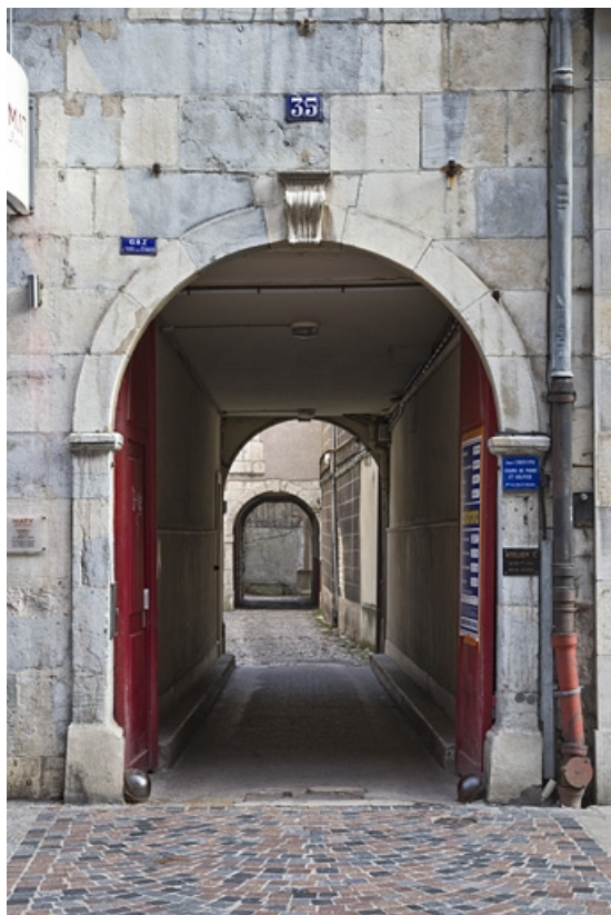
Logis principal, façade antérieure : détail du portail d'entrée et du passage cocher, vue rapprochée. 25, Besançon, 35 rue des Granges, lieudit : îlot Morand
