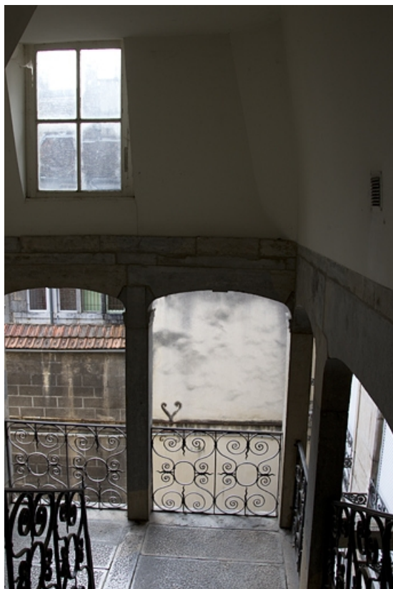
Logis principal : détail des garde-corps en ferronnerie de l'escalier à cage ouverte depuis l'intérieur. 25, Besançon, 35 rue des Granges, lieu-dit : îlot Morand
