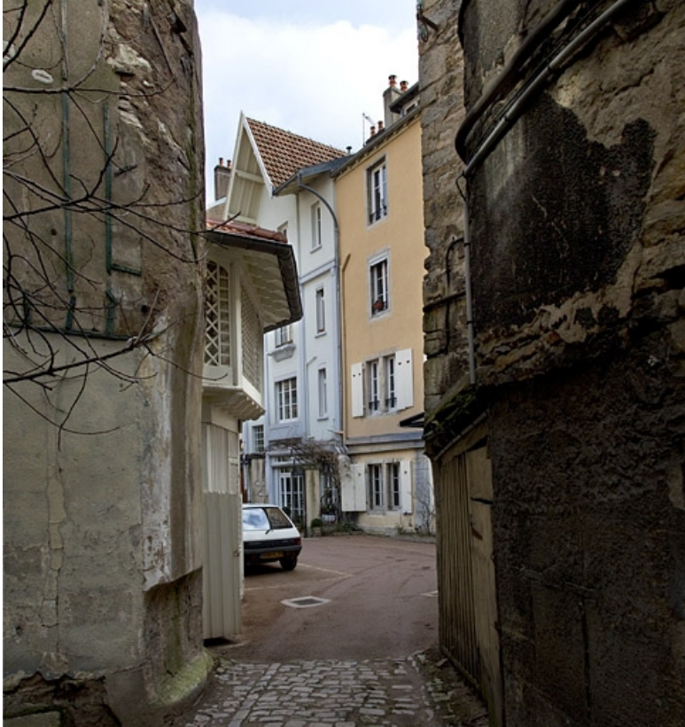
Vue d'ensemble de la troisième cour depuis son entrée.
