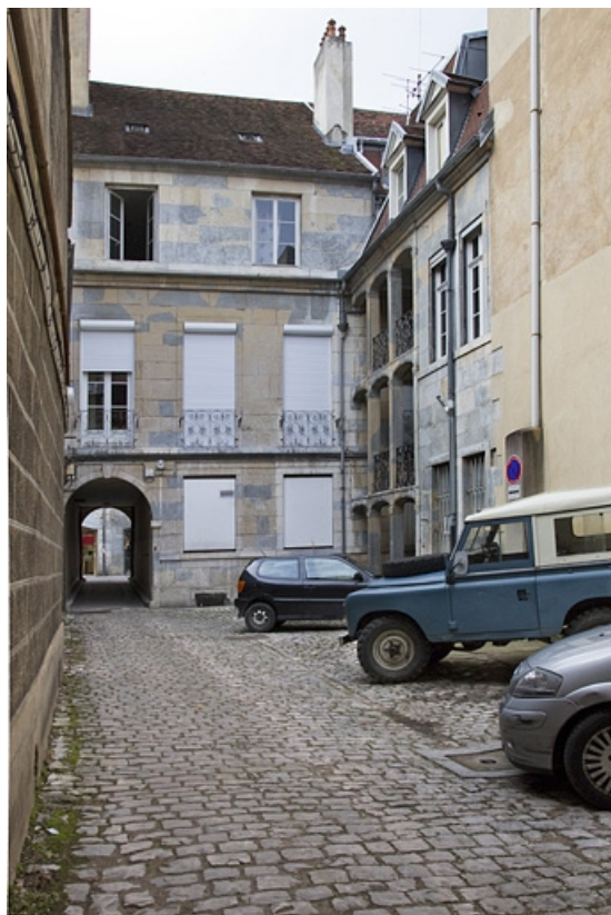
Vue d'ensemble de la façade postérieure du logis principal depuis le fond de la première cour. 25, Besançon, 35 rue des Granges, lieudit : îlot Morand
