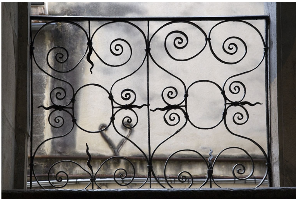
Logis principal : détail d'un garde-corps en ferronnerie de l'escalier à cage ouverte. 25, Besançon, 35 rue des Granges, lieu-dit : îlot Morand
