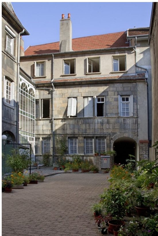
Logis principal : vue d'ensemble de la façade postérieure, depuis le fond de la cour. 25, Besançon, 12 rue du Lycée, lieudit : îlot Saint-Jacques
