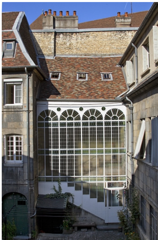
Escalier à cage ouverte sur cour : vue d'ensemble.
