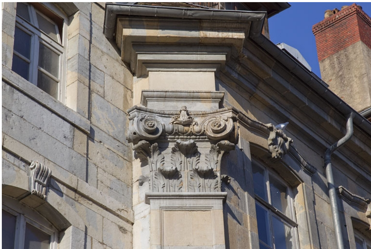
Façade extérieure, rue du lycée : détail du chapiteau corinthien du pilastre d'angle.
