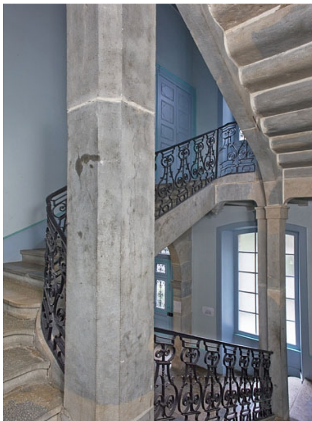
Intérieur : vue d'ensemble de l'escalier, de trois quarts gauche.
