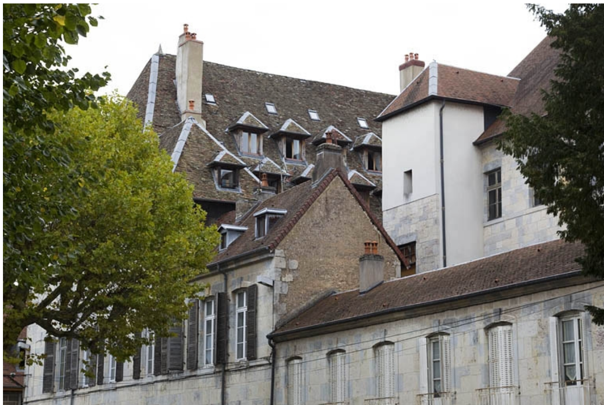
Façade latérale droite : vue d'ensemble de trois quarts droit.
