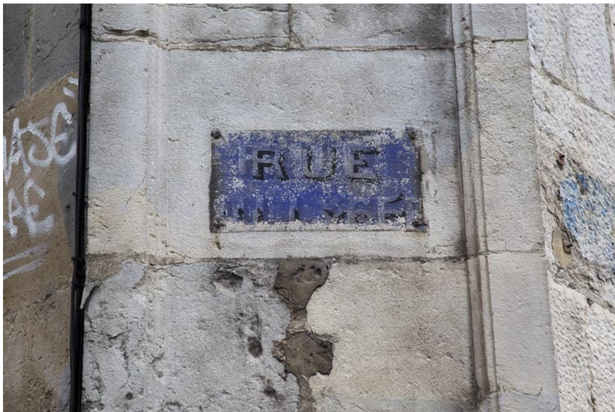
Angle droit de la façade antérieure : plaque peinte de l'ancien nom de la rue. 25, Besançon, 6 rue du Lycée, lieudit : îlot Saint-Jacques
