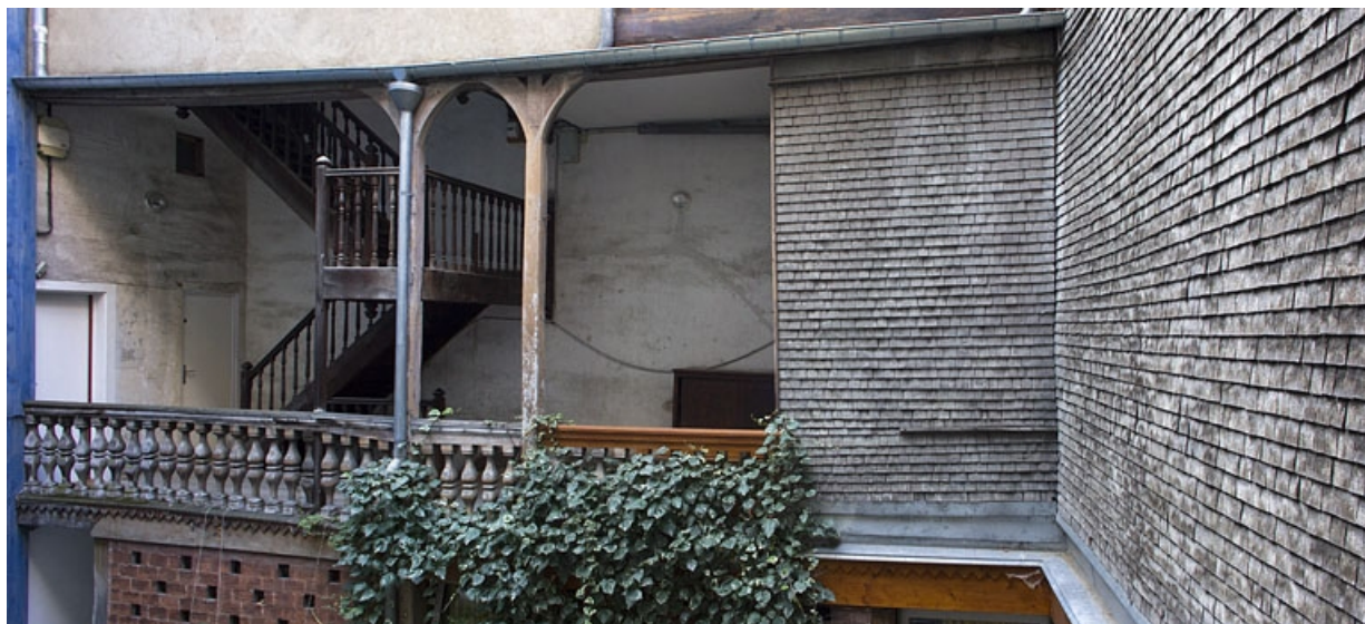
Aile de l'escalier à cage ouverte : détail de la partie supérieure, de face.
