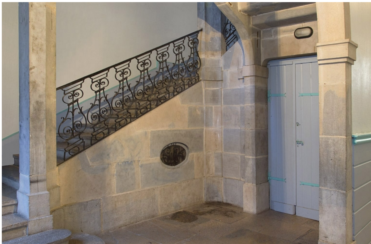
Intérieur, escalier : détail de la rampe en ferronnerie.
