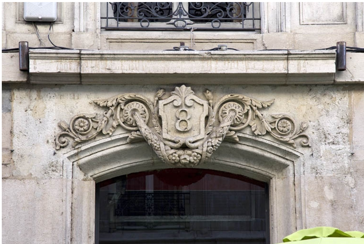
Façade antérieure, porte du couloir : détail du décor du linteau.
