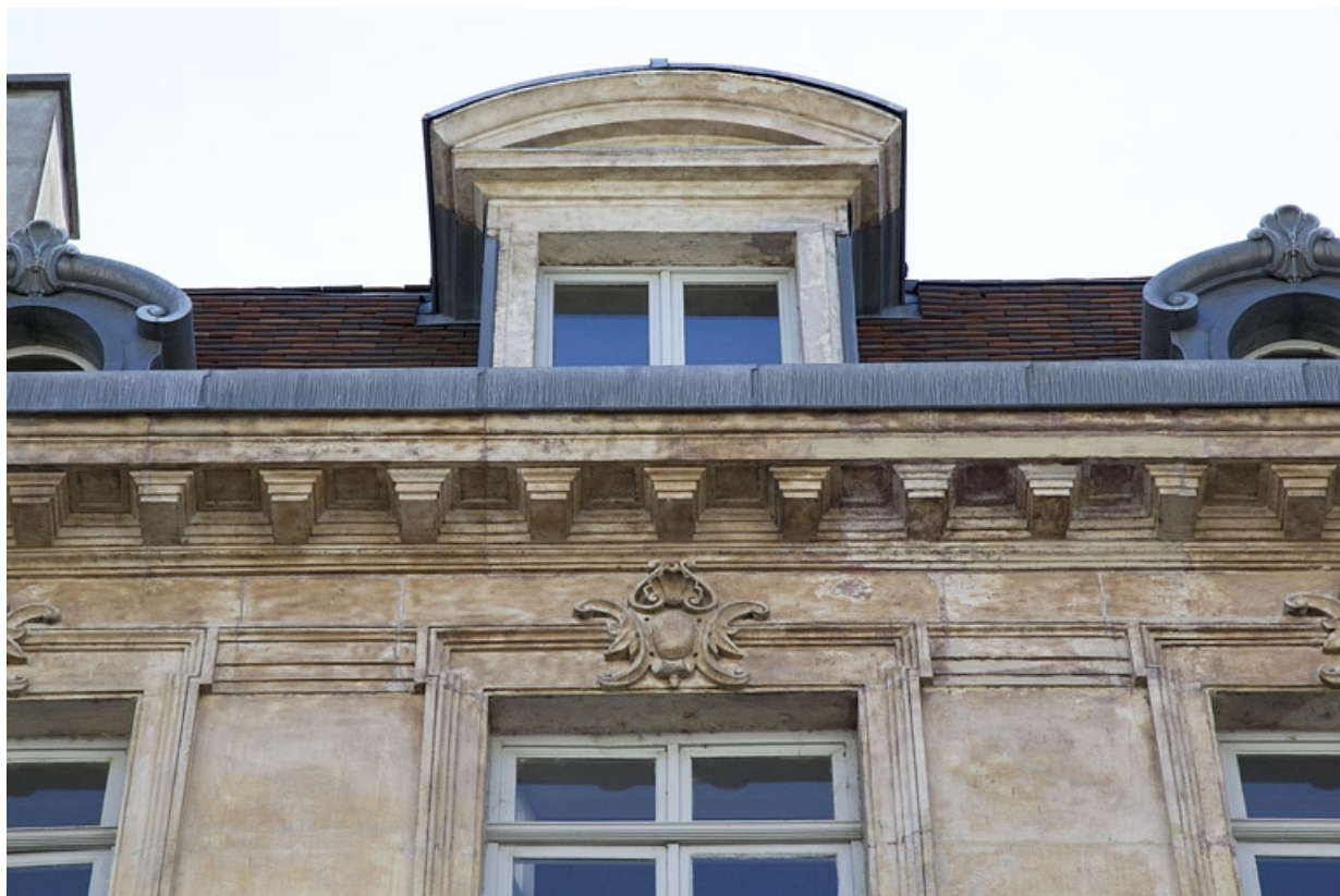
Façade antérieure : détail du décor d'un linteau de fenêtre du troisième étage.
