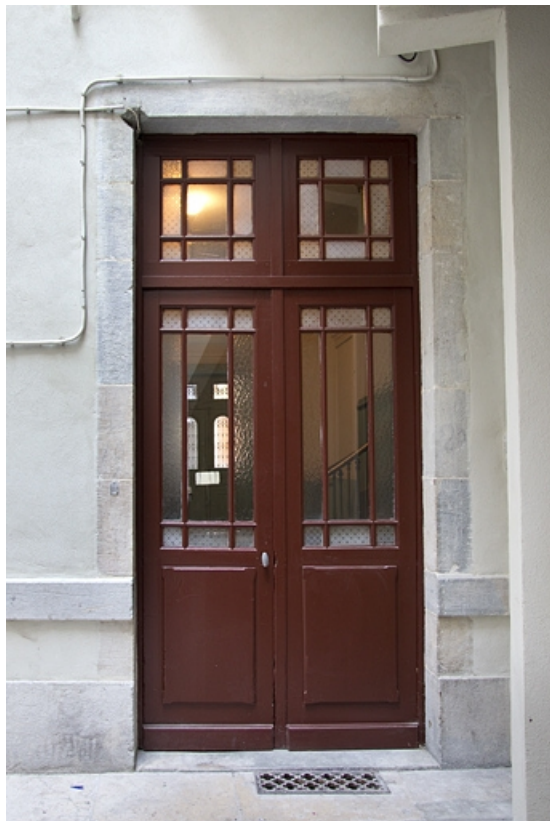
Détail de la porte donnant accès à la cour.
