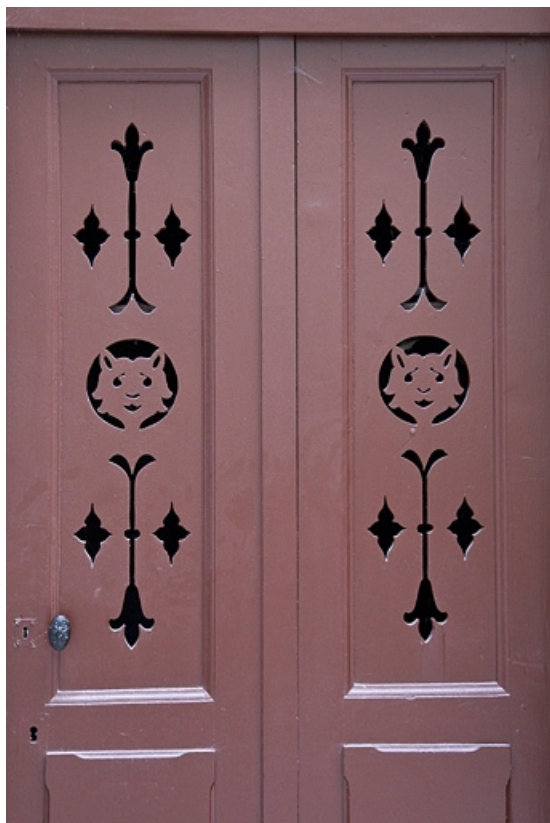
Bûcher : vue d'ensemble de la porte.
