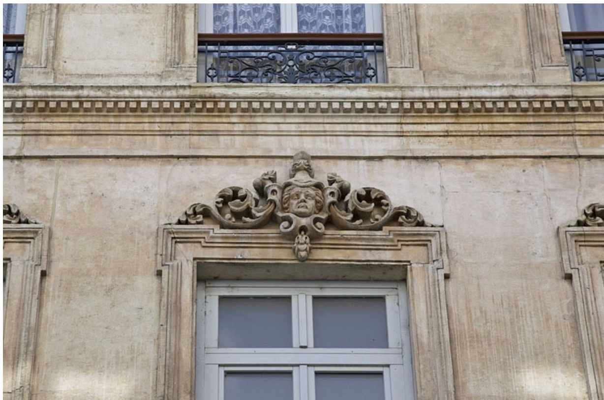
Façade antérieure : détail d'un mascaron sur le linteau d'une fenêtre du deuxième étage.
