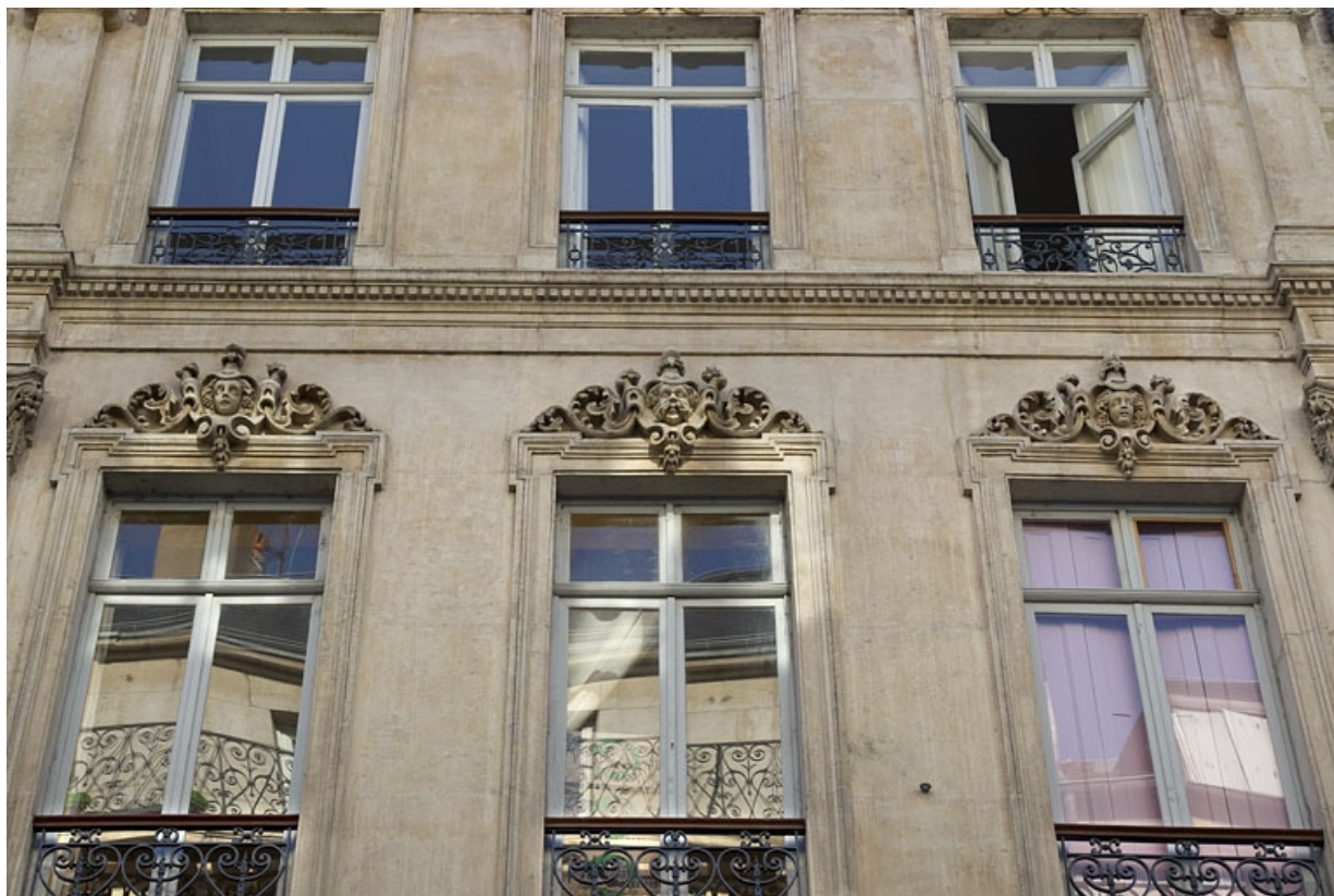
Façade antérieure, vue d'une partie du deuxième étage.
