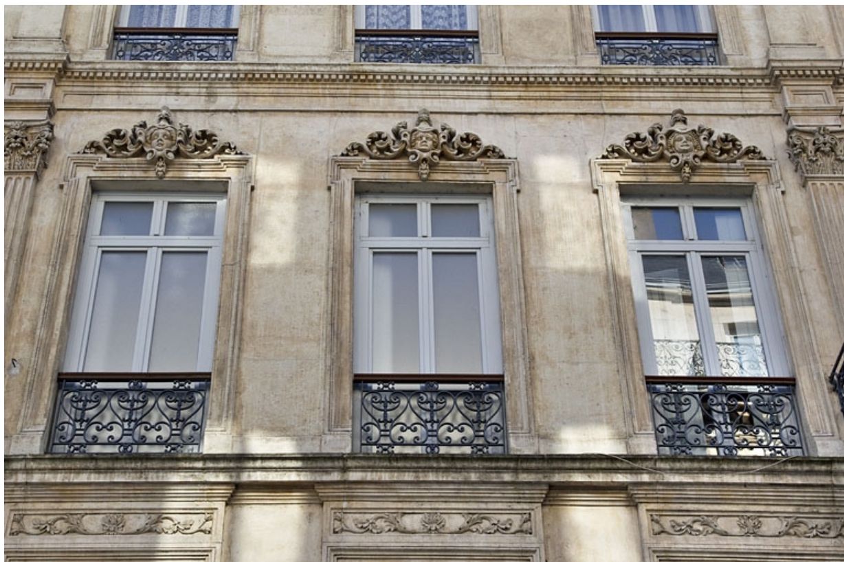
Façade antérieure : vue d'une partie du deuxième étage et des linteaux de fenêtres du premier étage.
