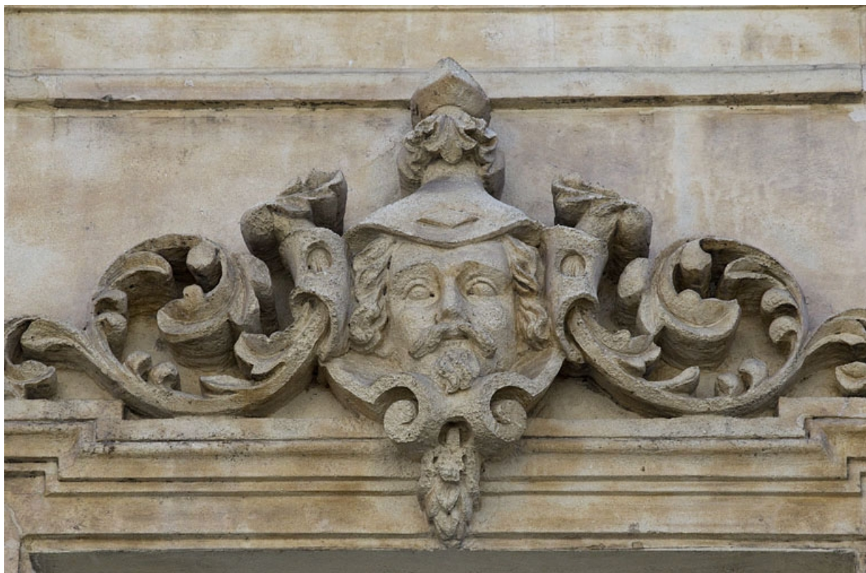
Façade antérieure, vue rapprochée d'un mascaron sur une fenêtre du deuxième étage : personnage masculin.
