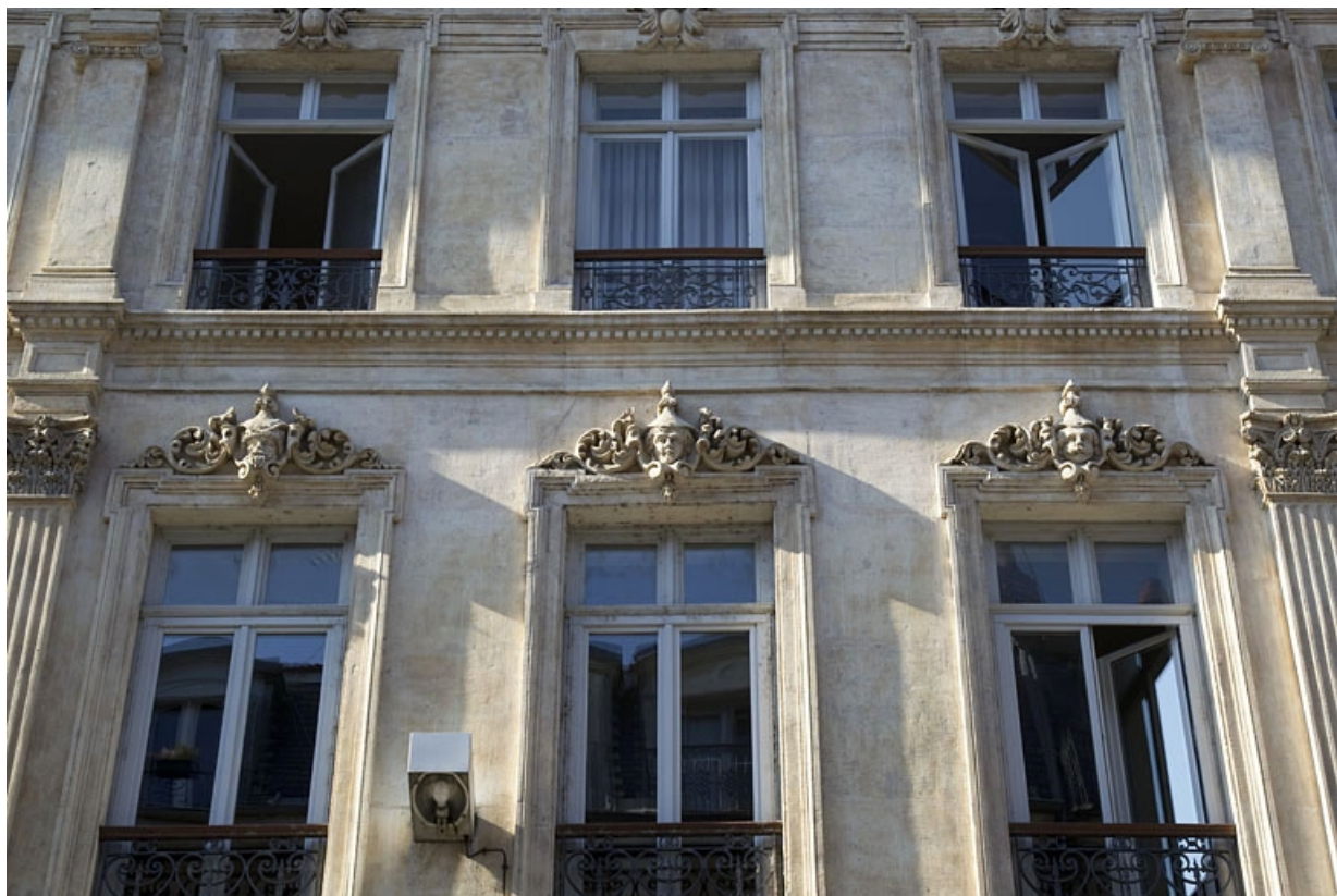
Façade antérieure, rue Proudhon, deuxième étage : détail des trois fenêtres du milieu.
