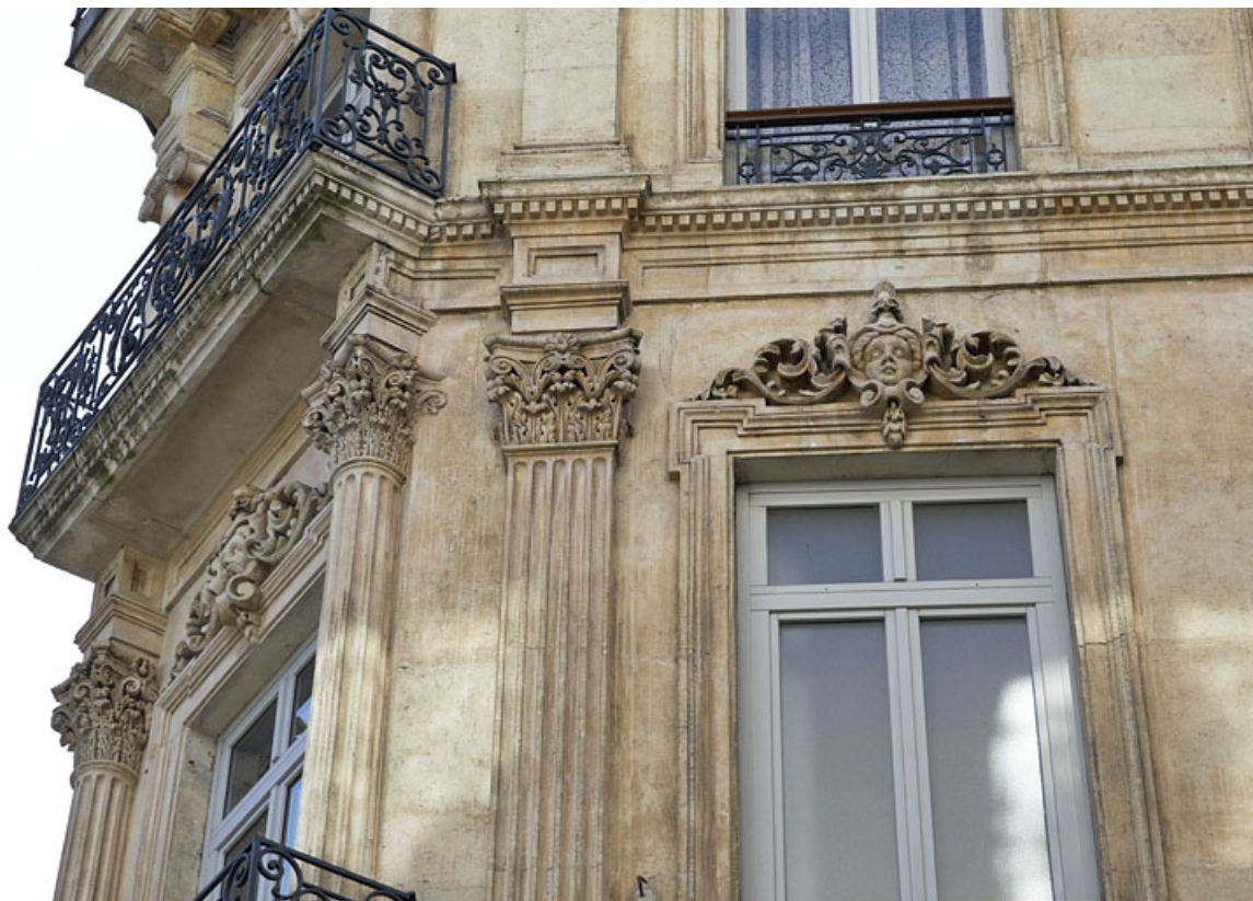
Façade antérieure : détail du pan coupé au niveau du deuxième étage.
