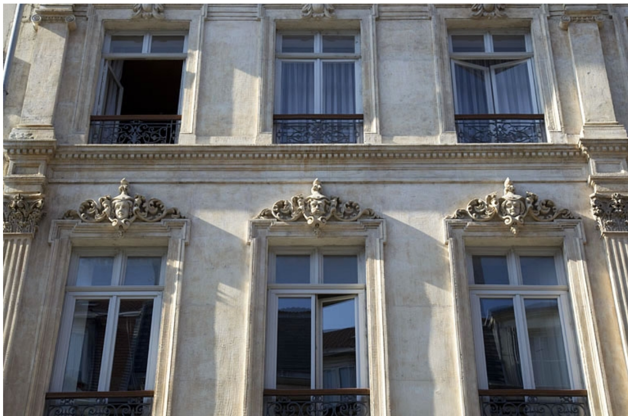
Façade antérieure, rue Proudhon, deuxième étage : détail des trois fenêtres de gauche.
