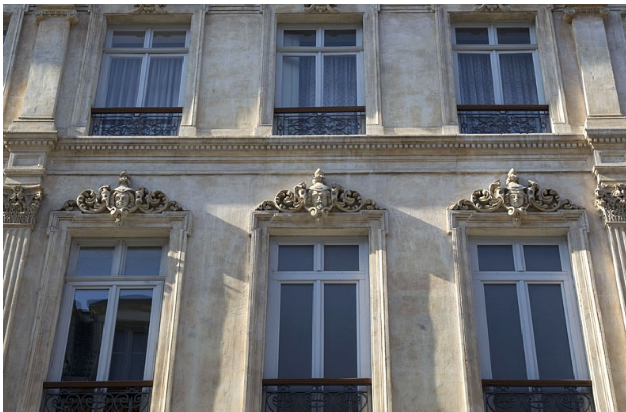
Façade antérieure, rue Proudhon, deuxième étage : détail des trois fenêtres de droite. 25, Besançon, 16 rue Morand, lieudit : îlot Proudhon
