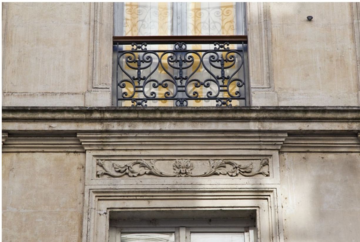
Façade antérieure : détail d'un garde-corps d'une fenêtre.
