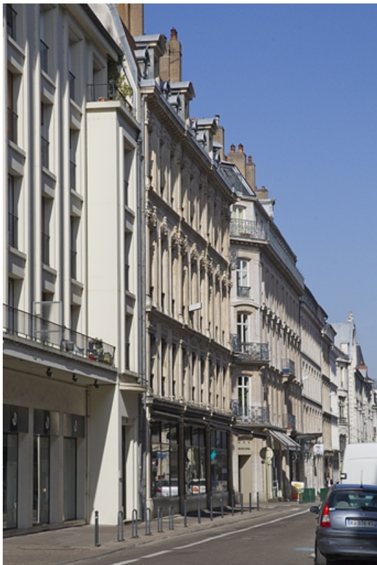
Vue d'ensemble éloignée de la façade donnant sur la rue Proudhon.
