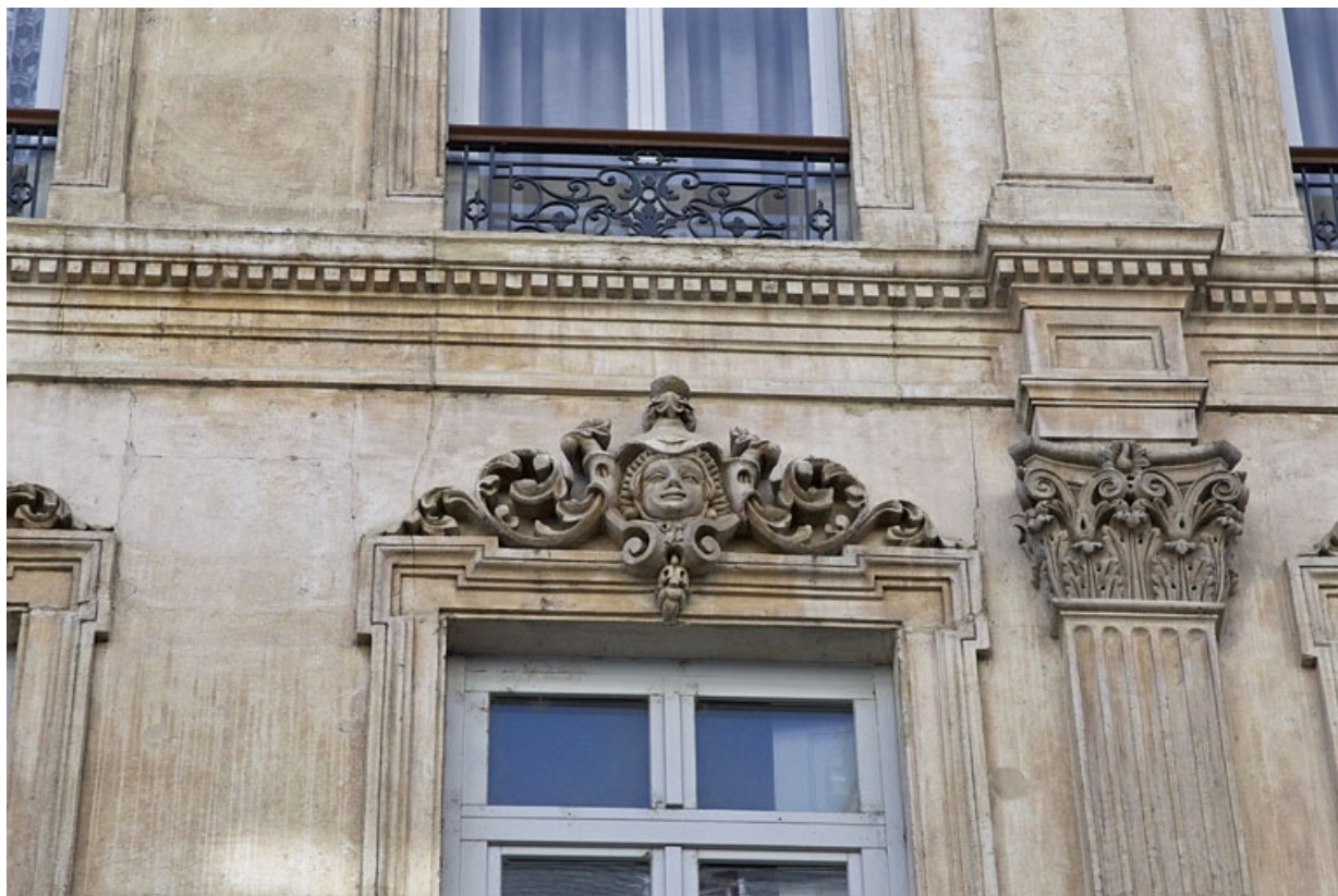
Façade antérieure : détail d'un mascaron sur le linteau d'une fenêtre du deuxième étage.
