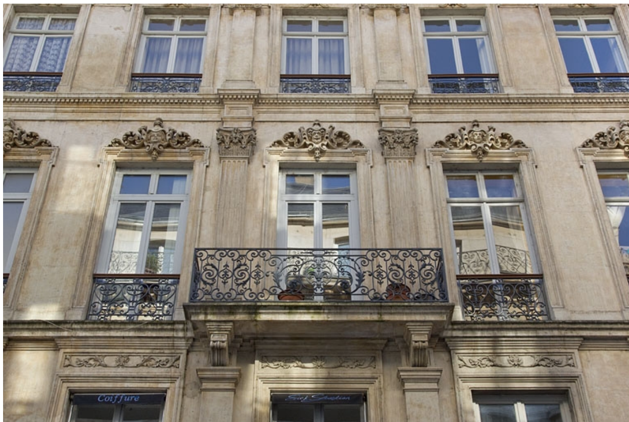
Façade antérieure, rue Morand, deuxième étage, partie centrale.
