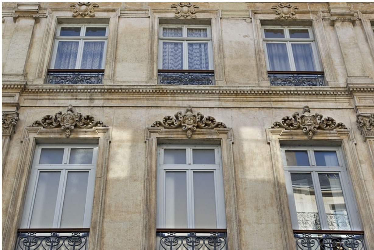
Façade antérieure : vue d'une partie du deuxième et du troisième étage.
