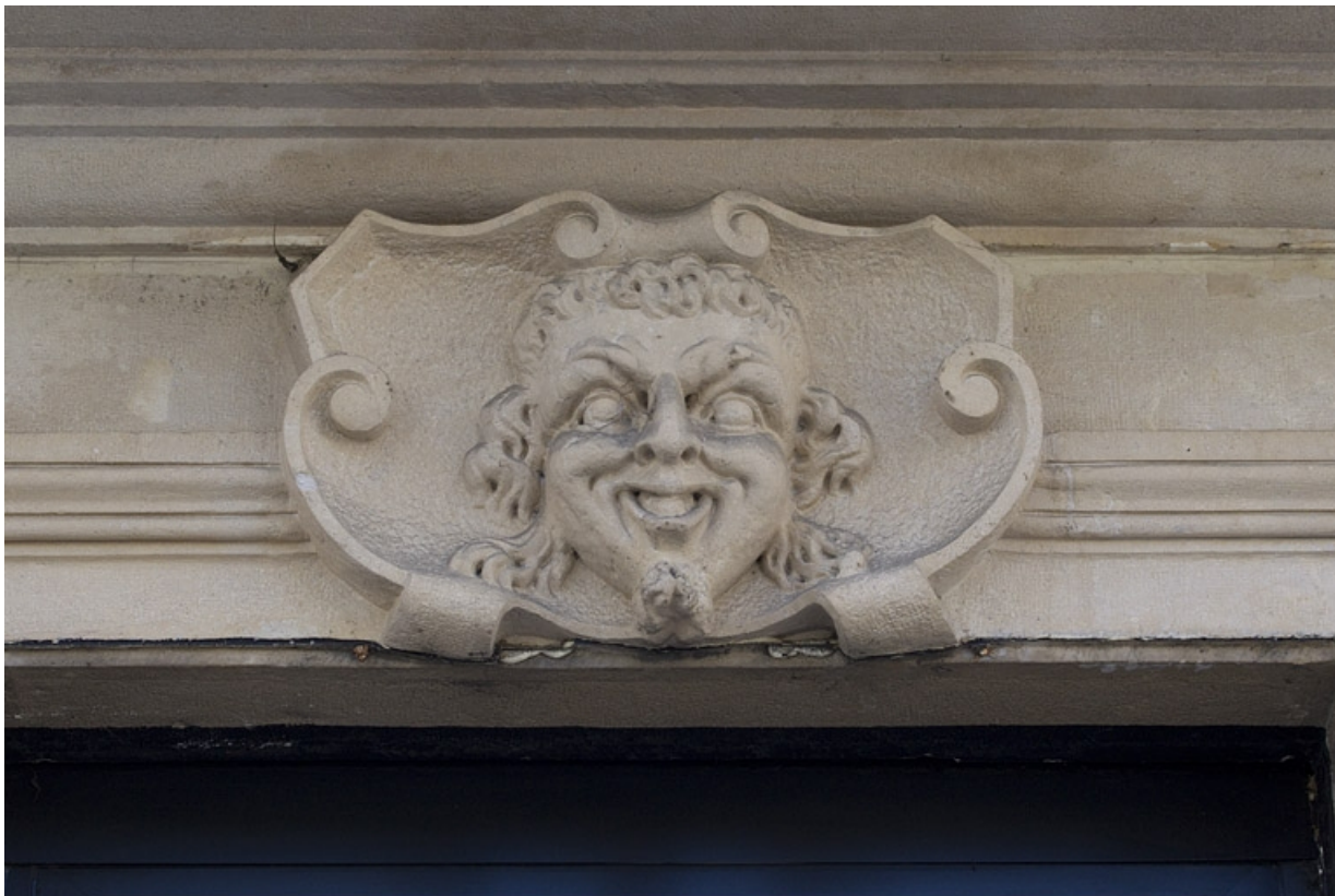
Façade antérieure, vue rapprochée d'un mascaron sur la porte d'entrée du magasin.
