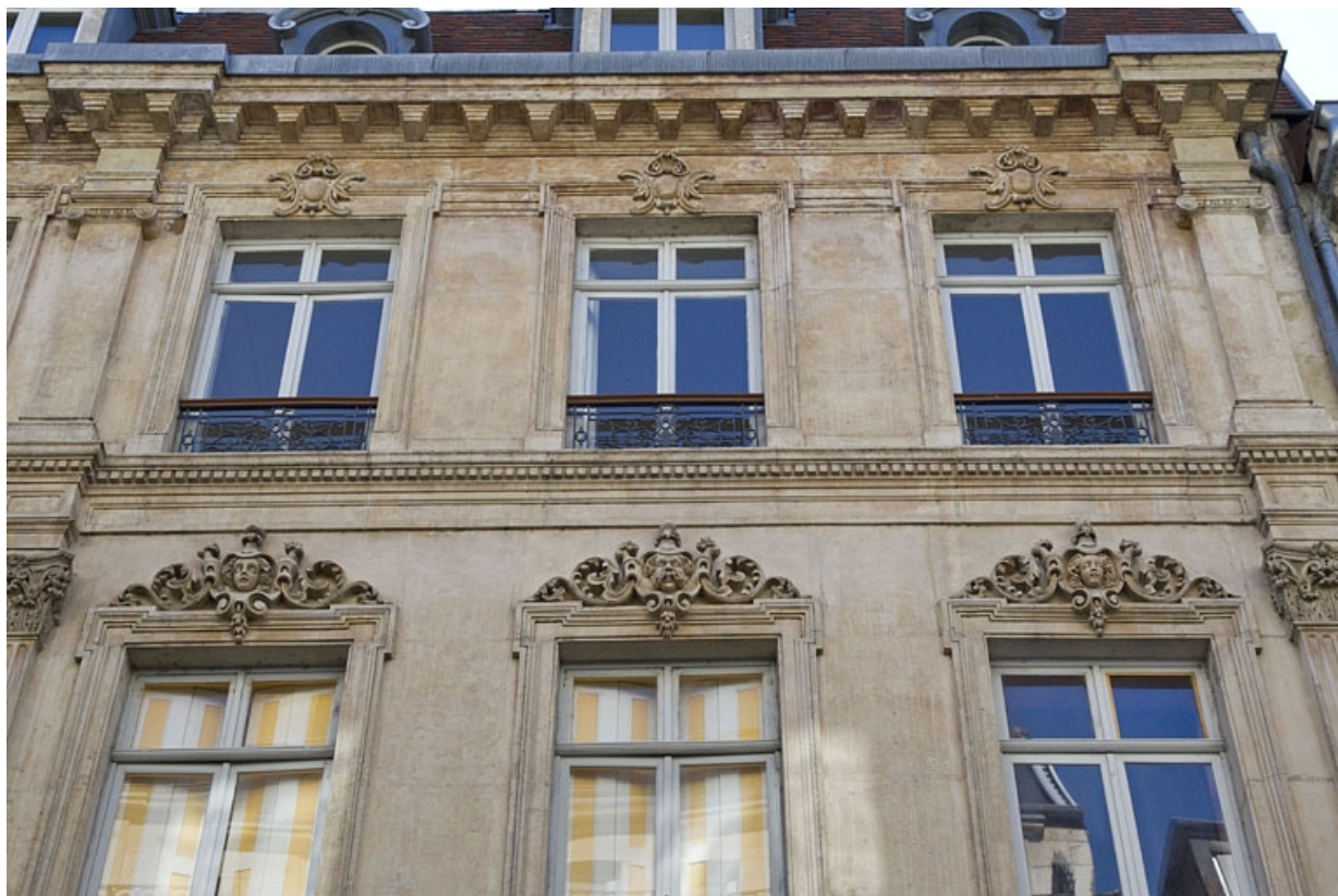
Façade antérieure : détail de trois fenêtres des deuxième et troisième étages. 25, Besançon, 16 rue Morand, lieudit : îlot Proudhon
