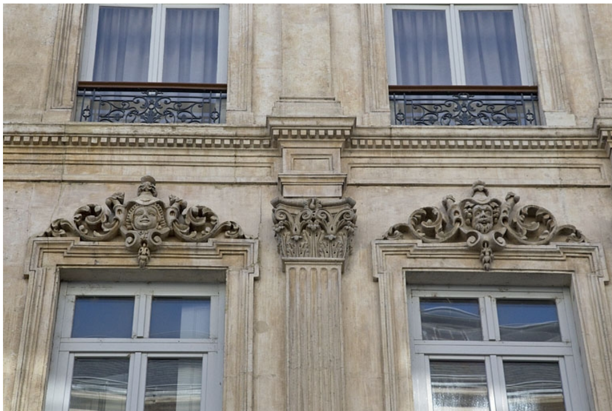
Façade antérieure : détail de deux mascarons sur les linteaux de deux fenêtres du deuxième étage.
