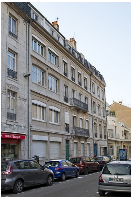
Vue d'ensemble rapprochée, de trois quarts gauche. 25, Besançon
