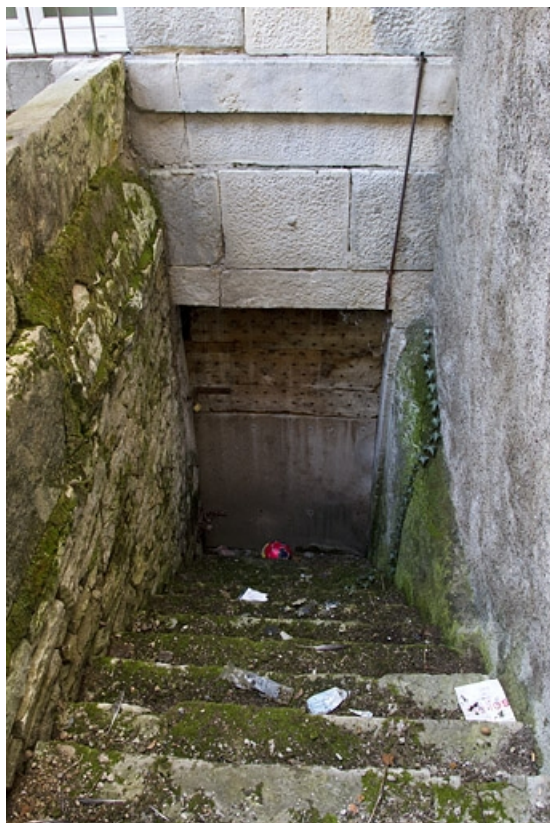
Détail de l'entrée de cave du deuxième logis secondaire.
