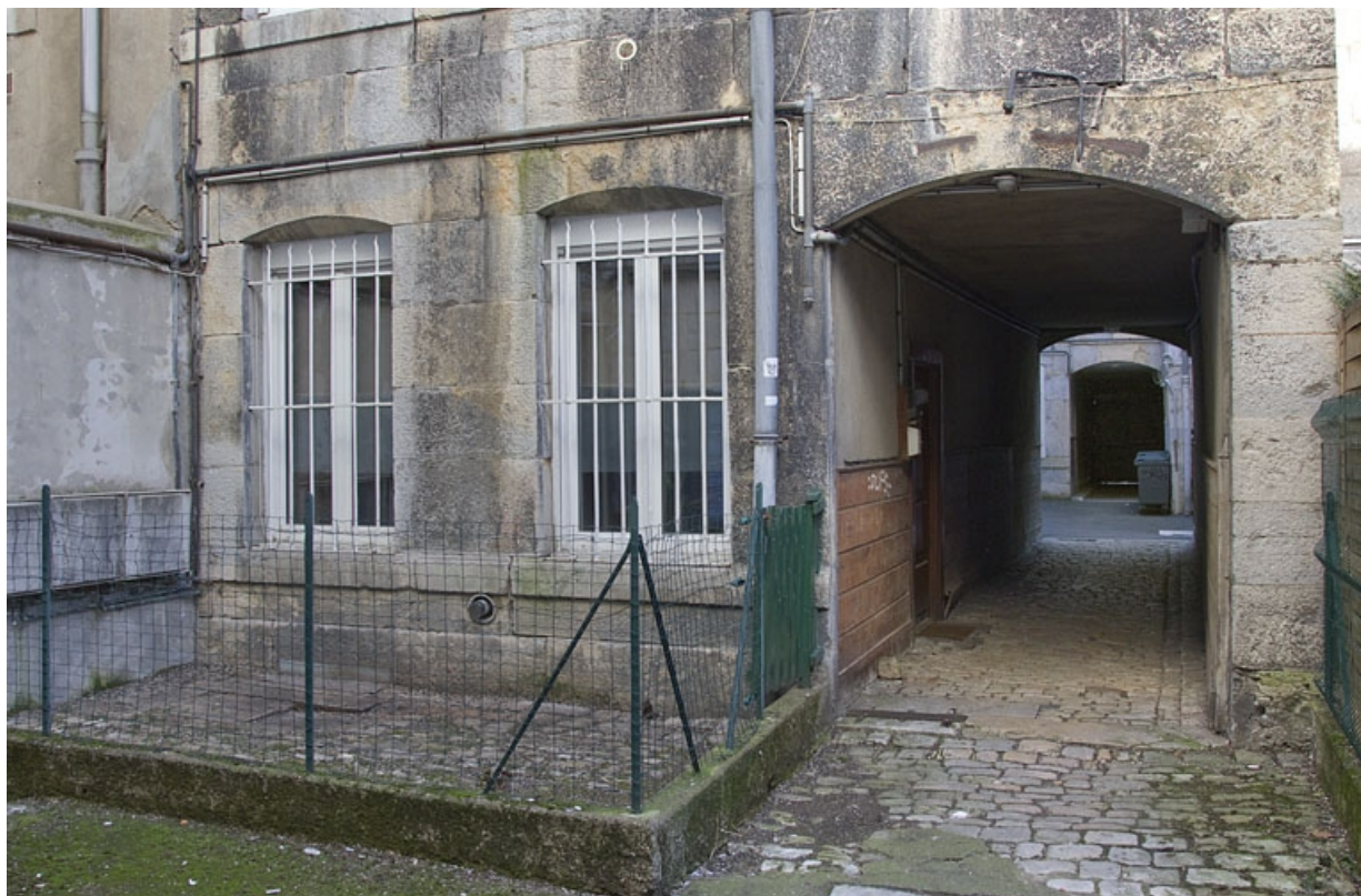
Deuxième cour, façade postérieure du premier logis secondaire : détail du rez-de-chaussée.
