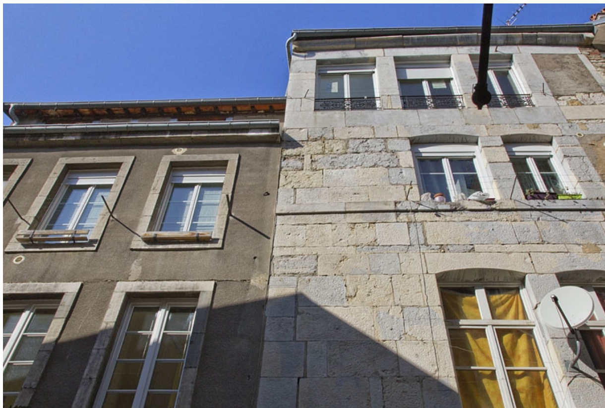
Deuxième logis secondaire : détail de la partie supérieure de la façade postérieure.
