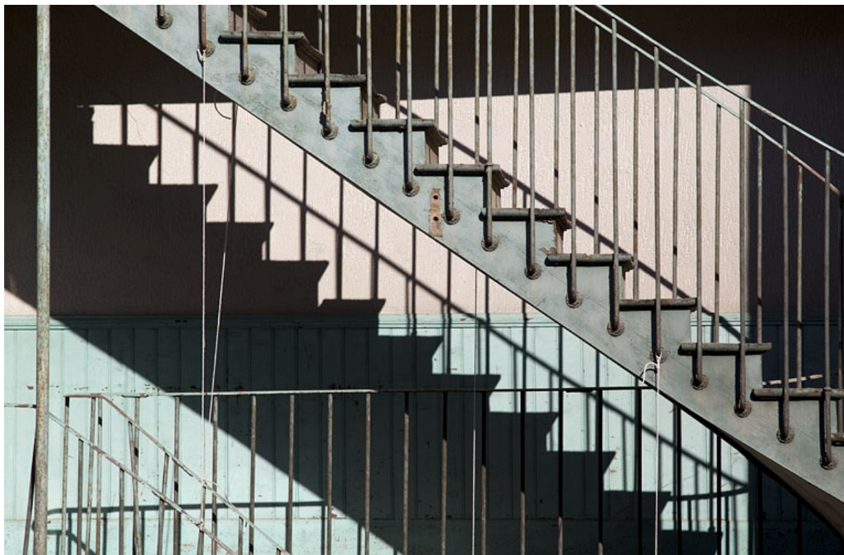
Détail de la rampe de l'escalier à cage ouverte depuis une maison voisine.
