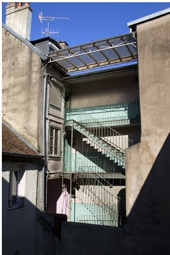
Vue d'ensemble de l'escalier à cage ouverte depuis une maison voisine.
