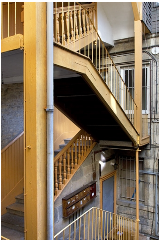
Vue de l'escalier à cage ouverte depuis la deuxième volée.
