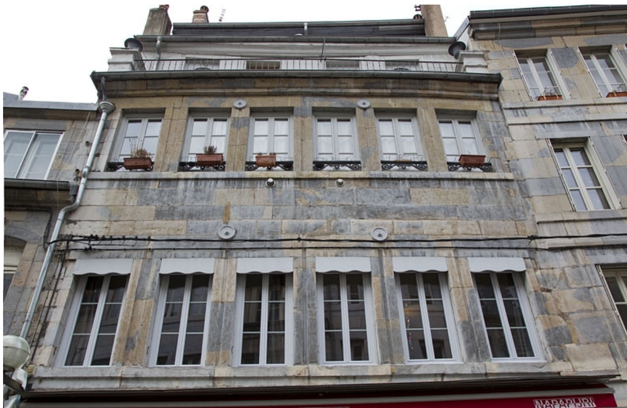
Logis principal, façade antérieure : détail de la partie supérieure à partir du premier étage.
