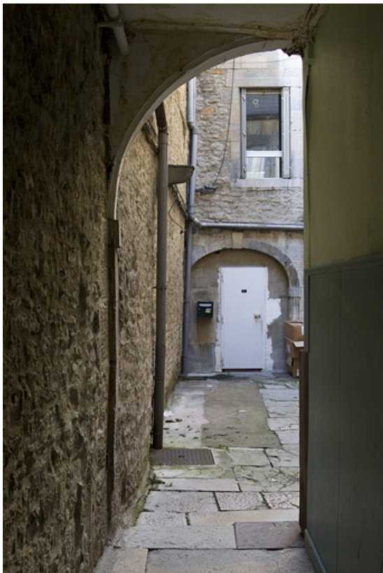
Logis secondaire : détail du porte cochère depuis le couloir du logis principal. 25, Besançon, 5 rue Bersot, lieudit : îlot Proudhon
