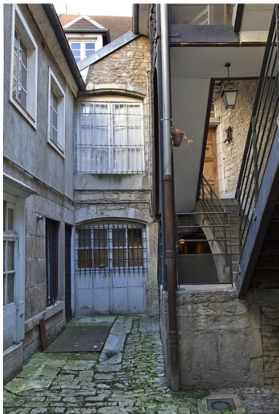
Vue d'ensemble de la façade postérieure du logis principal et de l'aile, depuis le fond de la cour. 25, Besançon, 3 rue Bersot, lieudit : îlot Proudhon
