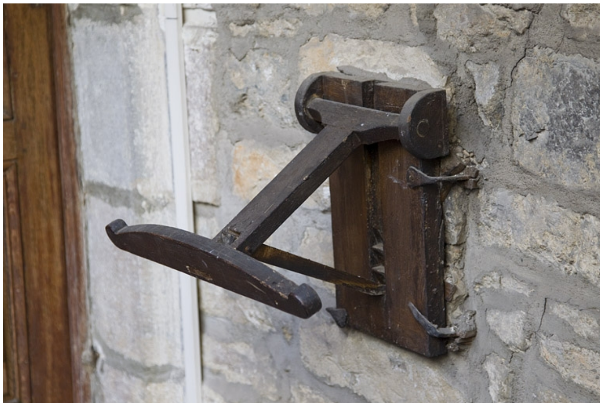
Logis principal, façade sur cour : détail d'un objet en bois non identifié (lutrין ?) situé à côté de la porte d'entrée de l'appartement du premier étage.
