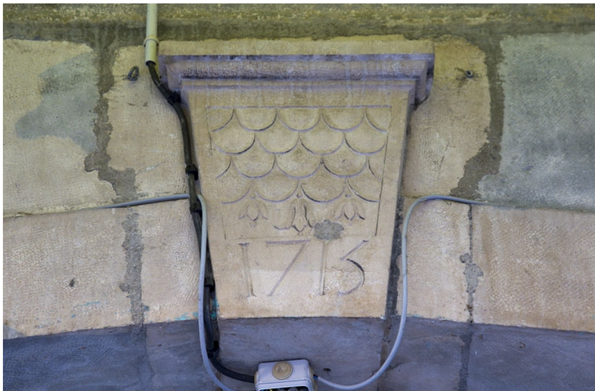
Façade sur rue : détail de la clé de l'arcade boutique.
