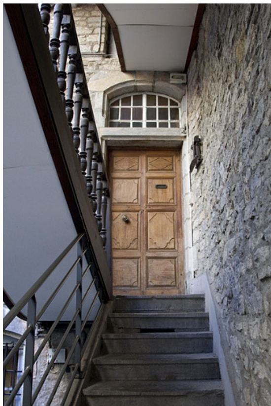
Logis principal, façade sur cour : détail de la porte d'entrée de l'appartement du premier étage depuis l'escalier à cage ouverte. 25, Besançon, 3 rue Bersot, lieudit : îlot Proudhon
