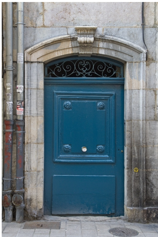
Façade sur rue : détail de la porte du couloir. 25, Besançon, 3 rue Bersot, lieudit : îlot Proudhon
