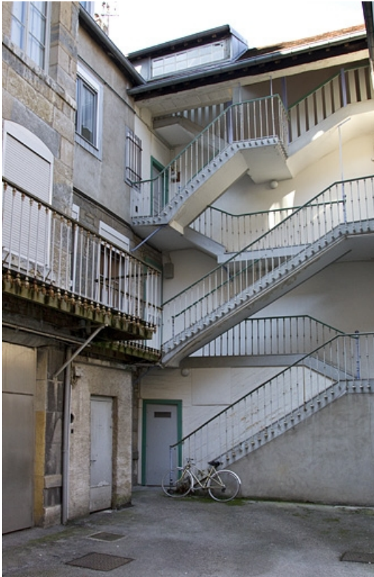
Vue de l'escalier à cage ouverte dans la deuxième cour.
