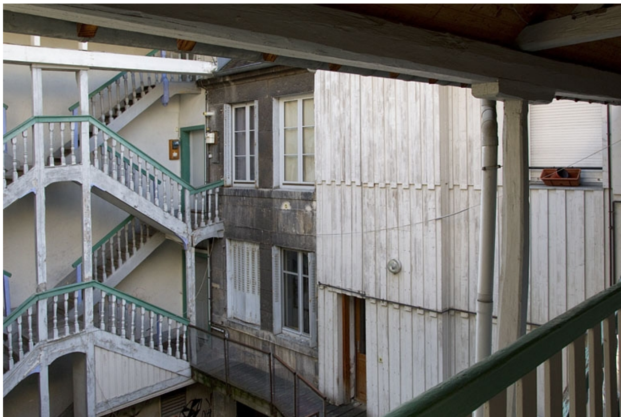
Logis principal : façade postérieure depuis l'escalier à cage ouverte, avec vue sur l'escalier du n° 75 rue des Granges. 25, Besançon, 73 rue des Granges, lieudit : îlot Proudhon
