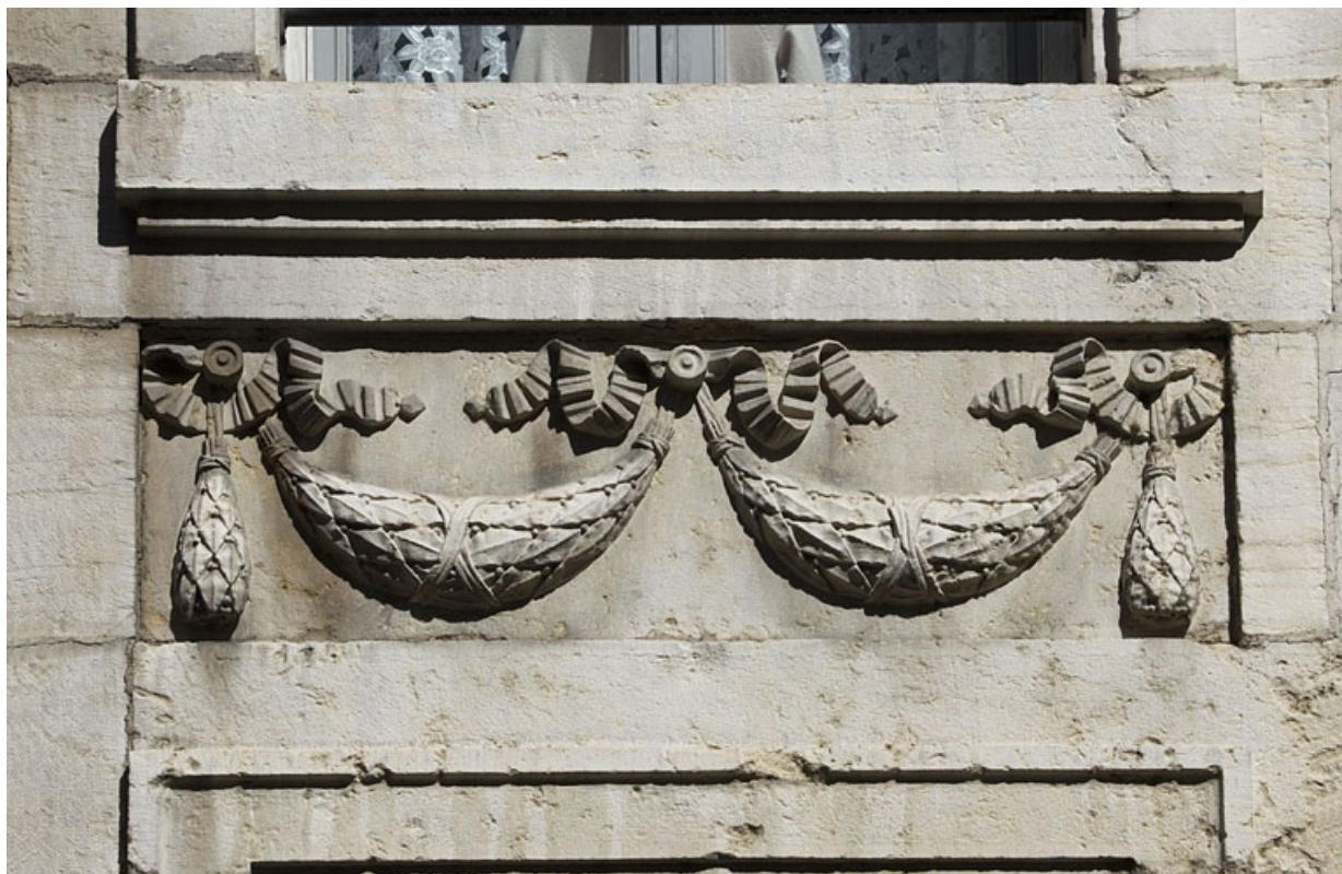
Logis principal, façade antérieure, détail du décor d'une table rentrante : festons.
