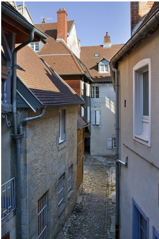
Vue d'ensemble des corps de bâtiment depuis l'entrée de la première cour.
