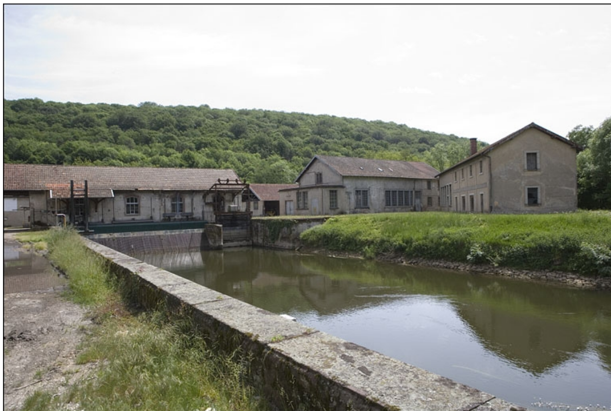
Bâtiment d'eau, ateliers de réparation et de maintenance depuis la chaufferie. 25, Boussières rue Ernest Zuber
