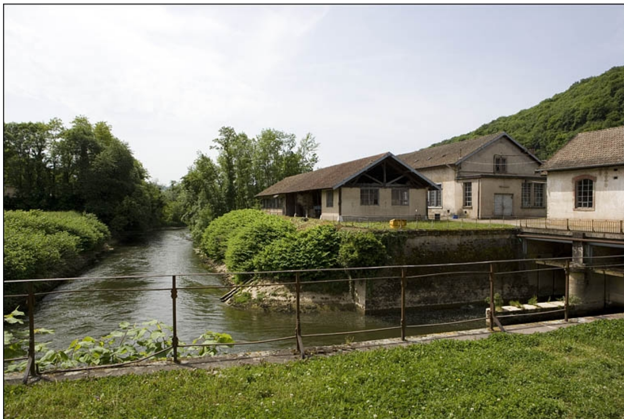
Bief de dérivation et hangar industriel.
