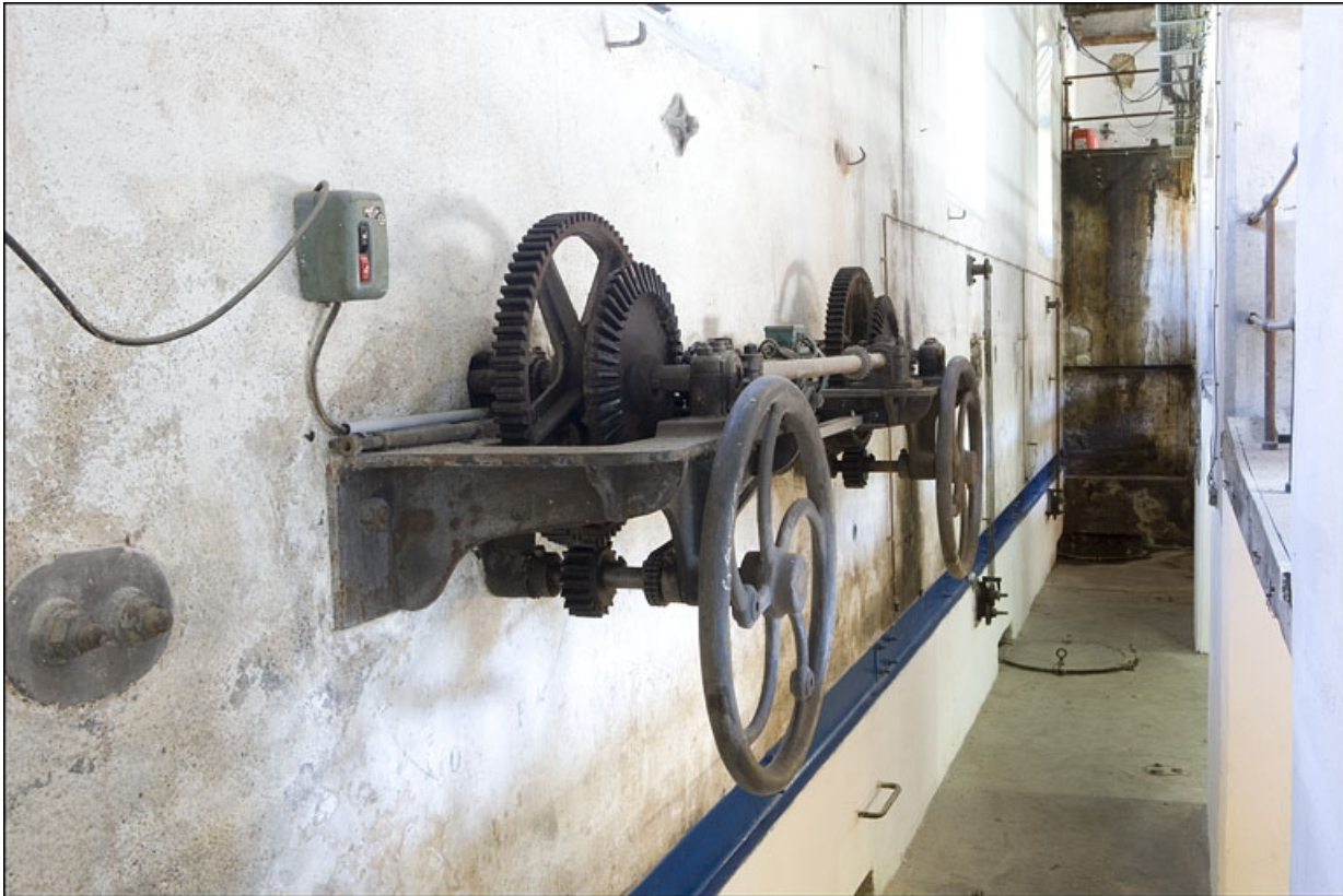
Bâtiment d'eau. Vannes du batardeau.
