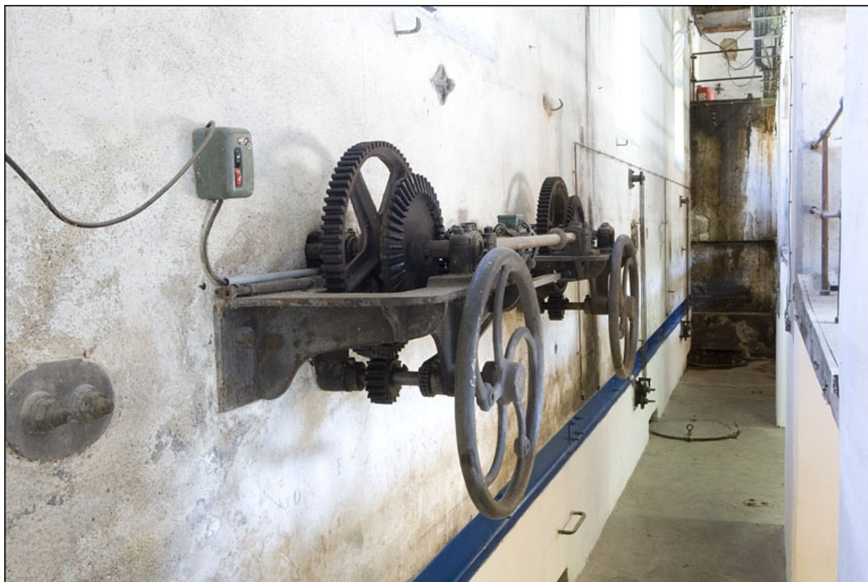
Bâtiment d'eau. Vannes du batardeau. 25, Boussières rue Ernest Zuber
