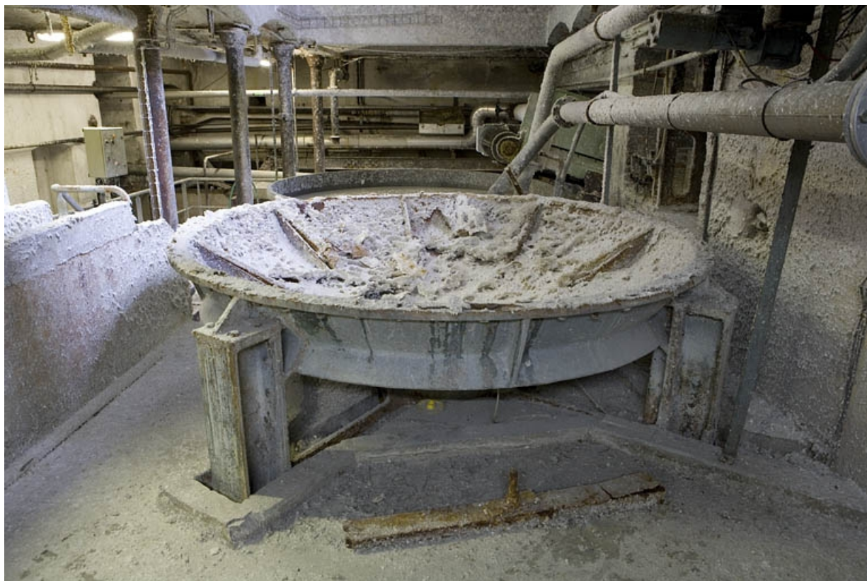
Atelier de trituration (premier étage). Vestige de la base d'un pulpeur. 25, Boussières rue Ernest Zuber
