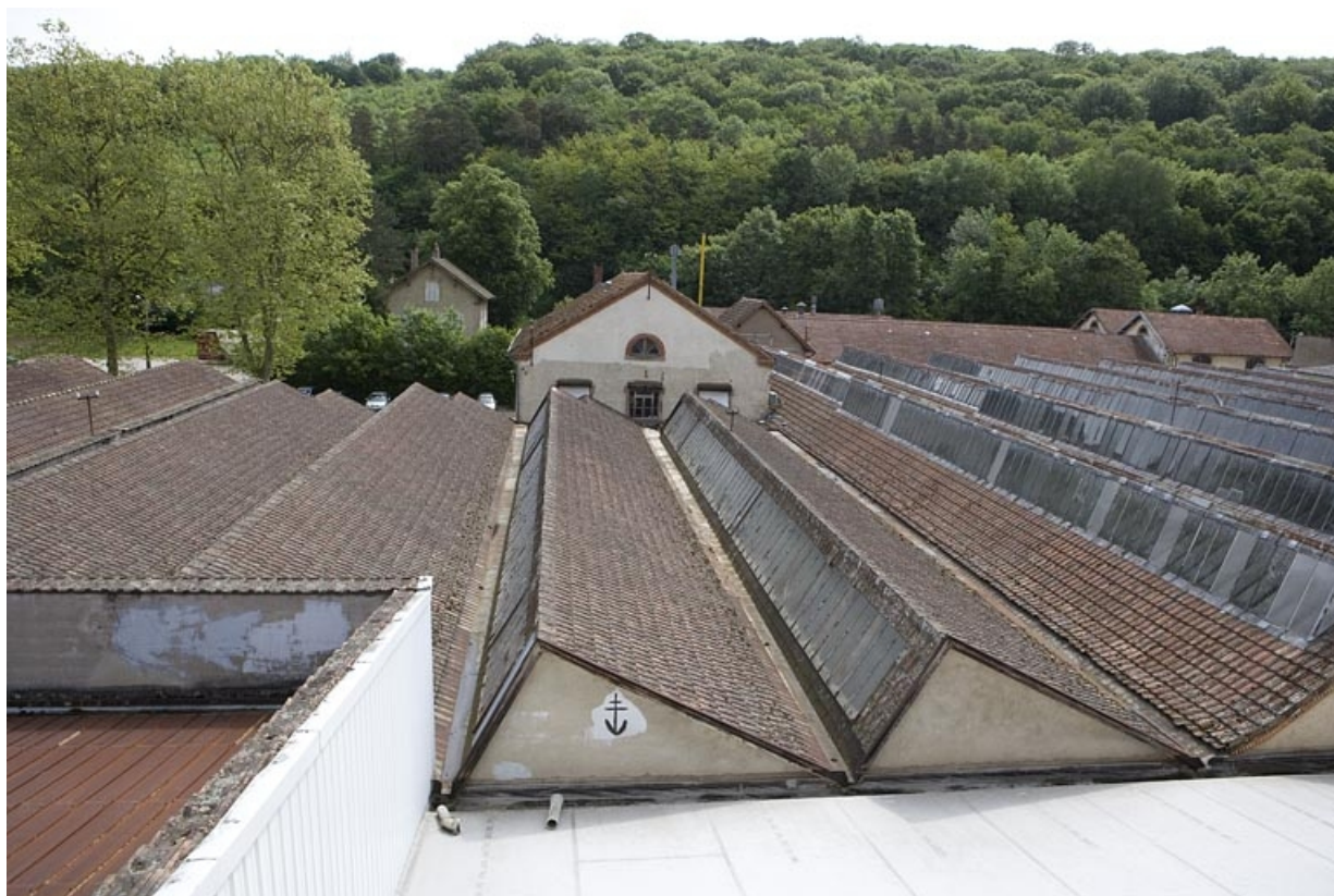
Magasin industriel. Vue de face d'un shed. 25, Boussières rue Ernest Zuber
