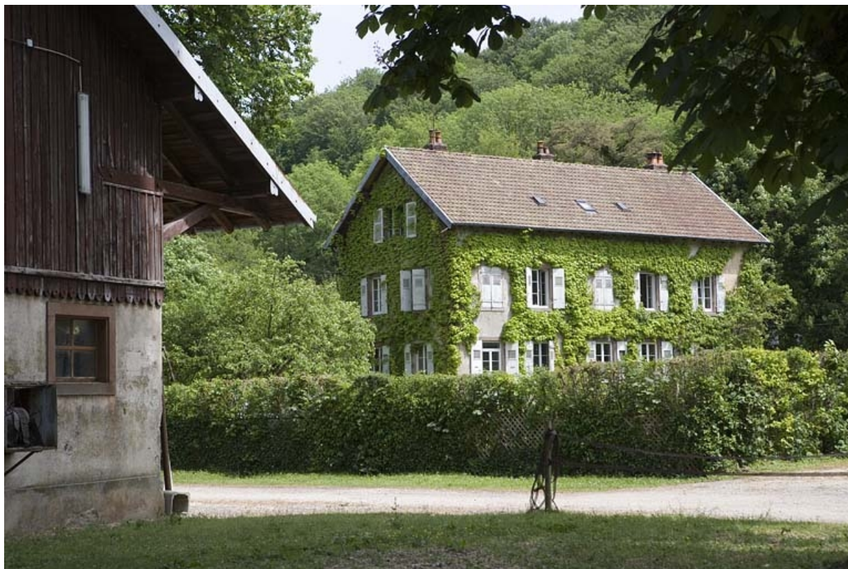
Maison de direction. Façade antérieure.
