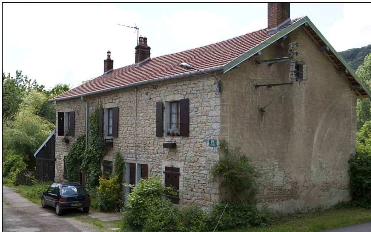
Logement d'ouvriers, 2 rue de la Coop (commune de Torpes).
