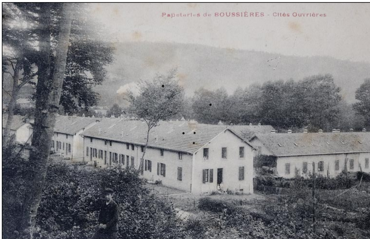
Papeterie de Boussières. Cités ouvrières. 25, Boussières rue Ernest Zuber
