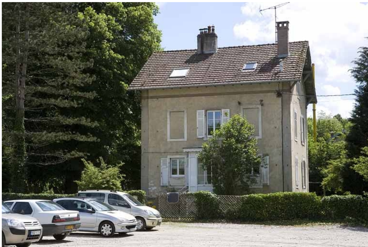
Conciergerie de la papeterie. Façade antérieure. 25, Boussières rue Ernest Zuber
