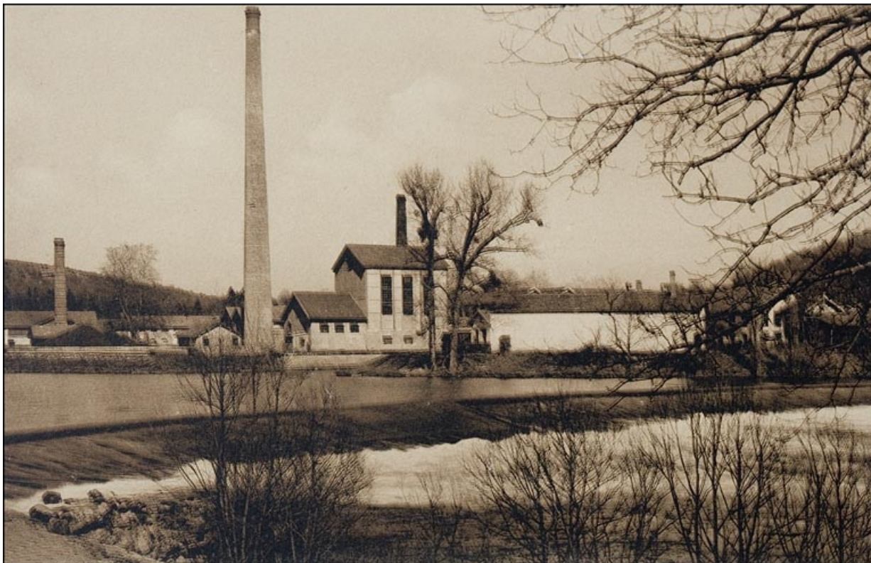
La papeterie, depuis le barrage. 25, Boussières rue Ernest Zuber
