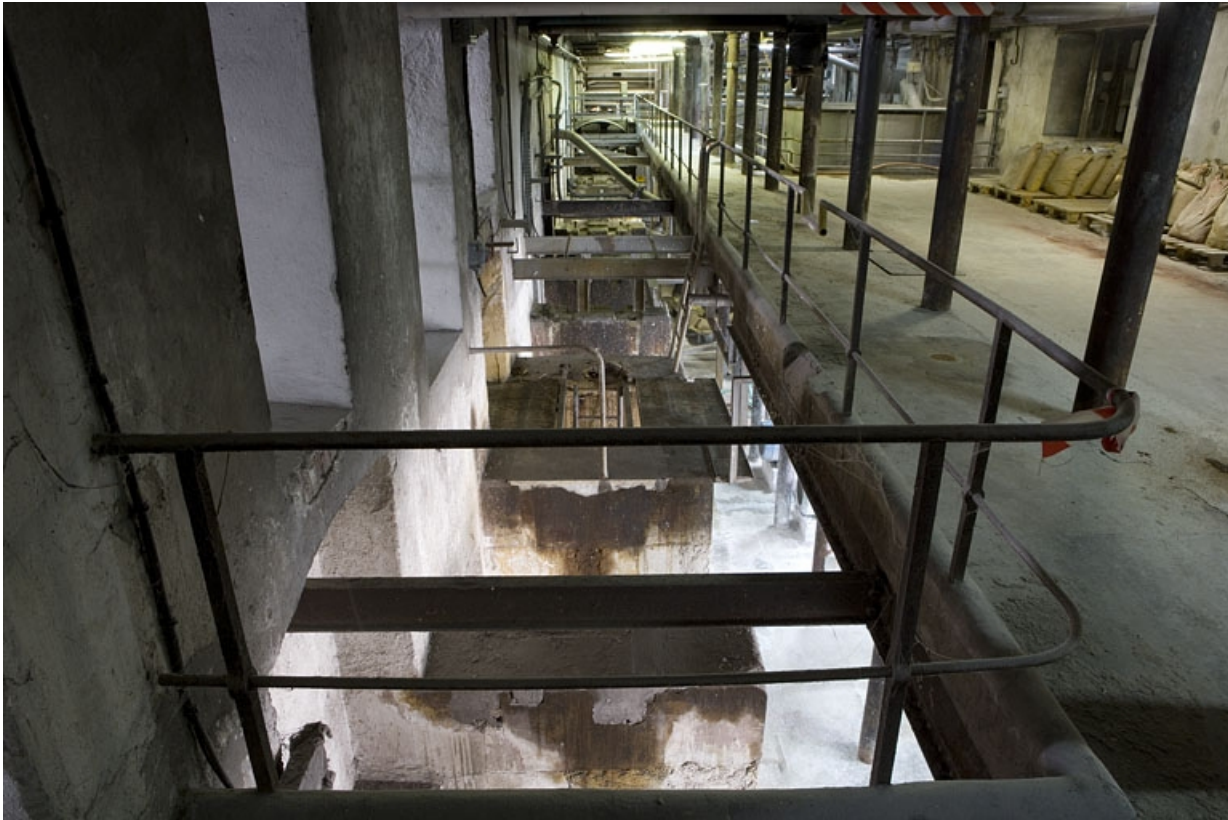
Atelier de fabrication (premier étage). Trémie pour passage de la transmission horizontale vers les pulpeurs. 25, Boussières rue Ernest Zuber
