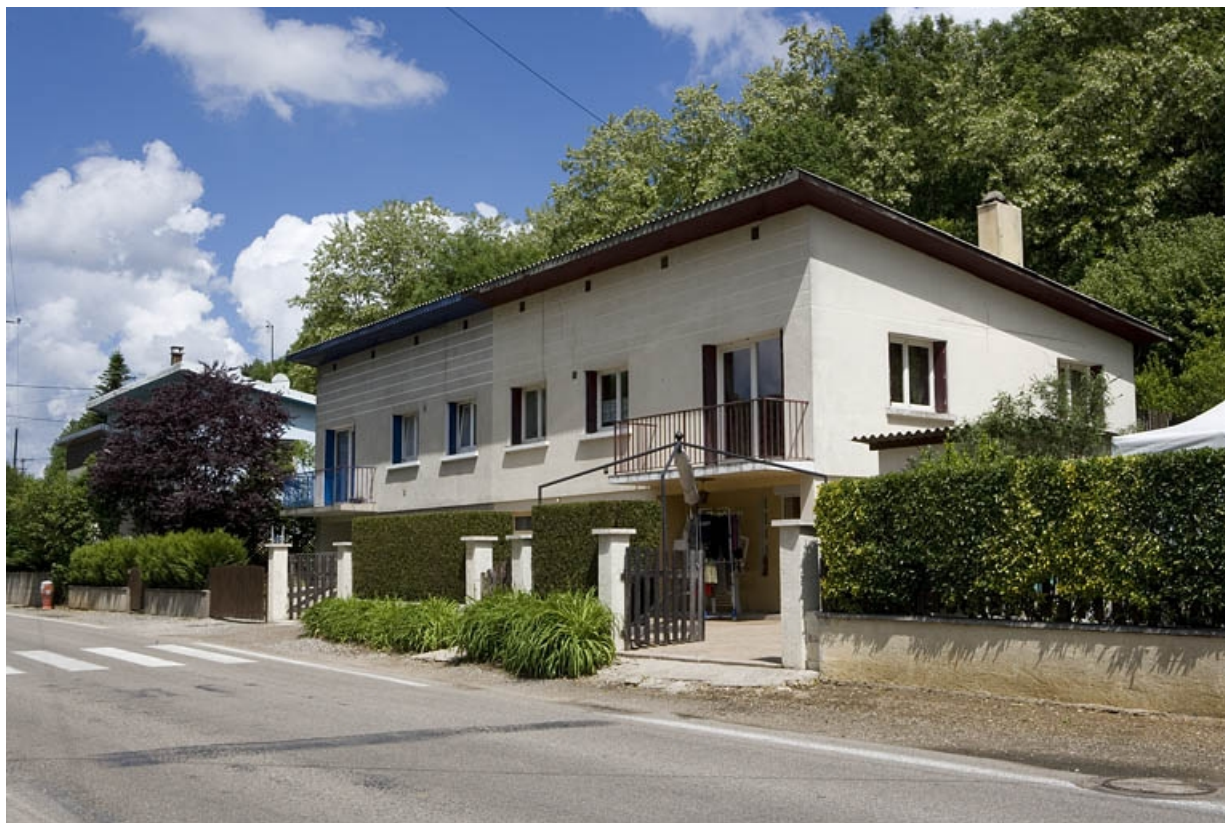
Cité ouvrière du Maroc. Vue de trois quarts d'une maison.
