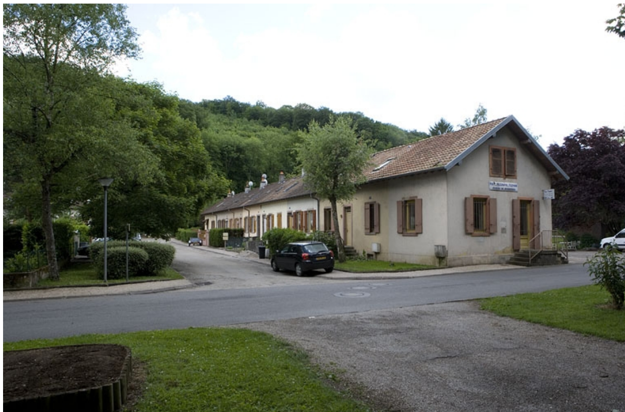
Cité ouvrière. Façade d'un logement collectif rue de la Poste.
