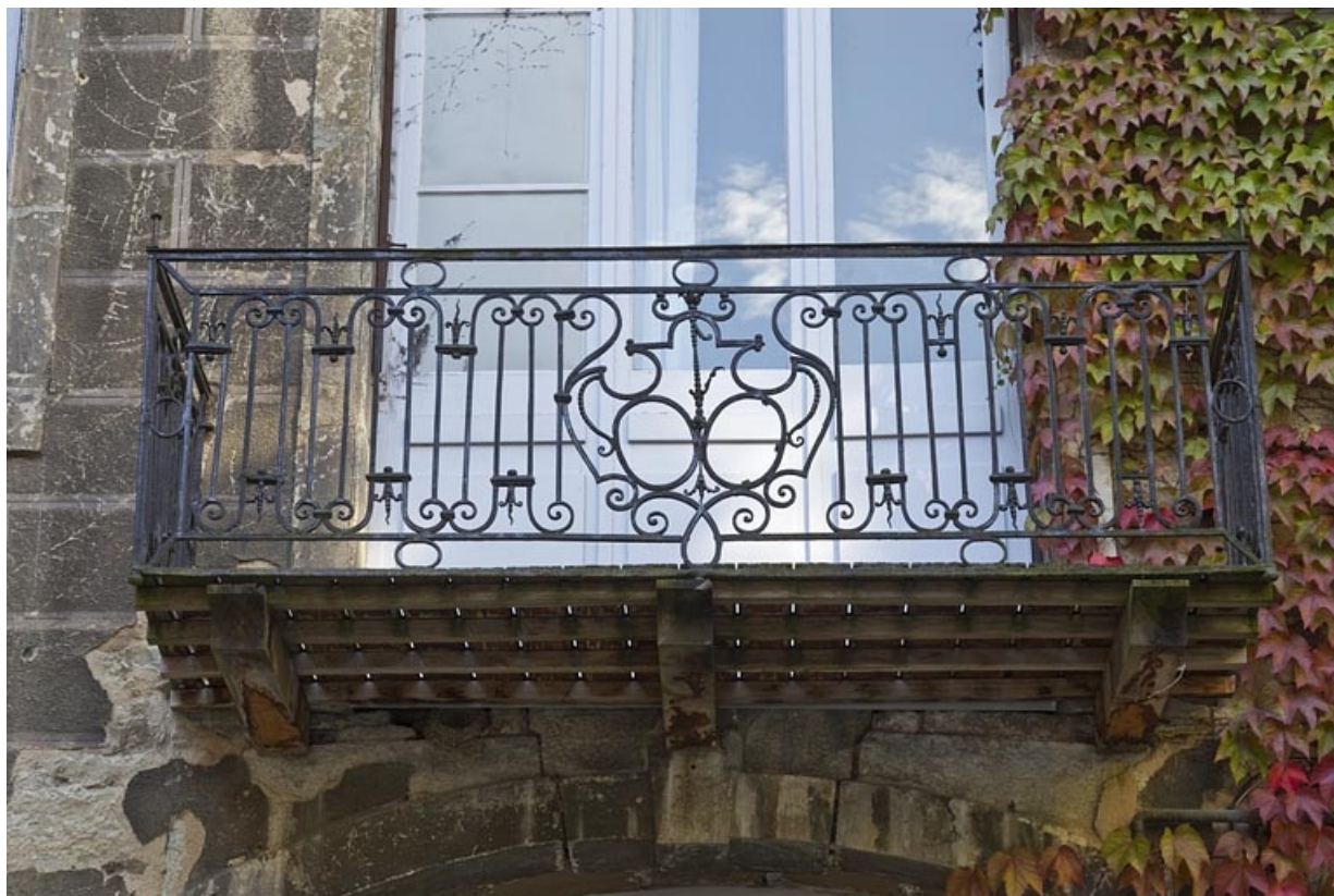
Logis secondaire, façade postérieure : détail du balcon en ferronnerie.
