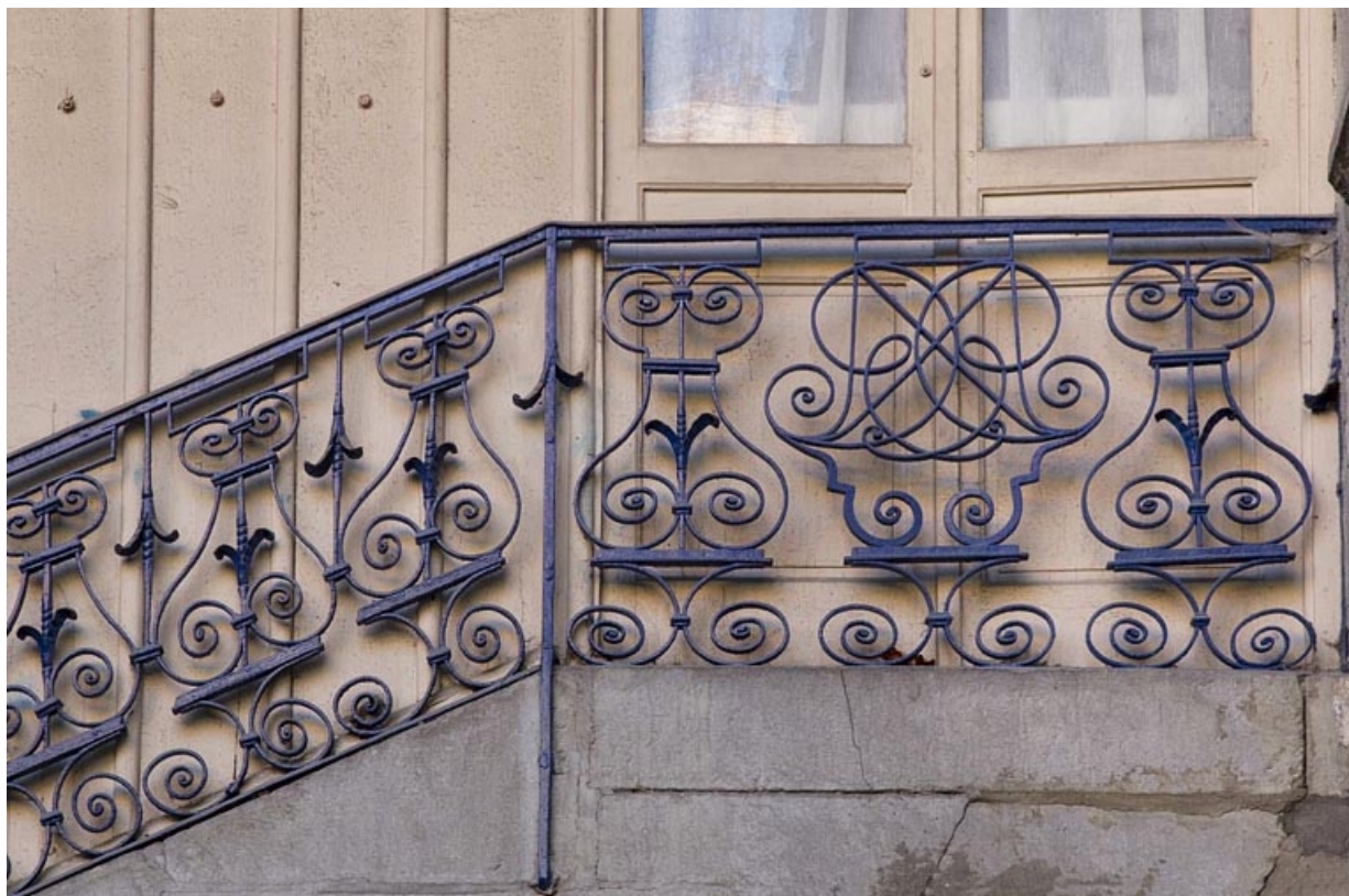
Aile droite, premier escalier à cage ouverte : détail rapproché de la rampe en fer forgé.
