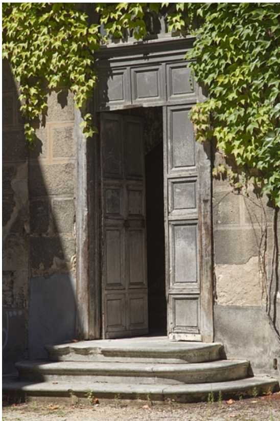
Logis secondaire, aile gauche dans la deuxième cour : détail d'une porte d'entrée.
