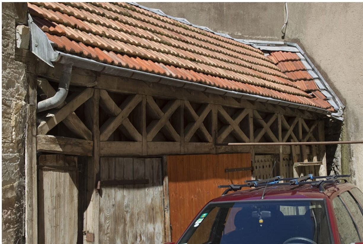
Deuxième cour, bûcher : vue rapprochée, de trois quarts gauche.
