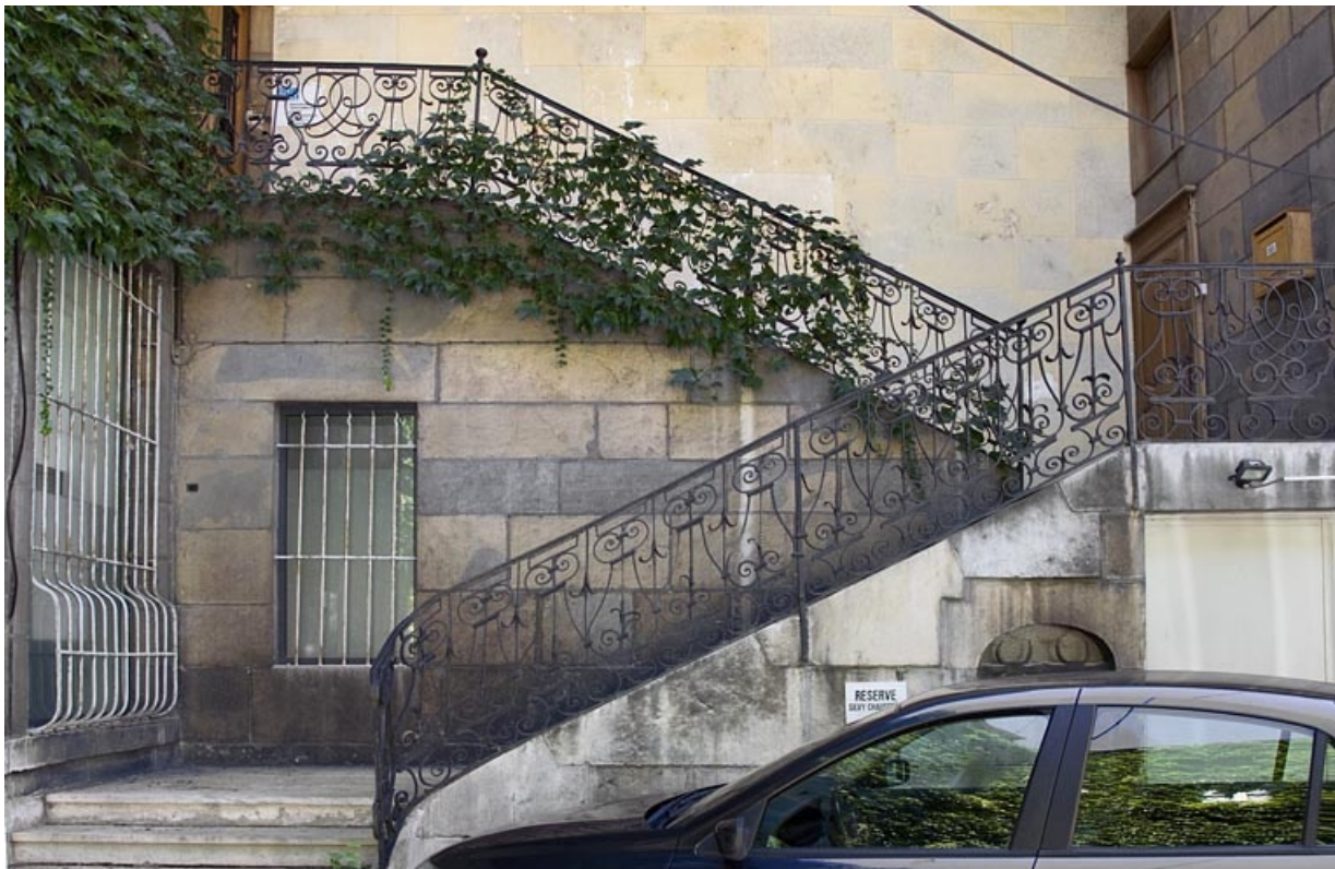
Aile droite, deuxième escalier à cage ouverte : vue d'ensemble de face. 25, Besançon, 23 rue des Granges, lieudit : îlot Poste
