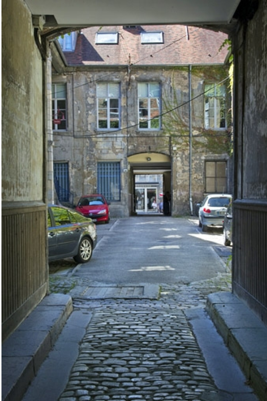
Logis principal : façade postérieure, depuis le passage cocher du premier logis secondaire. 25, Besançon, 23 rue des Granges, lieu-dit : îlot Poste
