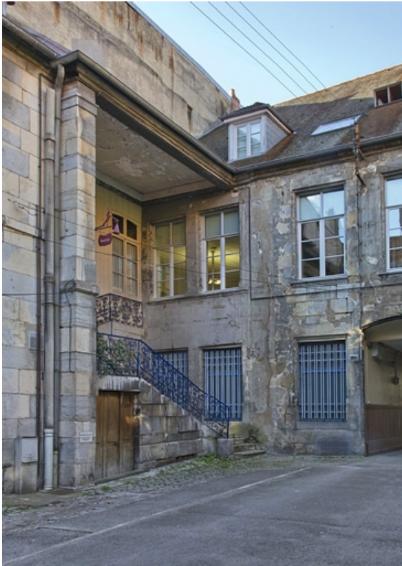
Première cour, aile droite : vue d'ensemble du premier escalier à cage ouverte, de trois quarts gauche. 25, Besançon, 23 rue des Granges, lieu dit : îlot Poste
