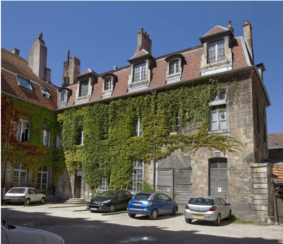
Logis secondaire, aile gauche dans la deuxième cour : vue d'ensemble, de trois quarts droit. 25, Besançon, 23 rue des Granges, lieudit : îlot Poste
