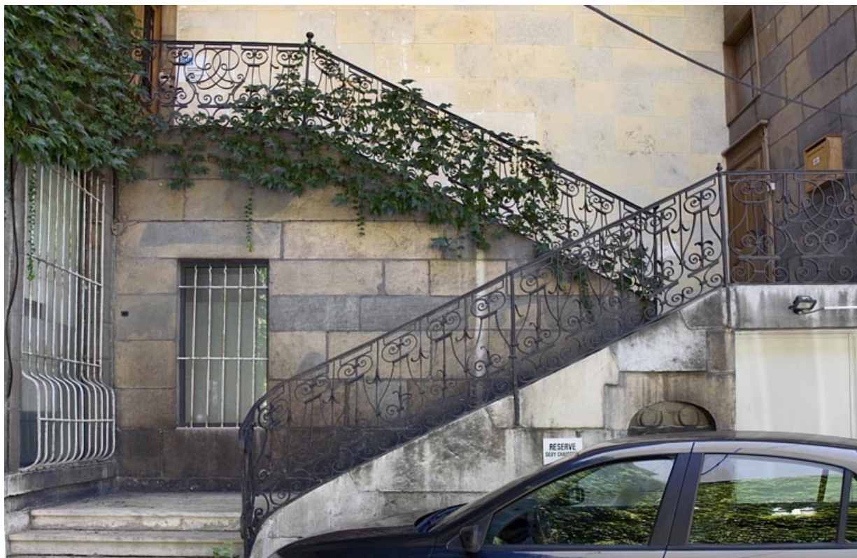
Aile droite, deuxième escalier à cage ouverte : vue d'ensemble de face.
