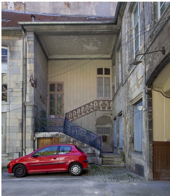
Première cour, aile droite : vue d'ensemble du premier escalier à cage ouverte, de face. 25, Besançon, 23 rue des Granges, lieudit : îlot Poste
