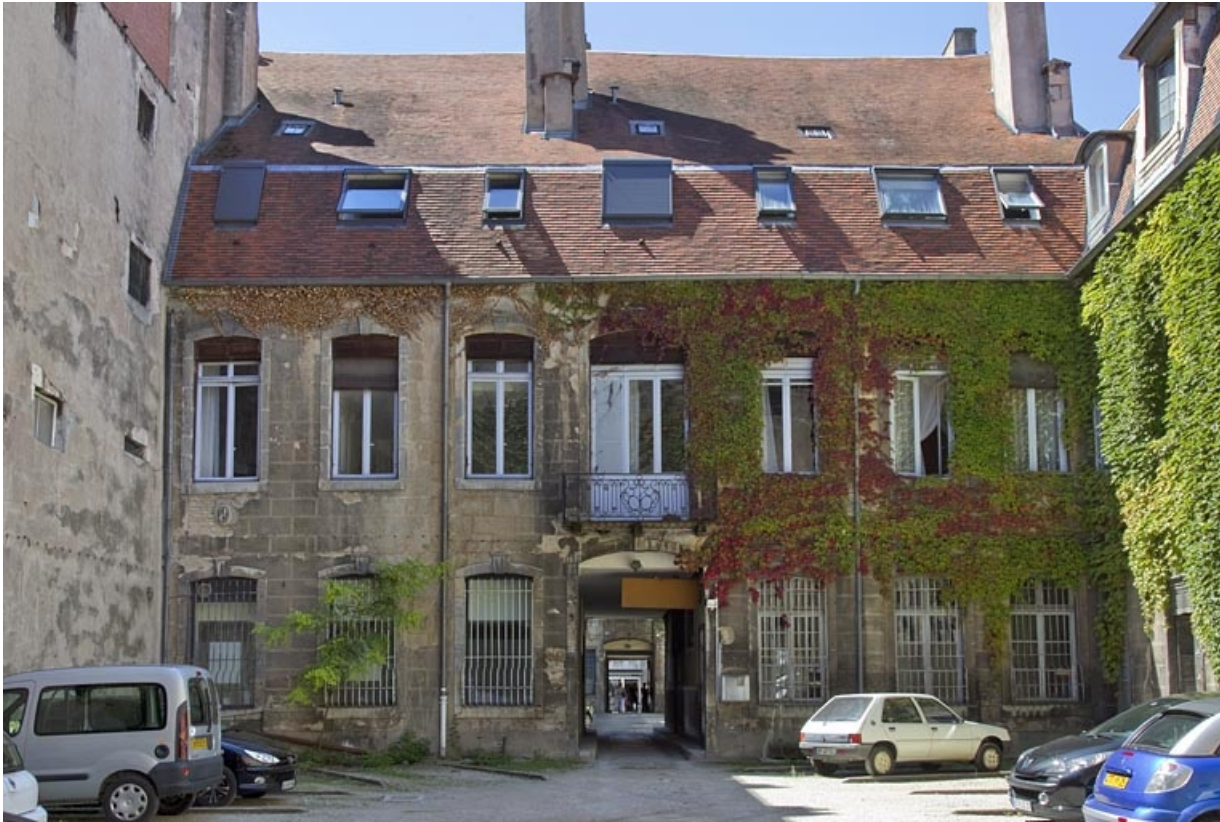
Logis secondaire : vue d'ensemble de la façade postérieure, de face. 25, Besançon, 23 rue des Granges, lieudit : îlot Poste
