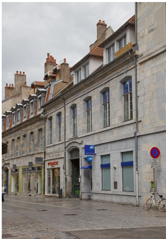
Vue d'ensemble depuis la rue : de trois quarts droit. 25, Besançon, 23 rue des Granges, lieudit : îlot Poste
