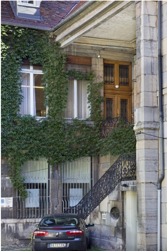
Aile droite, deuxième escalier à cage ouverte : vue d'ensemble de trois quarts droit. 25, Besançon, 23 rue des Granges, lieudit : îlot Poste
