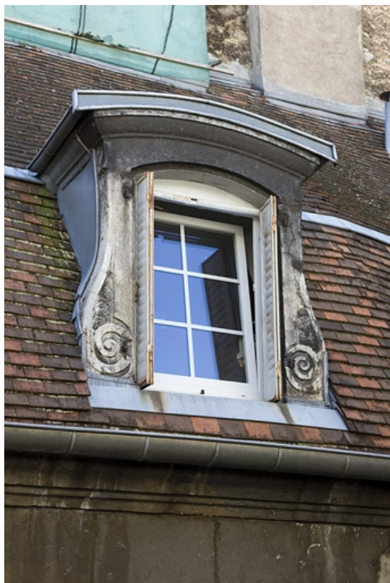
Première cour, logis principal : détail d'une lucarne, aile à droite de la cour. 25, Besançon, 17 rue des Granges, lieudit : îlot Poste
