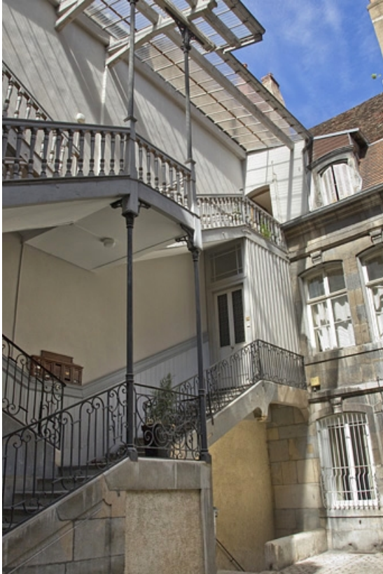
Vue d'ensemble de l'escalier à cage ouverte : de trois quarts gauche.
