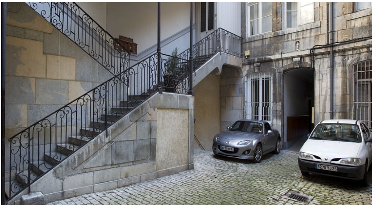
Vue d'ensemble des premières volées de l'escalier à cage ouverte sur cour : de trois quarts droit.
