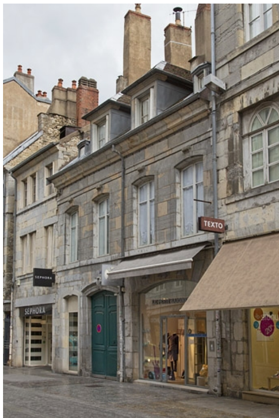
Vue d'ensemble depuis la rue : de trois quarts droit. 25, Besançon, 17 rue des Granges, lieudit : îlot Poste
