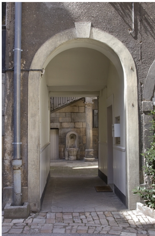
Aile des remises : détail de la porte de communication avec la parcelle voisine.
