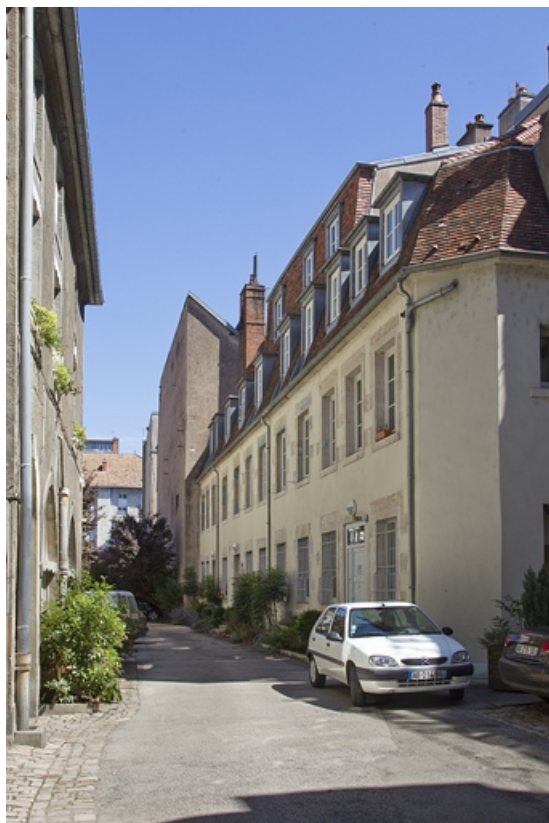
Deuxième logis secondaire : de trois quarts droit. 25, Besançon, 21 rue des Granges, lieudit : îlot Poste
