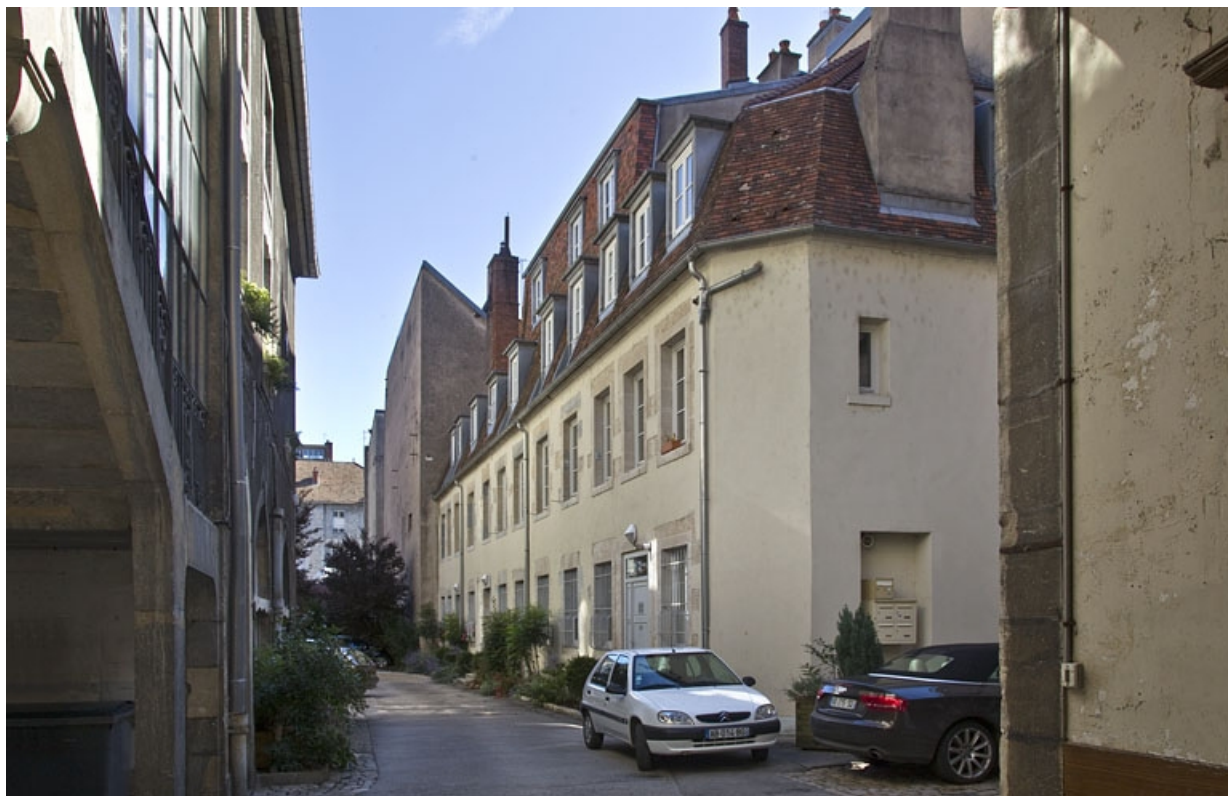
Deuxième logis secondaire : de trois quarts droit, vue rapprochée.
