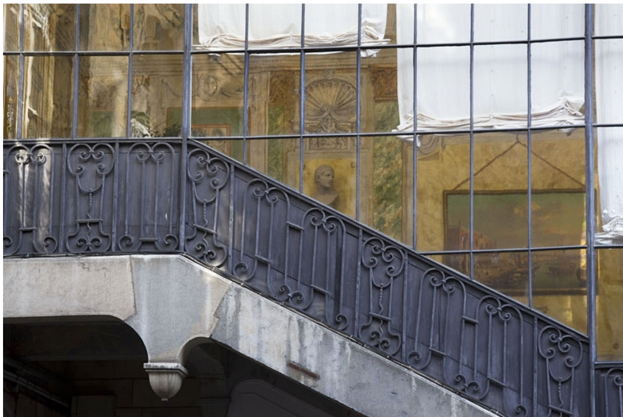
Escalier à cage ouverte : détail de la rampe en fer forgé : de face.
