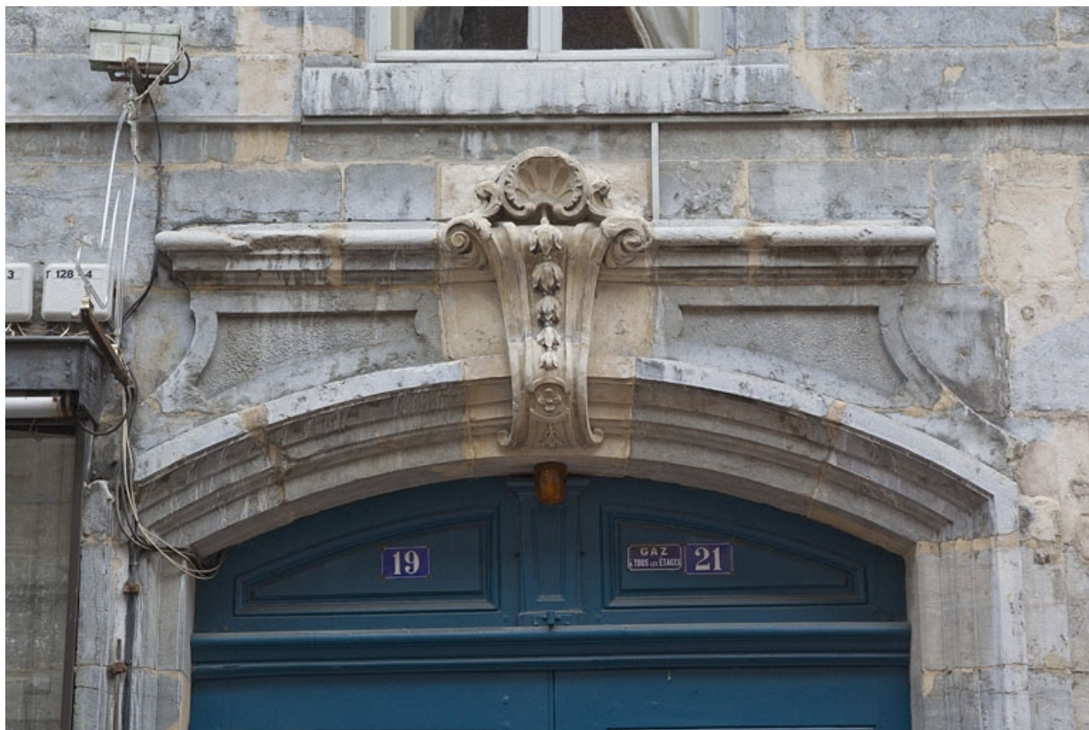
Logis principal, façade antérieure : détail de l'arc couvrant le portail d'entrée. 25, Besançon, 21 rue des Granges, lieudit : îlot Poste
