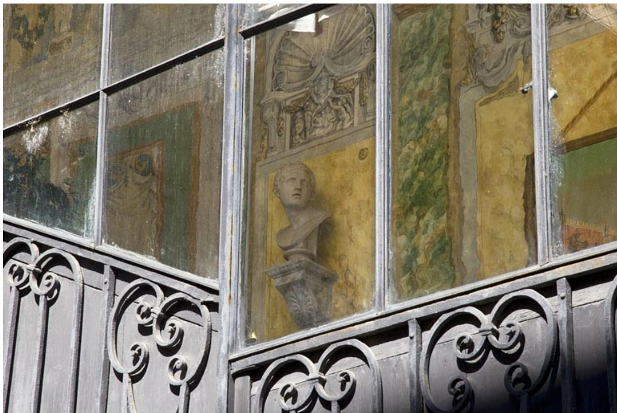
Escalier à cage ouverte : détail du décor de la cage depuis l'extérieur, de trois quarts droit. 25, Besançon, 21 rue des Granges, lieudit : îlot Poste
