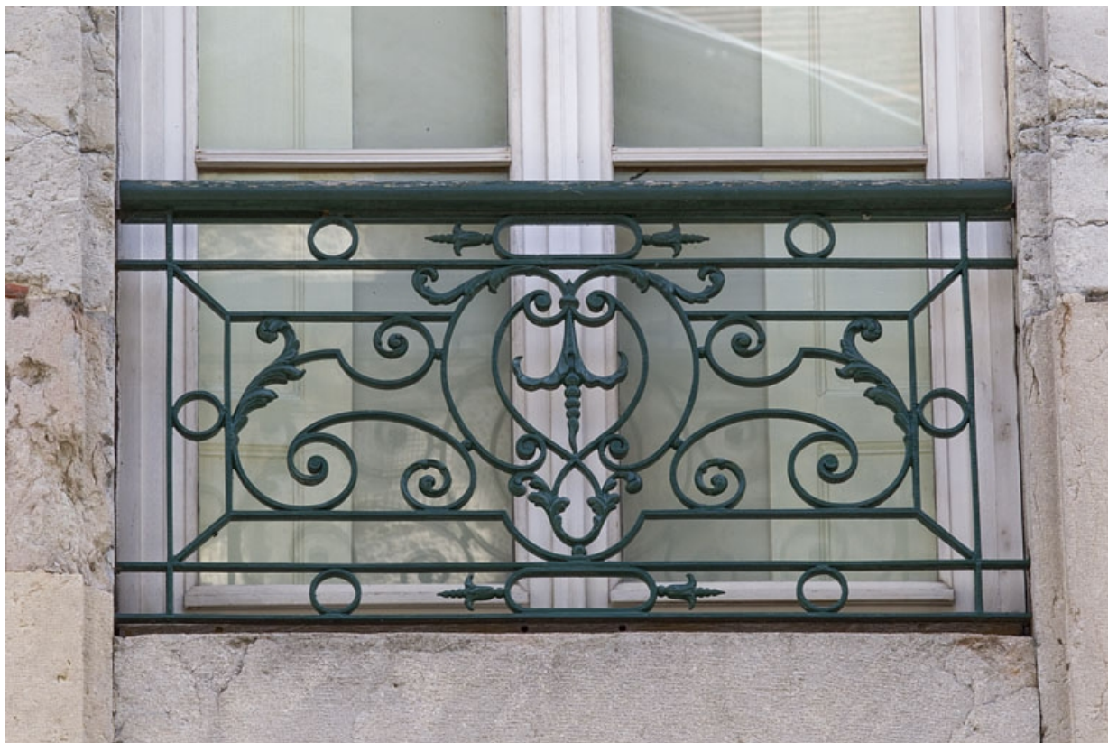
Logis principal, façade sur rue : détail d'un garde-corps en ferronnerie. 25, Besançon Grande Rue 79, lieudit : îlot Saint-Pierre
