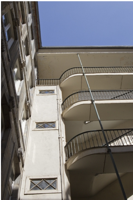
Escalier à cage ouverte de la première cour : détail de la travée à son extrémité gauche.
