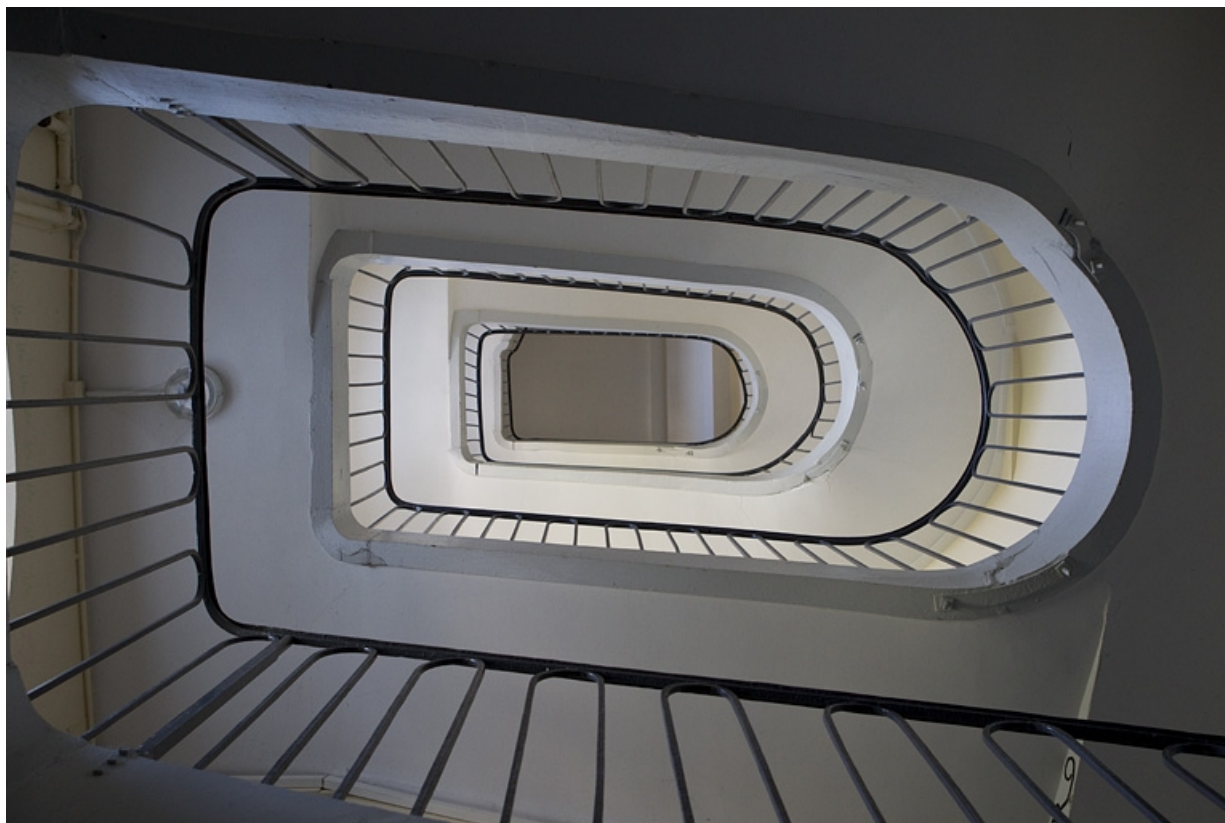
Deuxième cour, à droite : détail de l'escalier du deuxième logis secondaire.
