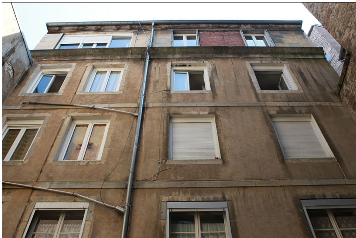
Deuxième cour : façade antérieure du deuxième logis secondaire, vue des étages.
