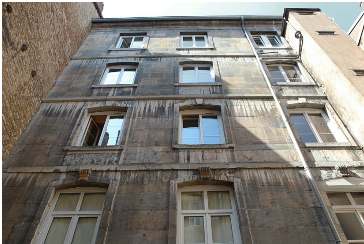
Deuxième cour : façade postérieure du premier logis secondaire, vue des étages. 25, Besançon Grande Rue 79, lieudit : îlot Saint-Pierre
