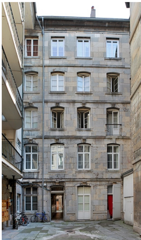
Première cour : façade antérieure du premier logis secondaire, de face. 25, Besançon Grande Rue 79, lieudit : îlot Saint-Pierre
