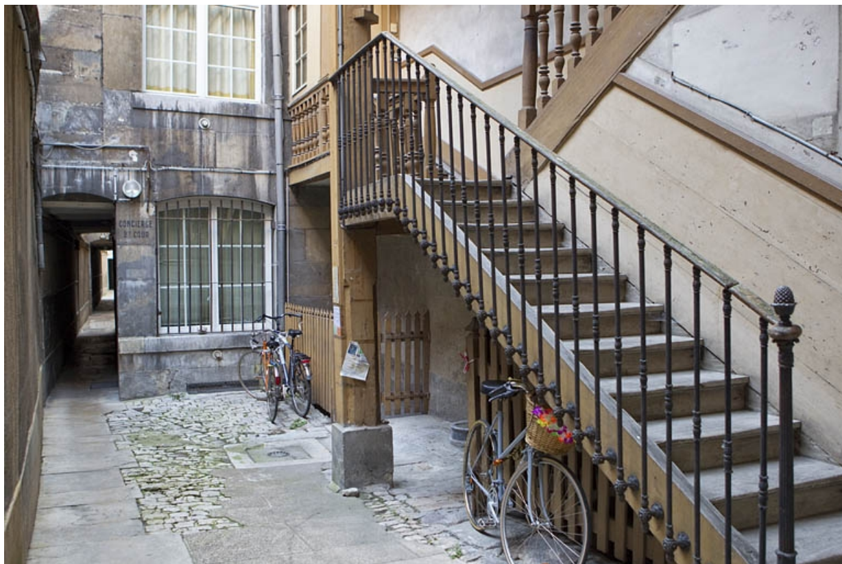
Escalier à cage ouverte de la première cour : vue de la première volée, de trois quarts droit. 25, Besançon Grande Rue 77, lieudit : îlot Saint-Pierre
