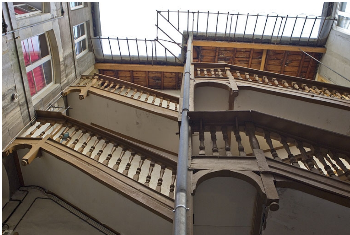
Escalier à cage ouverte de la deuxième cour : détail de la partie supérieure.
