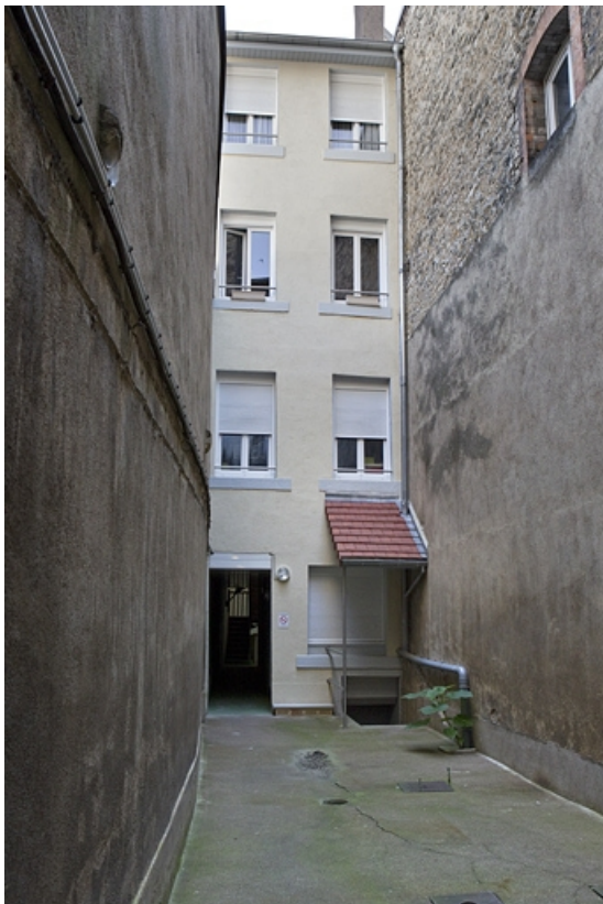
Façade antérieure du troisième logis secondaire située sur la troisième cour. 25, Besançon Grande Rue 77, lieudit : îlot Saint-Pierre
