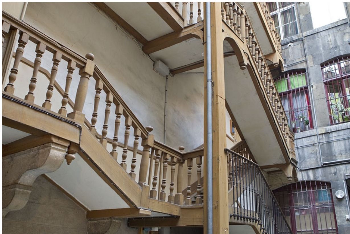
Escalier à cage ouverte de la première cour : détail de la rampe à balustres de bois.
