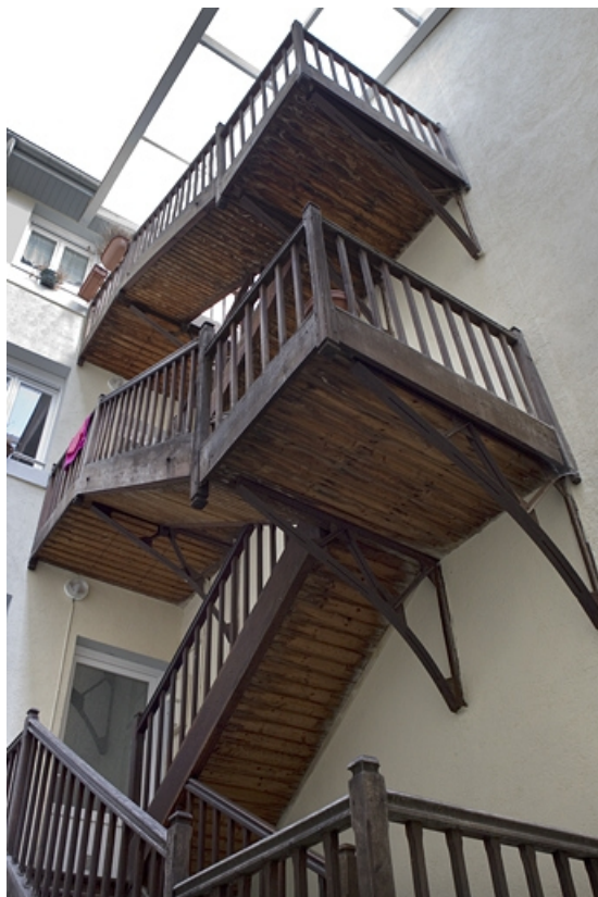
Quatrième cour : escalier extérieur du troisième logis secondaire : vue d'ensemble.
