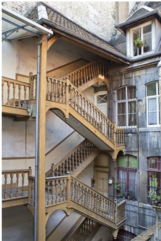
Escalier à cage ouverte de la première cour : vue d'ensemble.
