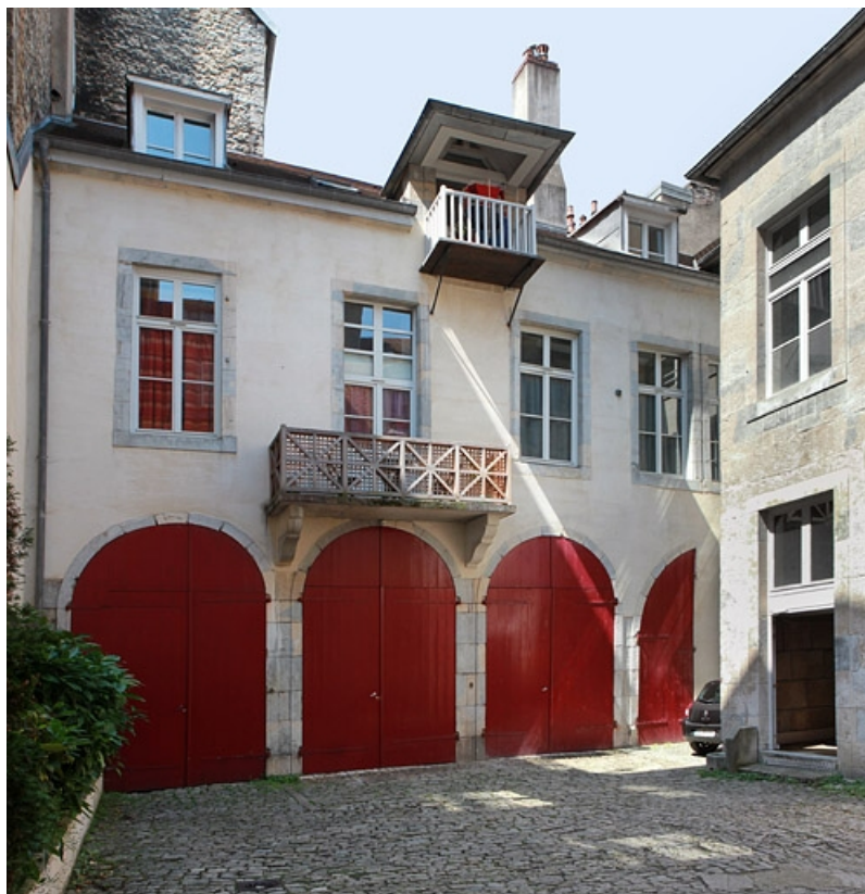
Vue d'ensemble du logis secondaire au fond de la deuxième cour, avec remises au rez-de-chaussée. 25, Besançon, 50 rue des Granges, lieudit : îlot Saint-Pierre
