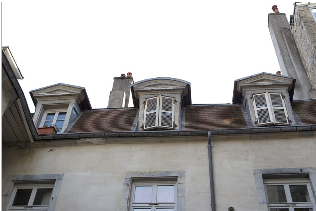
Premier logis secondaire : détail des lucarnes donnant sur la deuxième cour.
