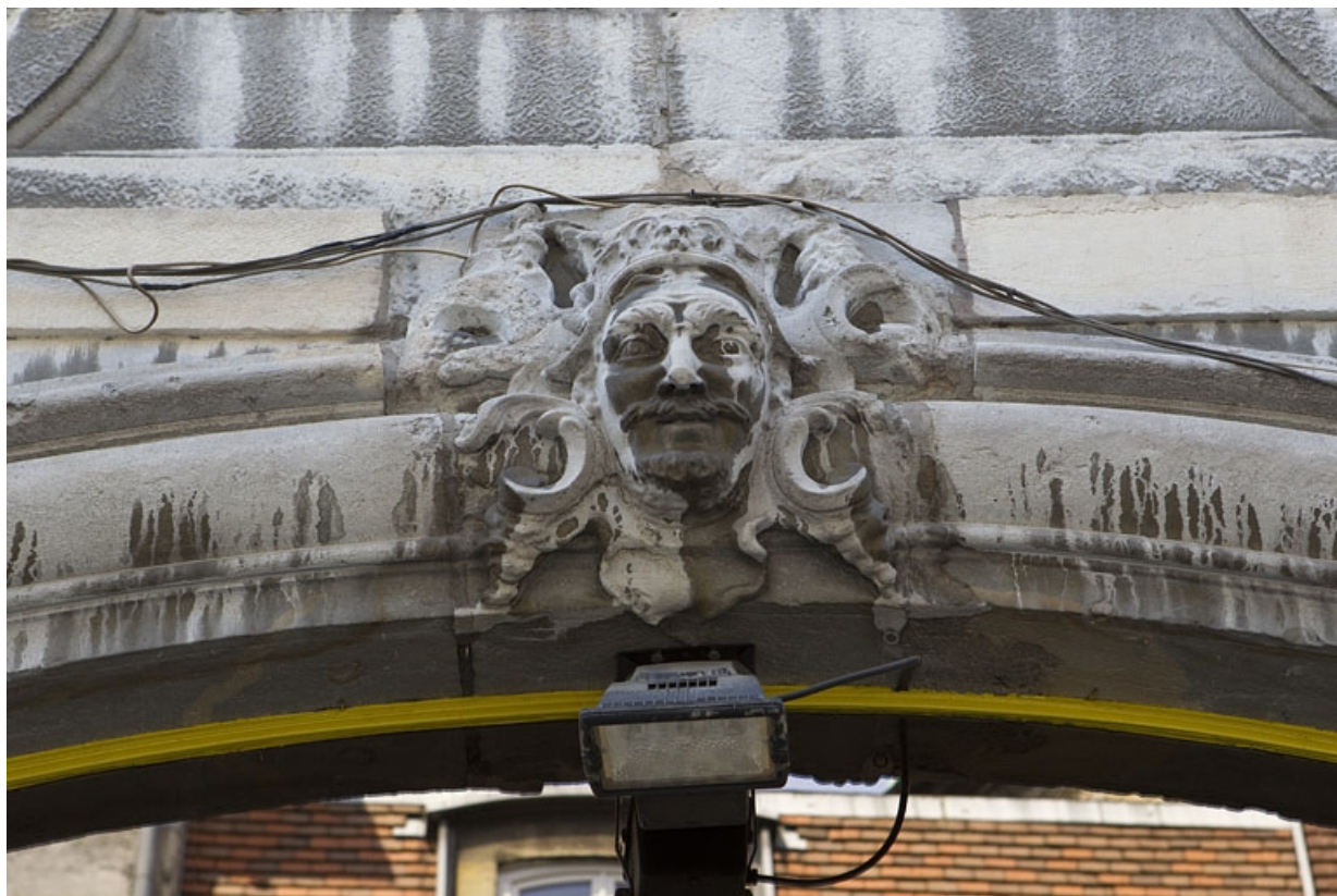
Portail d'entrée : détail du décor de la clé de l'arc.
