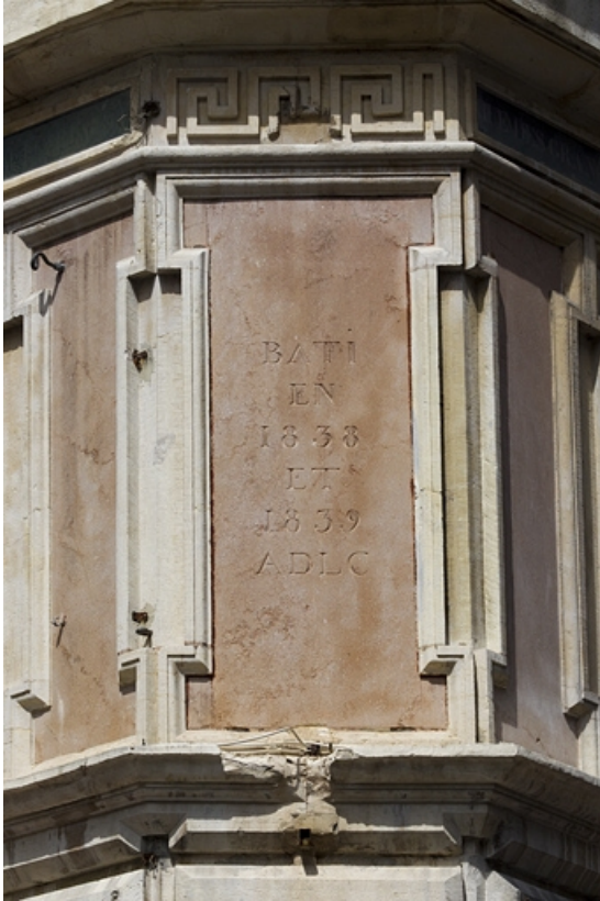
Angle du bâtiment : détail de l'inscription.
