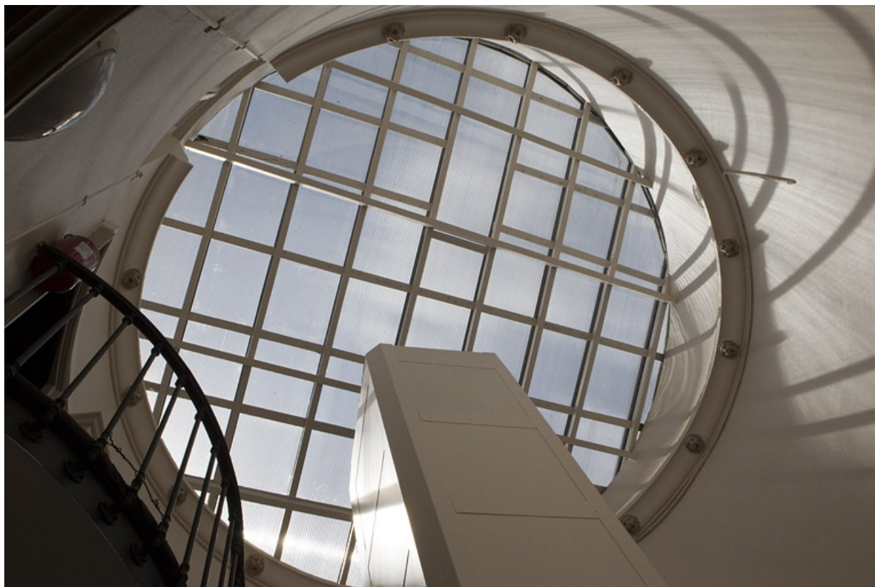
Intérieur : détail de la verrière éclairant la cage d'escalier.
