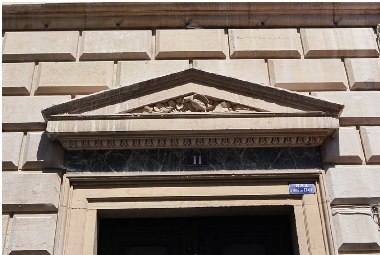
Façade antérieure : détail du fronton de la porte d'entrée.
