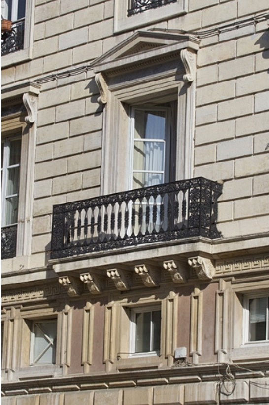
Façade latérale droite : détail du balcon.
