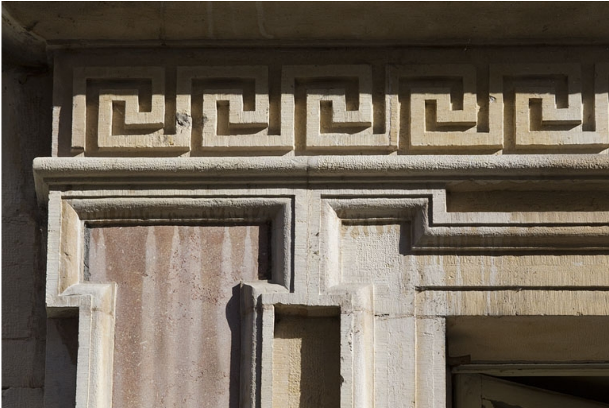
Façade antérieure : détail de la frise de grecques au-dessus de l'entresol.
