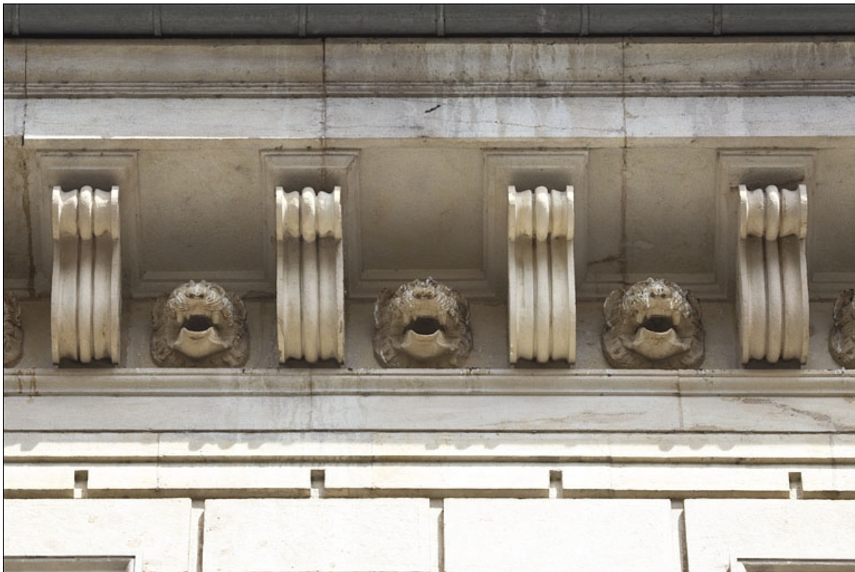
Façade antérieure : détail de la corniche de toit.
