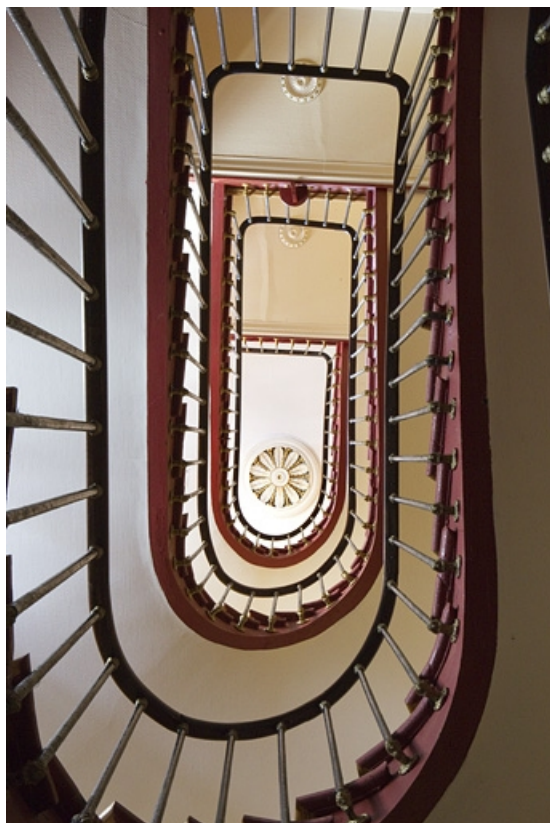
Vue d'ensemble de l'escalier depuis le rez-de-chaussée.
