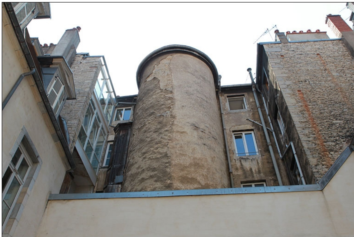
Façade postérieure : vue d'ensemble de la tour d'escalier.
