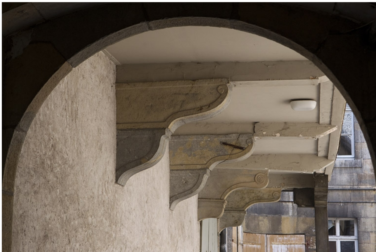
Extension en pan de bois : détail des consoles soutenant la construction.
