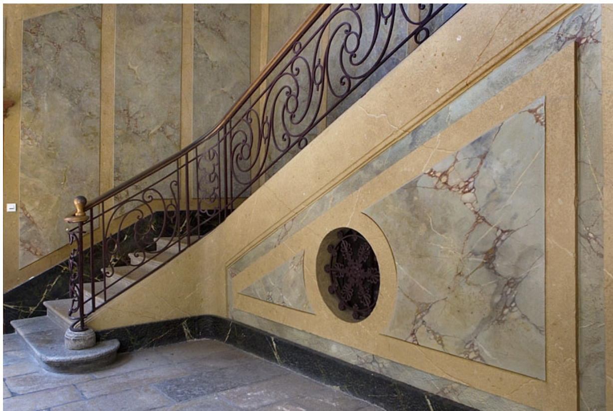
Logis principal, escalier : détail du mur d'échiffre.
