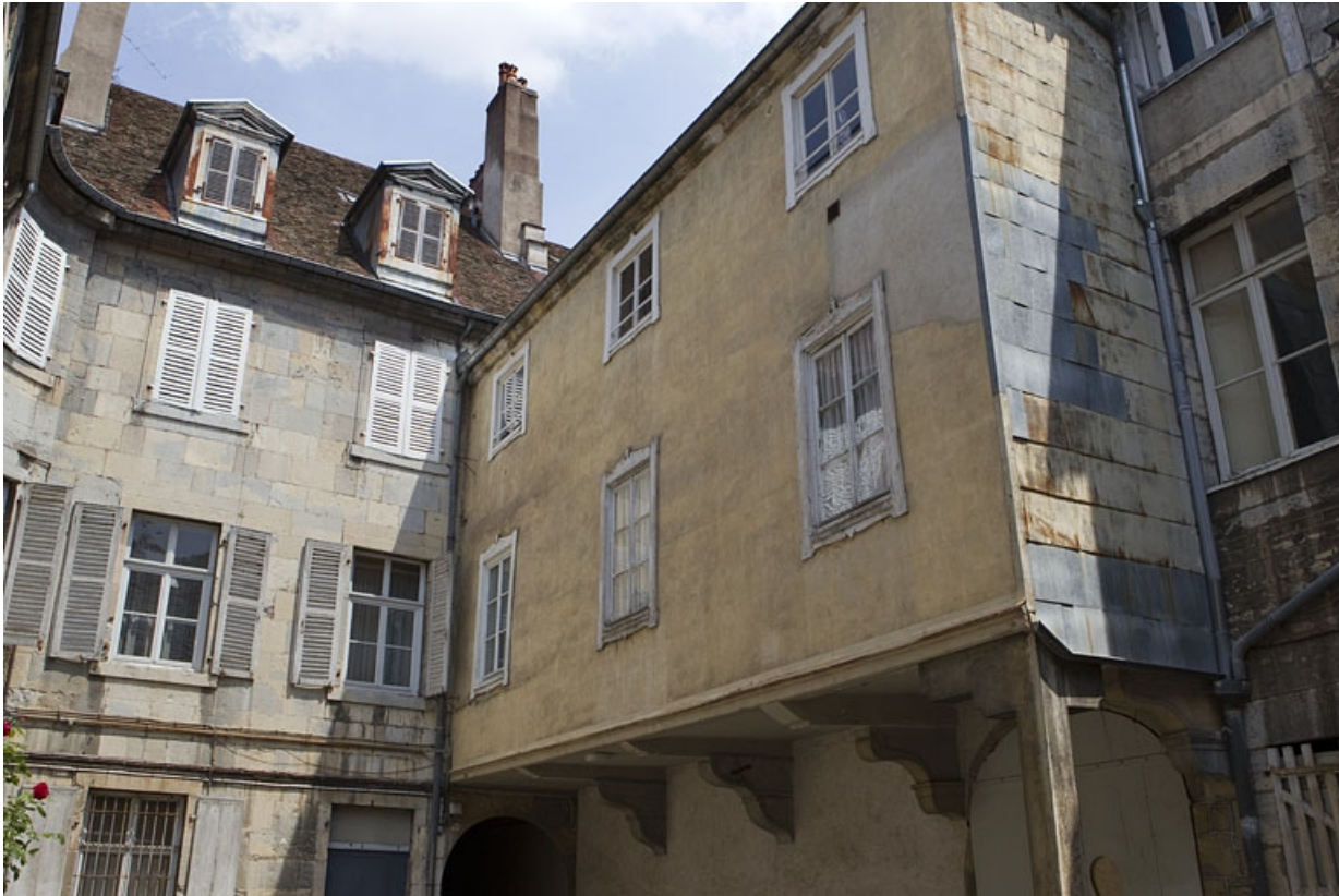
Vue d'ensemble de l'extension en pan de bois à gauche de la cour.
