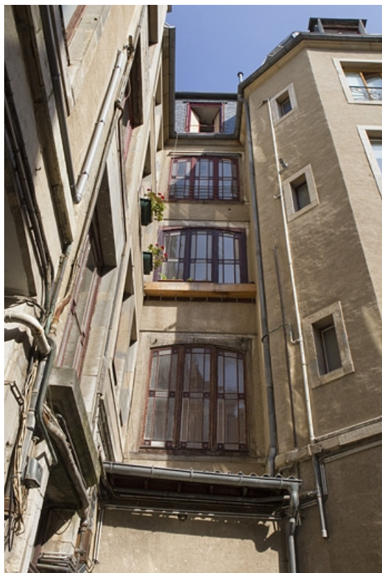
Façade postérieure du logis principal dans la première cour, travée de l'escalier. 25, Besançon Grande Rue 73, lieudit : îlot Saint-Pierre
