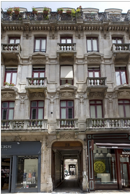
Façade sur rue : détail du rez-de-chaussée au troisième étage.
