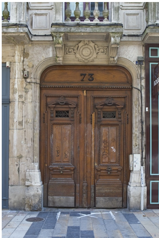
Logis principal, façade sur rue : détail des vantaux du portail d'entrée.
