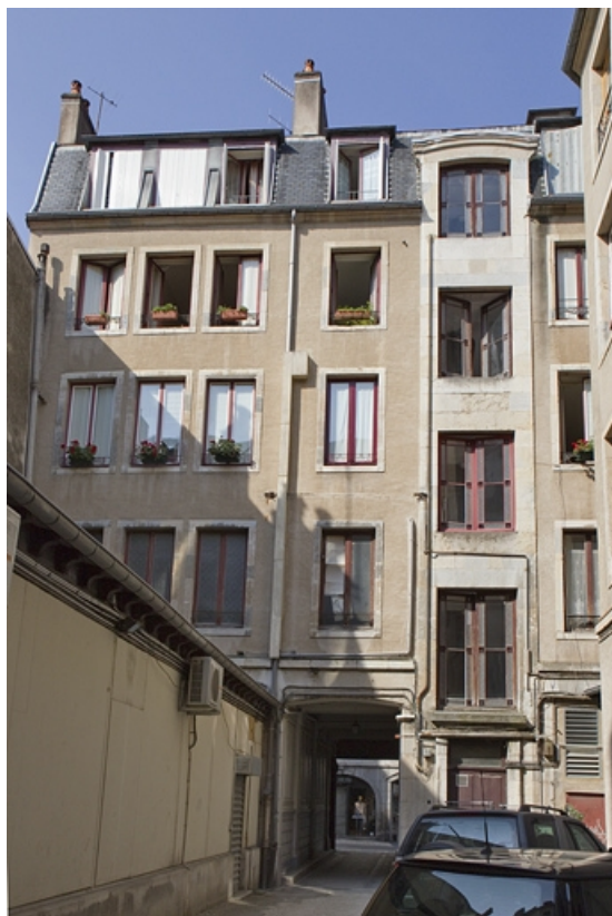
Vue d'ensemble de la façade postérieure du logis principal dans la première cour. 25, Besançon Grande Rue 73, lieudit : îlot Saint-Pierre
