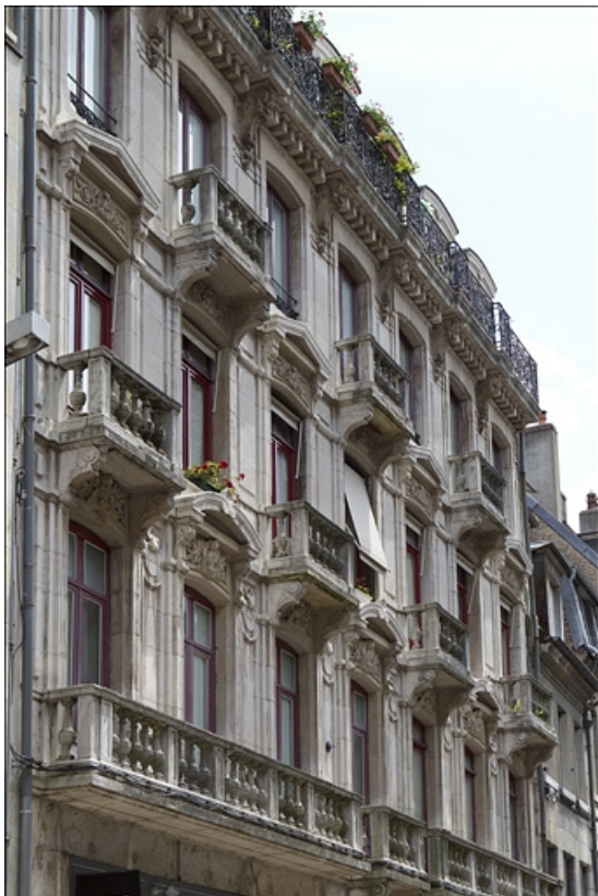
Logis principal, façade sur rue à partir du premier étage : de trois quarts gauche. 25, Besançon Grande Rue 73, lieudit : îlot Saint-Pierre
