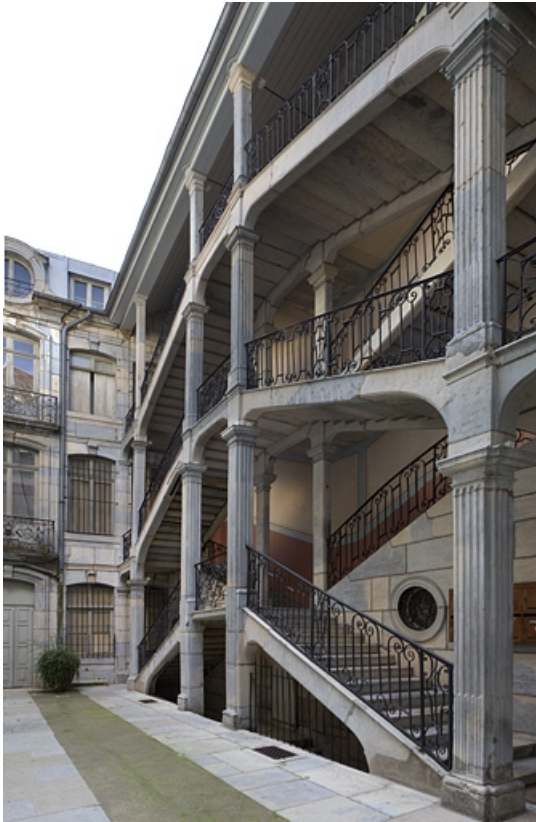
Vue d'ensemble de l'escalier à cage ouverte de trois quarts droit.
