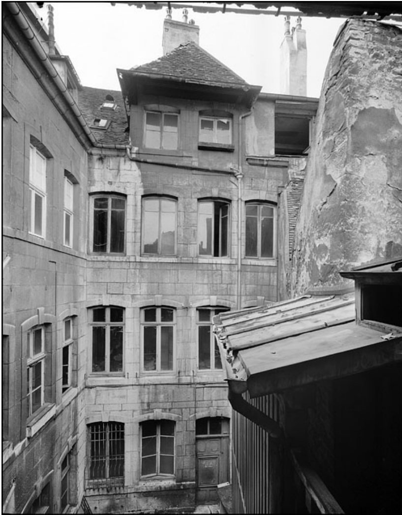
Vue d'ensemble des bâtiments détruits depuis le fond de la deuxième cour, de face. 25, Besançon Grande Rue 67, lieudit : îlot Saint-Pierre
