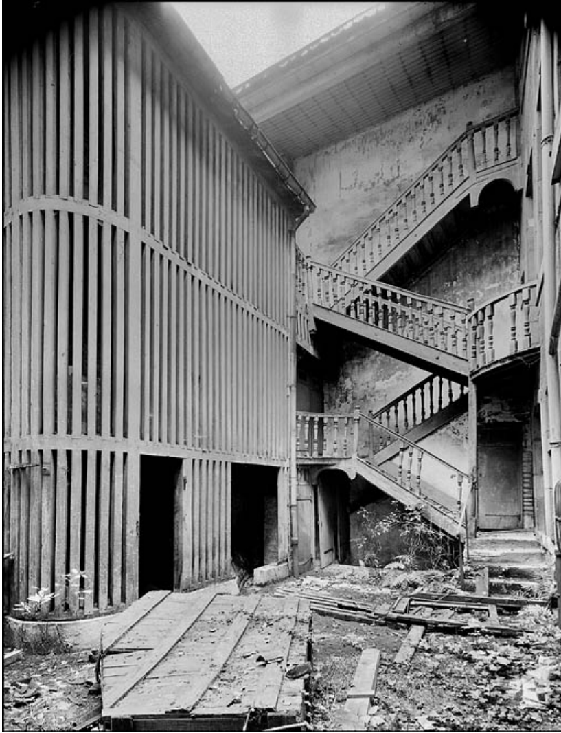
Vue du bûcher et de l'escalier détruits situés dans la deuxième cour. 25, Besançon Grande Rue 67, lieudit : îlot Saint-Pierre
