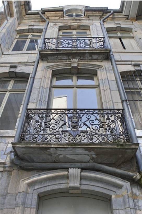
Façade antérieure en fond de cour : détail des balcon de la travée centrale. 25, Besançon Grande Rue 67, lieudit : îlot Saint-Pierre
