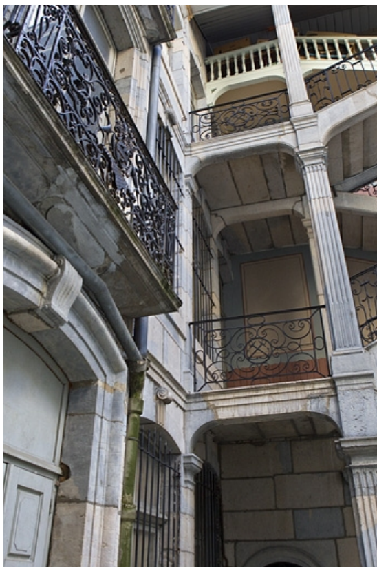
Escalier à cage ouverte : détail de la travée contre la façade du logis en fond de cour. 25, Besançon Grande Rue 67, lieudit : îlot Saint-Pierre
