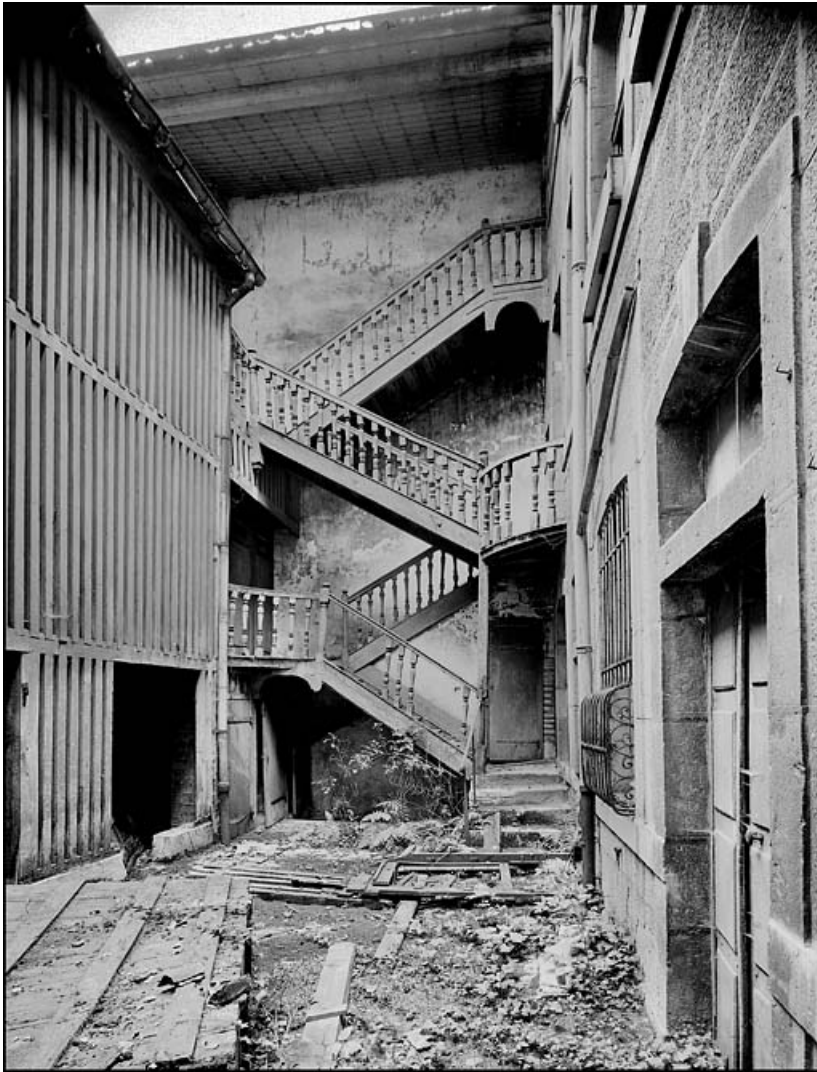
Vue éloignée du bûcher et de l'escalier détruits situés dans la deuxième cour. 25, Besançon Grande Rue 67, lieu dit : îlot Saint-Pierre
