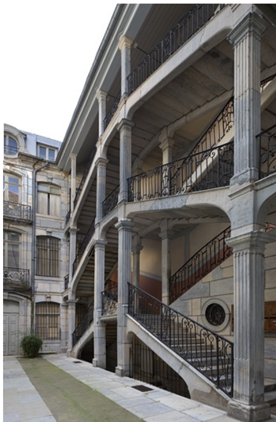
Vue d'ensemble de l'escalier à cage ouverte de trois quarts droit.
