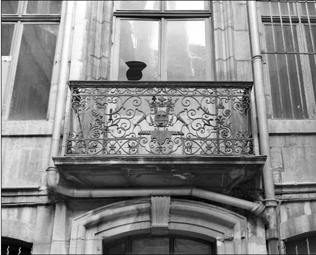
Logis en fond de cour : détail du balcon en ferronnerie.
