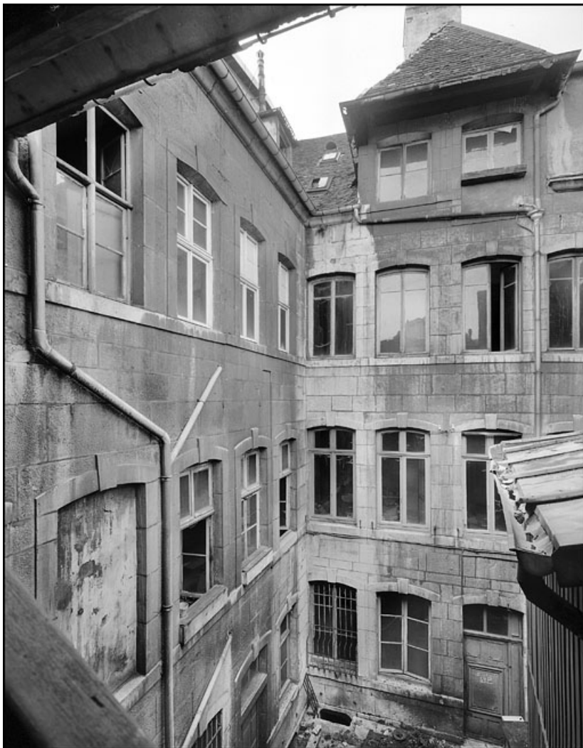
Vue d'ensemble des bâtiments détruits depuis le fond de la deuxième cour, de trois quarts droit. 25, Besançon Grande Rue 67, lieudit : îlot Saint-Pierre
