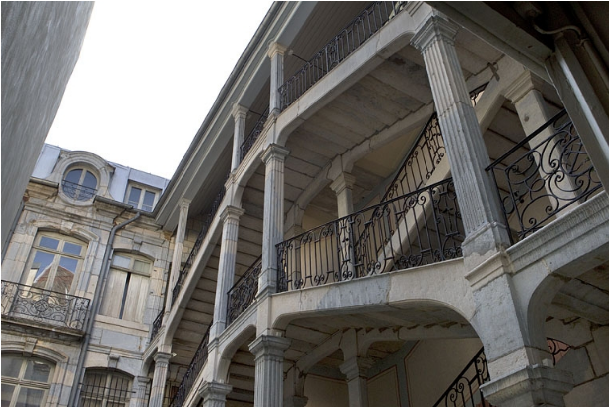
Escalier à cage ouverte : détail de la partie supérieure, de trois quarts droit.
