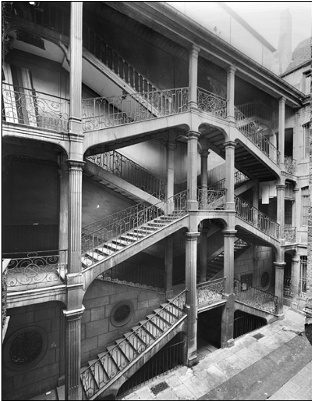
Vue d'ensemble de l'escalier à cage ouverte depuis le fond de la cour.
