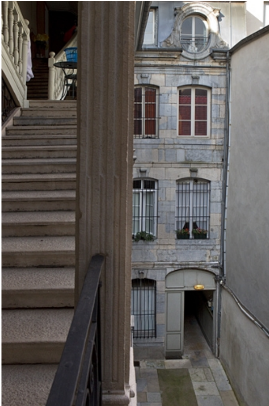
Vue d'ensemble de la façade postérieure du logis sur rue.
