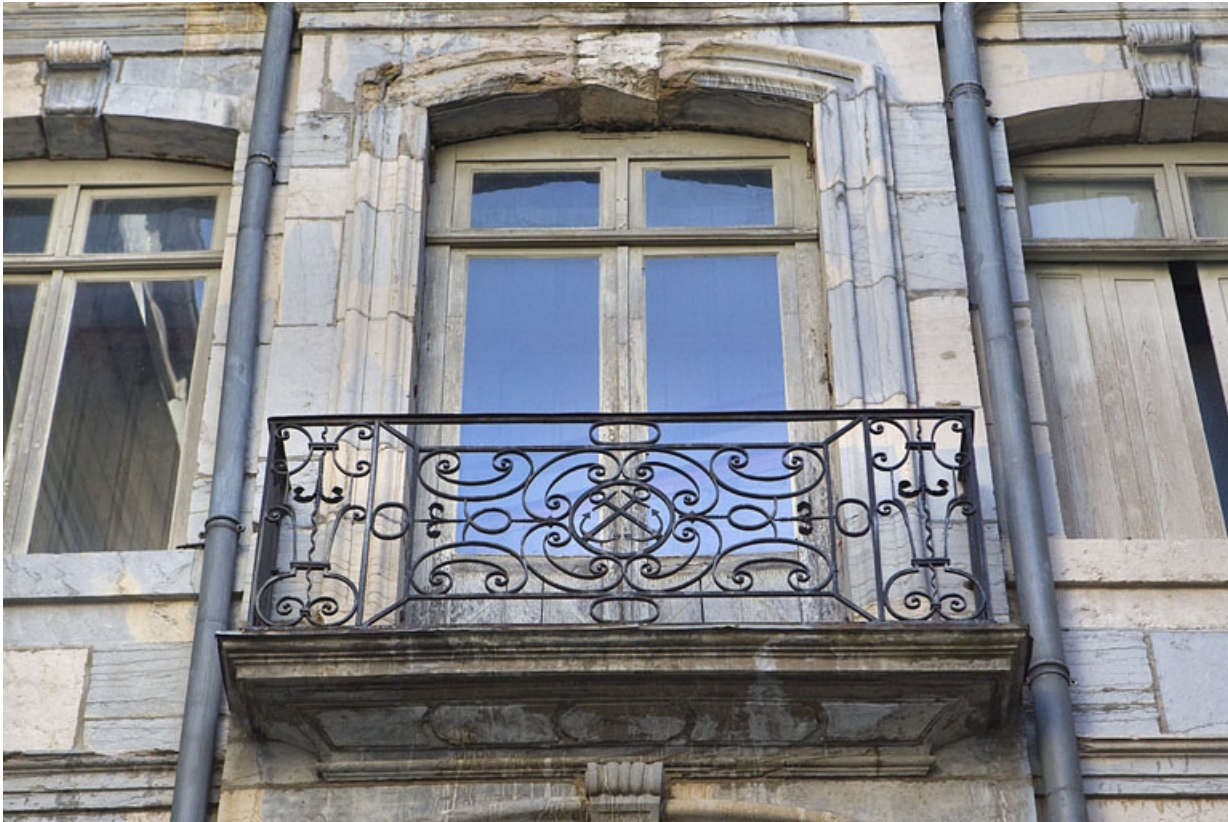
Façade antérieure en fond de cour : détail du balcon du deuxième étage.
