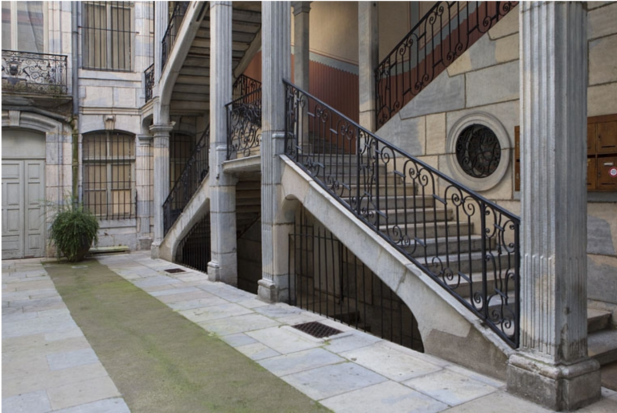
Escalier à cage ouverte : détail du rez-de-chaussée, de trois quarts droit. 25, Besançon Grande Rue 67, lieudit : îlot Saint-Pierre
