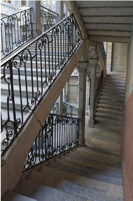
Escalier à cage ouverte : détail de la rampe en fer forgé depuis l'intérieur de l'escalier. 25, Besançon Grande Rue 67, lieudit : îlot Saint-Pierre
