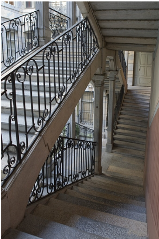
Escalier à cage ouverte : détail de la rampe en fer forgé depuis l'intérieur de l'escalier.
