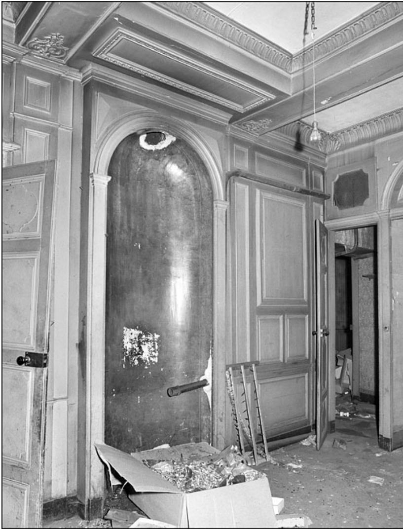
Intérieur : détail d'une niche de poêle, vue éloignée. 25, Besançon Grande Rue 67, lieu dit : îlot Saint-Pierre
