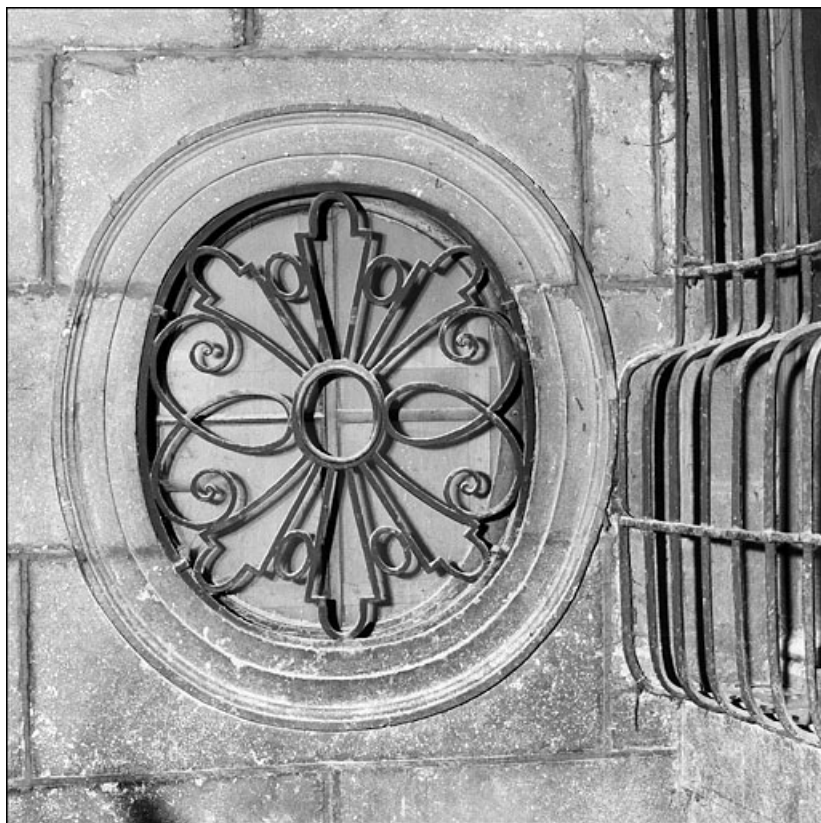
Escalier à cage ouverte : détail d'un oculus, de face.
